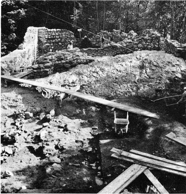
47. Ausgrabung auf dem Burgareal Alt-Schellenberg, Gemeinde Schellenberg/FL. Blick in den Innenraum in Richtung Bergfried, dessen Mauern auf einem stark abgeschroteten Felskopf sitzen (S. 53f.)
