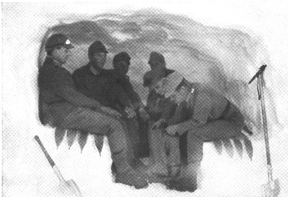
Unterstand in einer Schneewehe, windgepresster Schnee. Arbeitsdauer 25—30 Min. Fassung: 8 Mann; mit 3 Iselin-Schaufeln.
