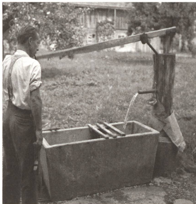
Abb. 6: Bild eines über eine Dünkel-Schwengelpumpe mit Wasser versorgten Sodbrunnens bei Anton Bussmann, Gettnau (Foto: Hans Marti).
