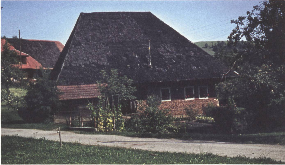
Abb. 3: Katharina Muffs Elternhaus: Die Liegenschaft Ring, genannt «Chäspi-hus», ein Hochstadbau mit Rauchhurd im Dorfzentrum von Altbüron, abgebrochen um 1960. Der kleine Hof lag direkt am Dorfbach. Aufnahme undatiert, vermutlich um 1960. (Heimatvereinigung Wiggertal, Hans Marti Archiv: «Chäspi-hus» Altbüron, Foto Nr. 200299.).
