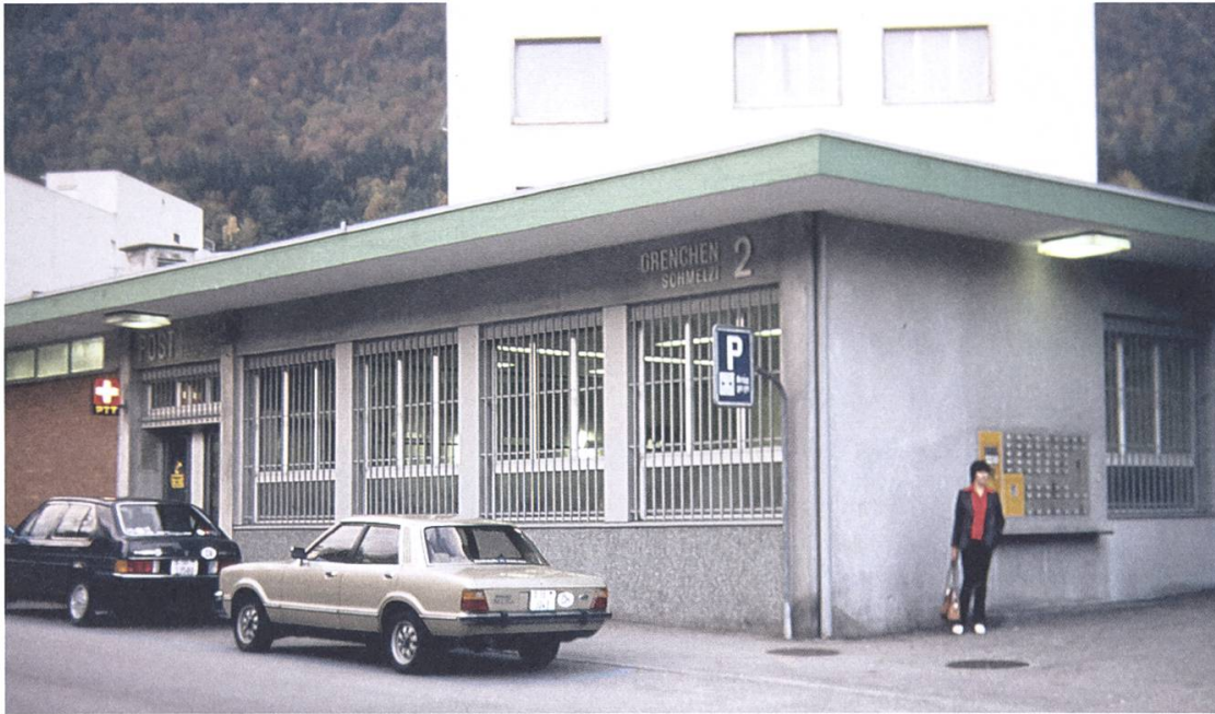
Abb. 25: Postgebäude Grenchen 2, Schmelzi.
