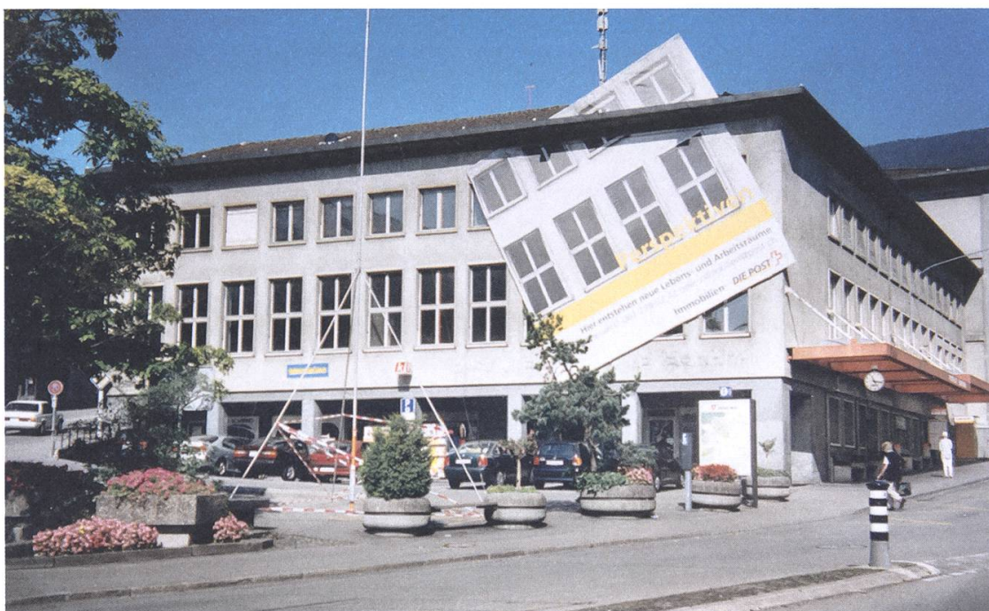
Abb. 20: Bauprofile für das dritte Postgebäude.
