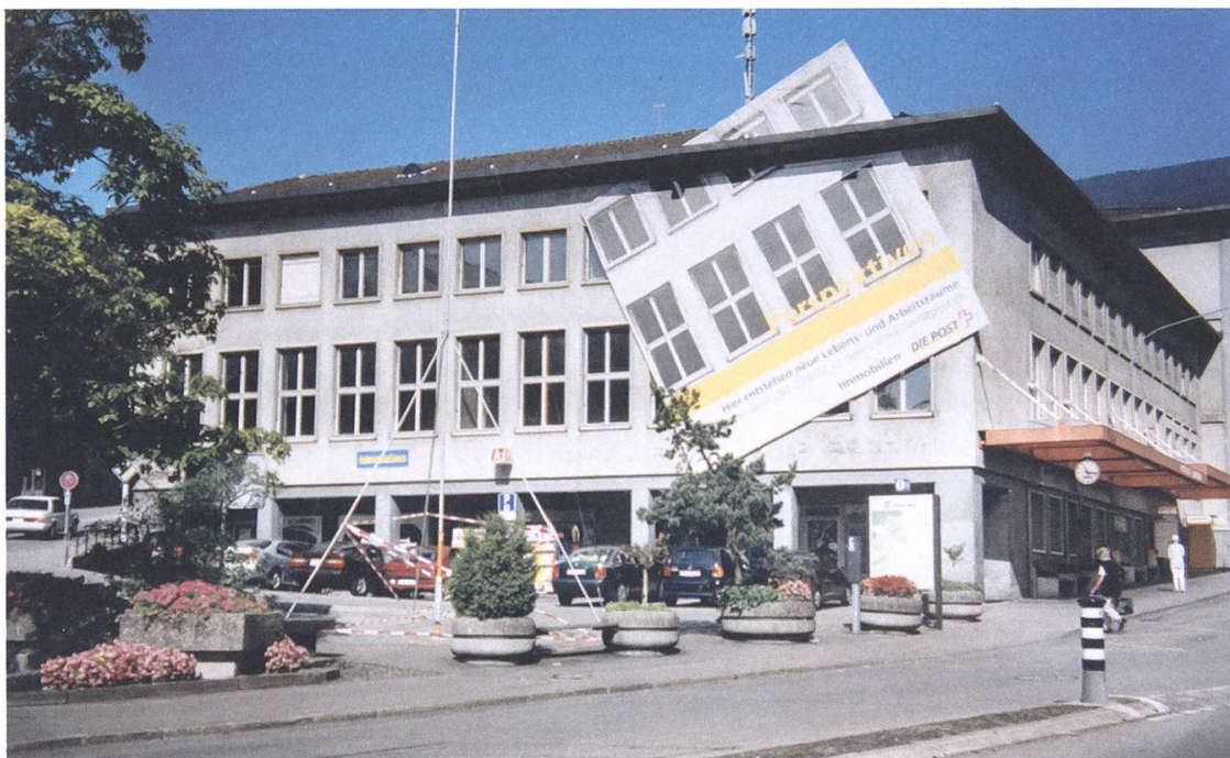
Abb. 20: Bauprofile für das dritte Postgebäude.
