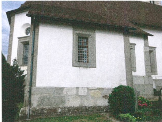
Abb. 5: Detailansicht der Fassade im Bereich der Sakristei und der östlichen Seitenkapelle. Bemerkenswert ist die Verwendung von sog. «Geissberger Gestein» (Findlingsgranit) für den Sockel, die Ecklisenen und die Fenstergehänge.
