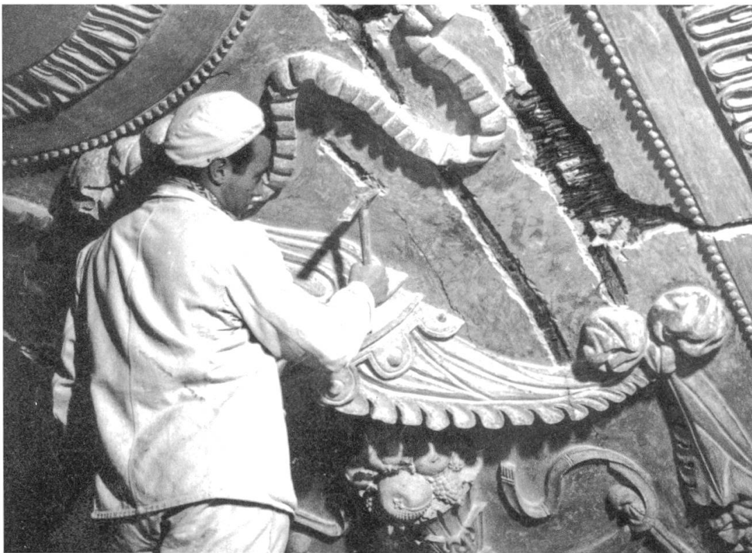
Abb. 20: Gewölbestuckaturen im Kirchenschiff während der Restaurierung 1955–1957. Ein Stuckateur an der Arbeit (Foto: Kantonale Denkmalpflege Solothurn).
