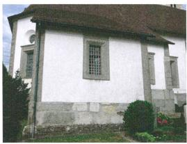
Abb. 5: Detailansicht der Fassade im Bereich der Sakristei und der östlichen Seitenkapelle. Bemerkenswert ist die Verwendung von sog. «Geissberger Gestein» (Findlingsgranit) für den Sockel, die Ecklisenen und die Fenstergewände.
