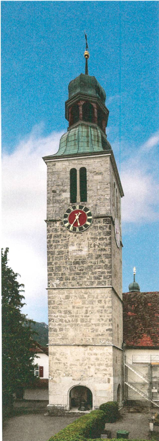
Abb. 4: Turm der Wallfahrtskirche. Das Erdgeschoss mit den Kielbogentoröffnungen und die ersten beiden Obergeschosse stammen aus der Zeit um 1500. Das Glockengeschoss und die barocke Zwiebelhaube wurden 1764 aufgesetzt.
