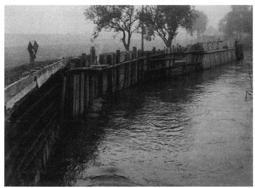
Abb. 16: Bretterverbauung zur Ufersicherung an der alten Dünnern bei Oensingen vor den Korrektionsarbeiten ca. 1933. Kanton Solothurn, Archiv Amt für Umwelt.
