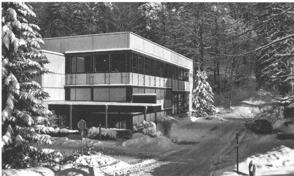
[36] Fabrikgebäude aus dem Jahr 2002.
