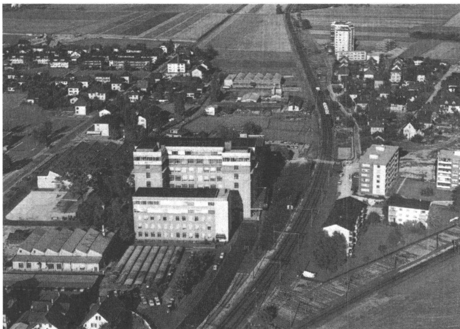
[24] Fabrikgebäude der Scintilla aus dem Jahr 1964.
