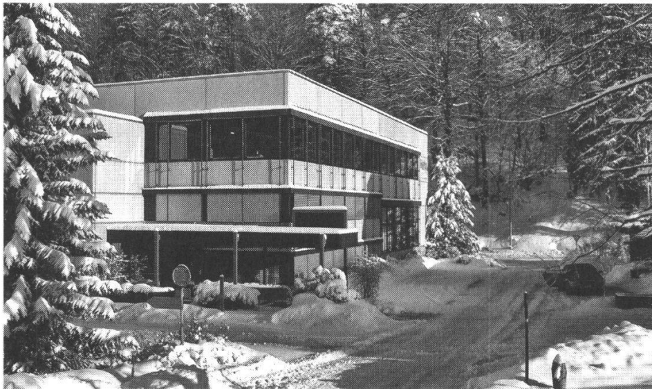
[36] Fabrikgebäude aus dem Jahr 2002.
