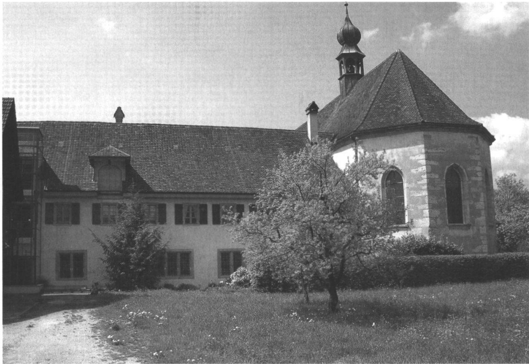
Ostflügel des Klosters und Schwesternchor ab ca. 1997. Ganz links der Aussenlift, der so die alte Gebäudesubstanz am wenigsten verletzt. (Bild: Andreas Röder)
