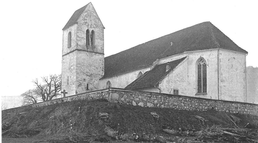
Abb. 6 Die Pfarrkirche im Jahre 1912 (von Südosten). Um den Kirchhof verläuft die 1828 erstellte und 1919 wieder entfernte Friedhofmauer. Unten am Bildrand sind noch Stämme der 1912 gefällten Pappeln erkennbar.
