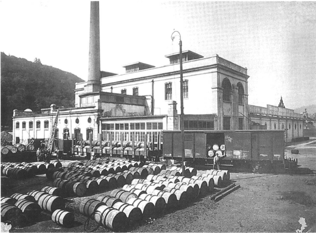
Abb. 25 Ansicht von Osten, 1898. StAOlten FA HVS 02. A 268. Fotoalbum. Unmittelbar bis auf das Fabrikgelände führte das Auszugseleise. Im Vordergrund die offen lagernden Metall- und Holzfässer mit Talg und Öl, die 1900 überdacht wurden.
