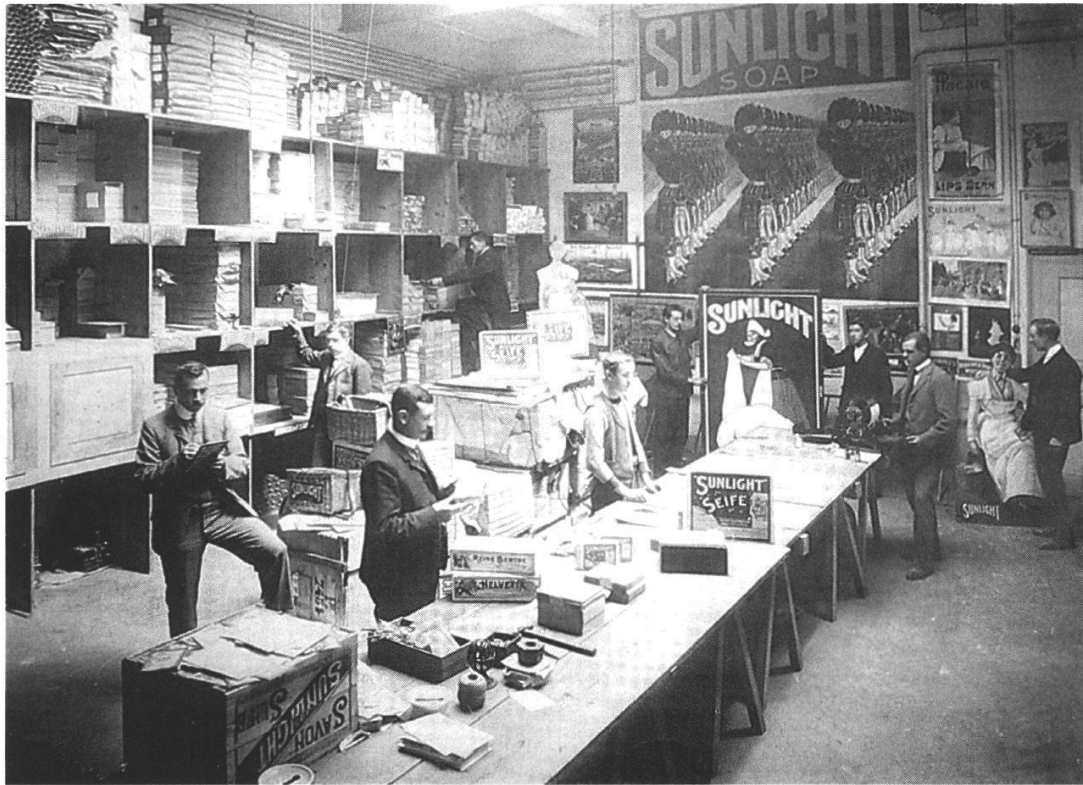
Abb. 47 Werbeabteilung Sunlight, 1898. StAOlten FA HVS 02. A 267. Foto. An der hinteren Wand ist das an der Expo 1896 gezeigte Plakat zu sehen.
