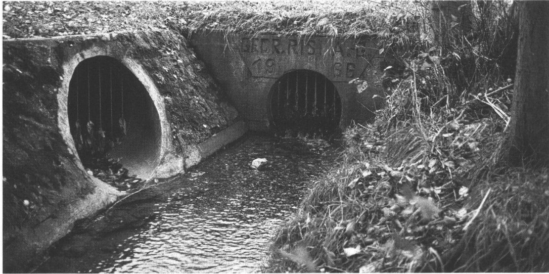
Abb. 4: Der Hardgraben kommt in Neuendorf ans Tageslicht. (Foto: C. Stöckli)
