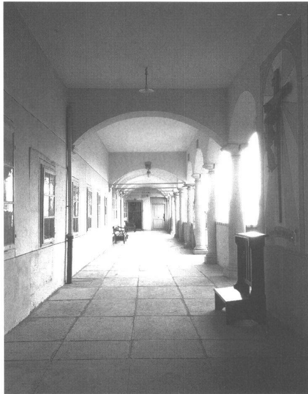
Abb. 4: Laubengang im Parterre, um 1940.
