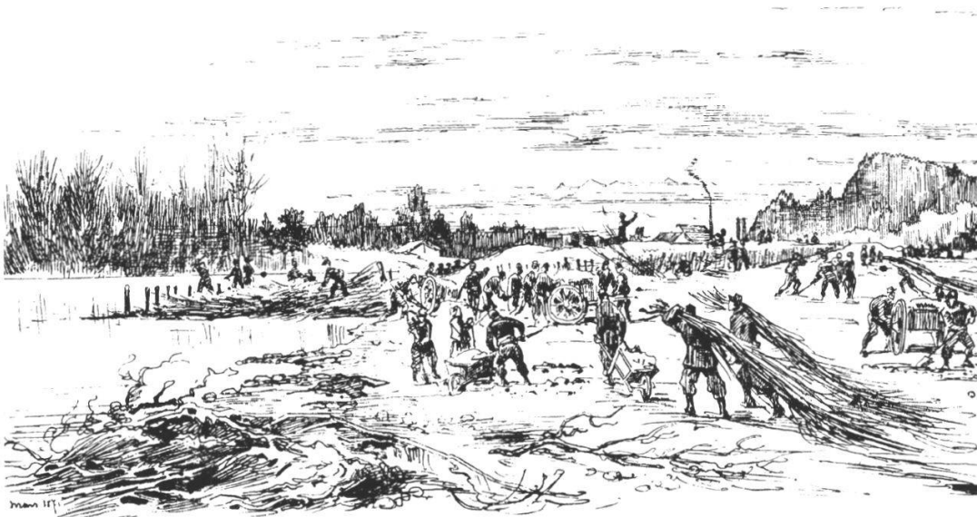
Abb. 15: Bourbakisoldaten arbeiten an der Emme. Aus: «Aux Frontières», A. Bachelin.
