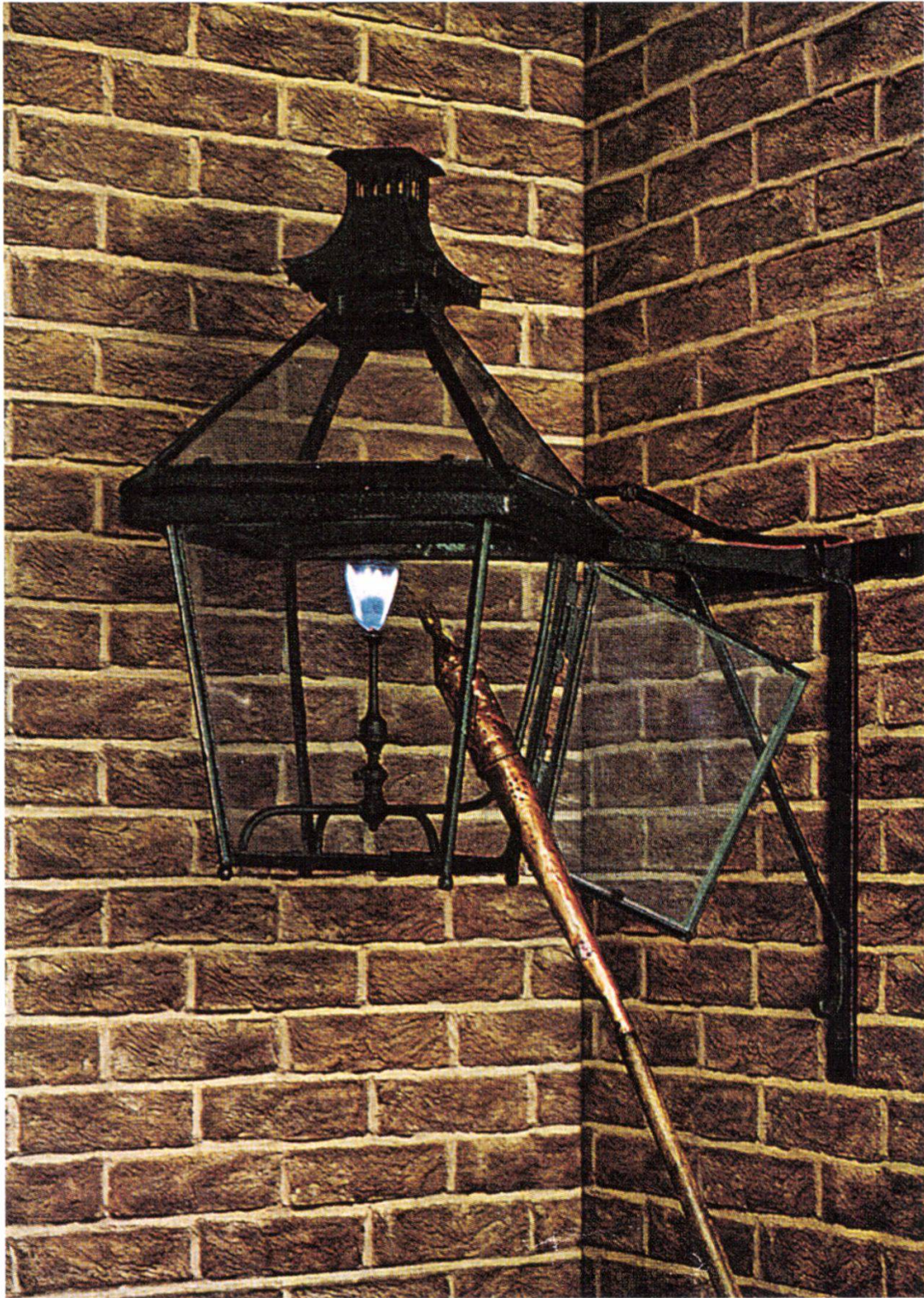
Abb. 49: Die Aufnahme zeigt sehr schön die Flamme eines Schmetterlingsbrenners und den Anzünd- und Löschstock (Quelle: Museum of Science, London, 1970).
