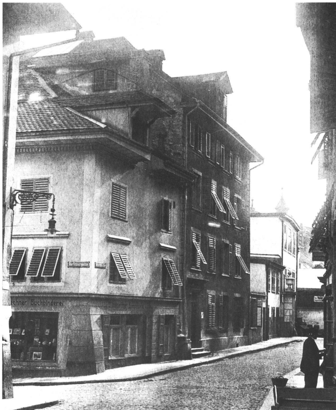
Abb. 44: Die Laterne an der Barfüssergasse. Diese Laterne mit Hängebrenner an einer Konsole befindet sich an der Barfüssergasse, dort, wo sie in einem rechten Winkel nach rechts abbiegt («Scharfe Egge»). Der Blick geht in die Weberngasse. Oberhalb der Laterne sieht man wiederum den kreisförmigen BAMAG-Fernzündler. Die Lampe datiert deshalb von 1906/07. Ob sie zweiflammig ist, lässt sich anhand der Foto nicht entscheiden.
