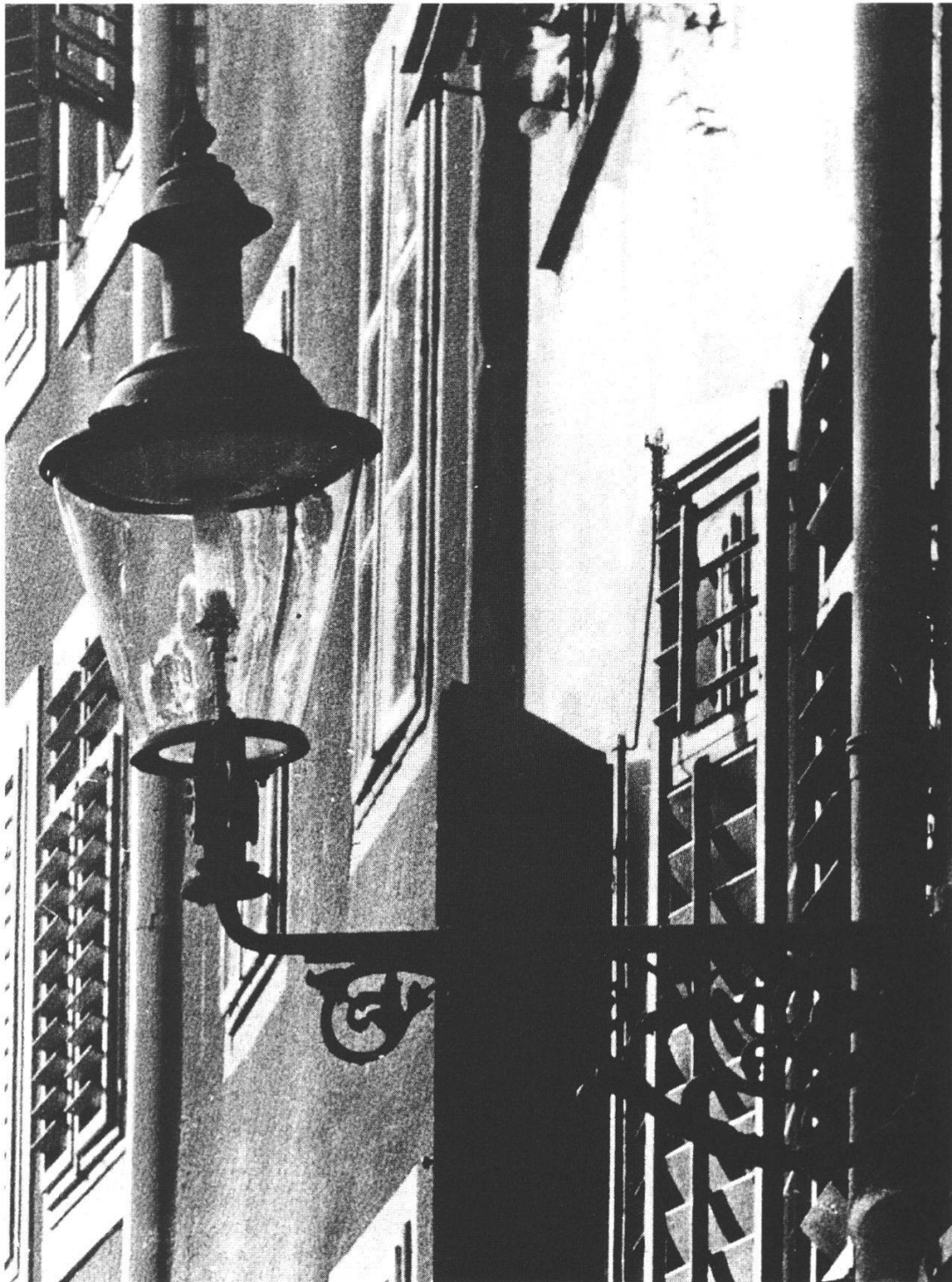
Abb. 42: Diese nächste Laterne lässt sich nicht lokalisieren, besser gelingt die Datierung. Wir zeigen die Foto, weil an ihr Details erkennbar sind. Es handelt sich um eine Rundmantellaterne mit Auerglühlichtbrenner. Unterhalb des Mantels erkennen wir den BAMAG-Fernzünder. Wir wiederholen: Rundmantellaternen der Schweizerischen Gasapparatefabrik Solothurn wurden 1906/07 montiert, die Fernzünder 1905. Nach dem Prospekt der Gebr. J. u. C. Schneider, Hamm (Westfalen), beträgt die ganze Höhe einer Laterne ohne Bügel 80 cm. Der Glasmantel ist 380–400 mm hoch, der obere Durchmesser 390, der untere 220 mm. Wandarme werden offeriert mit Ausladungen von 73 cm, Gewicht 16 kg und Ausladung 93 cm, Gewicht ca. 20 kg. Die von Schneider offerierten Kandelaber haben Höhen zwischen 3 m und 3.15 m.
