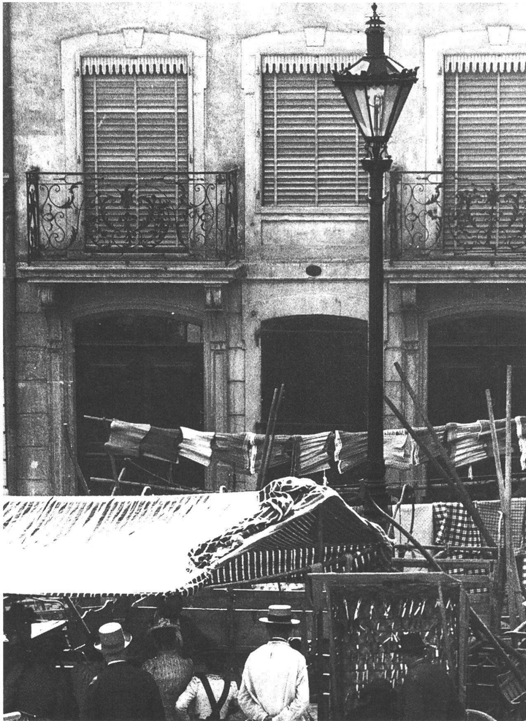
Abb. 35: Im Hintergrund steht das Haus Hauptgasse 48. Die Laterne zeigt einen Doppelbrenner (2 Becs). Die Glasverkleidung besteht aus einzelnen Scheiben. Rundmantel, Auerbrenner und BAMAG-Fernzünder fehlen noch. Erste Auerbrenner wurden vom Gaswerk Solothurn am 25. November 1897 vorgeschlagen und 1898 eingerichtet. Rundmantellaternen der Schweizerischen Gasapparatefabrik in Solothurn wurden 1906/07 eingerichtet. Die Fernzünd- und Löschapparate BAMAG stehen seit dem 1. August 1905 im Betrieb. Die Fotografie dürfte nach unseren verfügbaren Angaben und Überlegungen zwischen 1880 und 1890 entstanden sein. Nach unserem Dafürhalten zeigt die Abbildung eines der ersten Modelle einer Gaslaterne (Riedinger, 1860?) Auffallend ist der grosse Kamin, der für den stündlichen Abzug von 170 Liter verbranntem Leuchtgas zu sorgen hat. Auf die Bedienung der Laterne gehen wir unter dem Titel: Laternenanzünder, ein. Die Foto dürfte an einem Markttag aufgenommen worden sein: Marktstände, Karren und Leute mit Strohhüten sind auf engem Raume versammelt.
