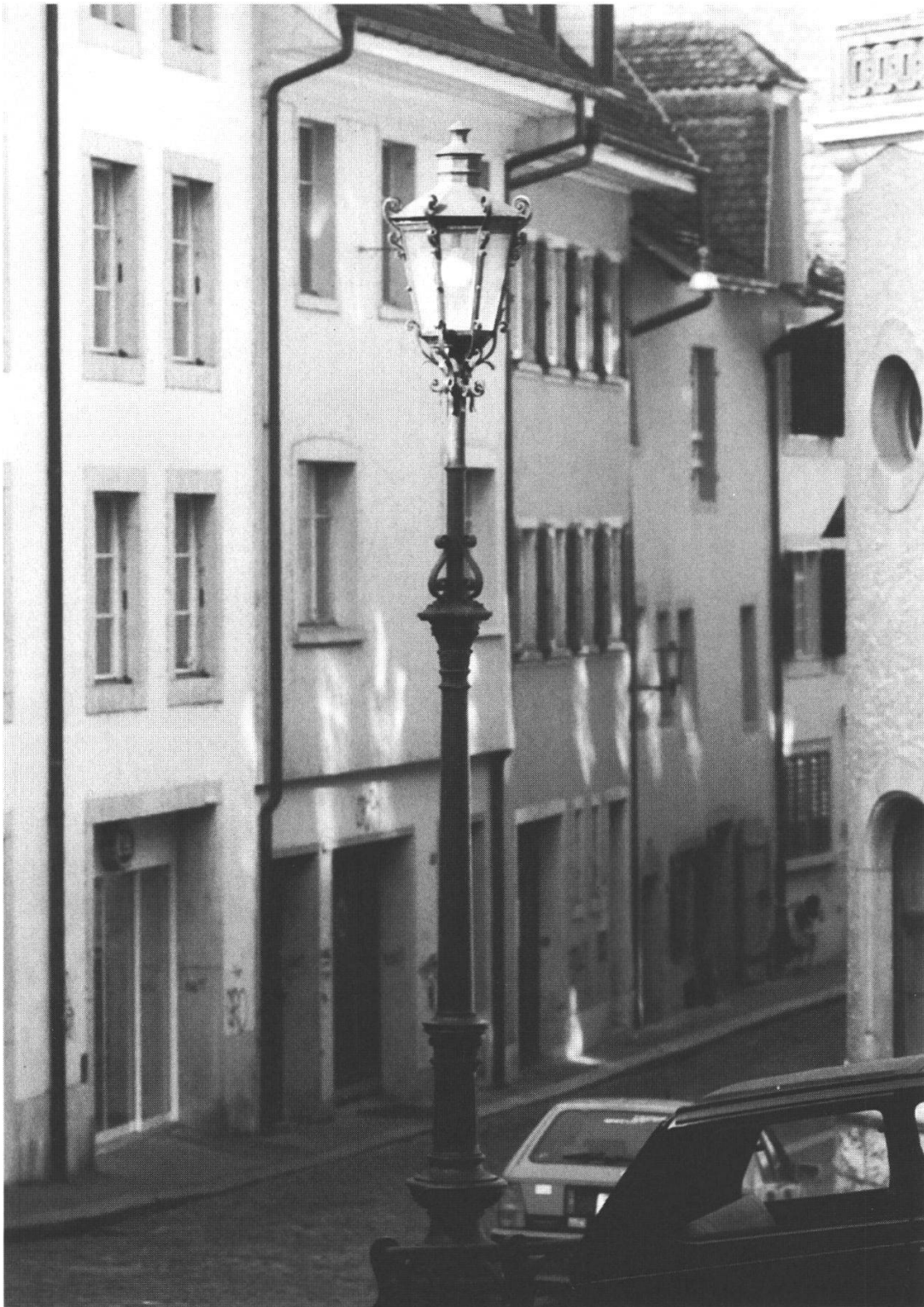
Abb. 37: Dieses Foto (Moser 1993) zeigt den heutigen Zustand der Beleuchtungsanlage. Der Kandelaber ist elektrifiziert und um ein Zwischenstück verlängert. Der gemeisselte Sockel besteht aus Gneis. Am Fuss des gusseisernen Kandelabers ist der Hersteller vermerkt: Eisenwerk Clus. (Man vergleiche den erbärmlichen Zustand der Fassaden um 1900 mit den renovierten Gebäuden um 1993 (Autos ersetzen den Milchkarren!).
