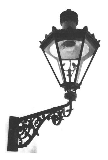
Abb. 53: Elektrische Zündung. Die Abbildung zeigt eine Gaslaterne (Berlin 1904) mit elektrischer Zündung. Der Gasdruckregler befindet sich unterhalb des Gehäuses (Quelle: Siemens Museum München, 1991).
