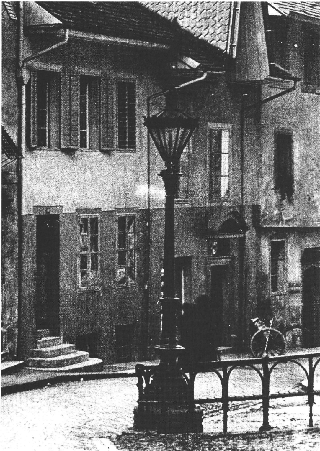
Abb. 36: Die Foto ist mit 1916 datiert. Da aber die Laterne noch keinen Rundmantel als Windschutz besitzt, muss die Foto rückdatiert werden, vor 1906/07. Es ist nicht auszumachen, ob die Laterne einen Auerglühstrumpf besitzt (1898). Sonst liesse sich das Datum genauer ermitteln.
