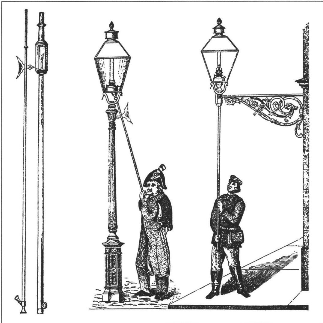
Abb. 46: Laternenanzünder, Ende 19. Jahrhundert. Quelle: Wechsler-Kümmel, Schöne Lampen , Heidelberg. Links im Bilde sehen wir das Ausblasrohr und den Regulator, rechts daneben den Anzündstock mit der Stangenlaterne, mit welcher von der Strasse aus durch die Bodentüre der Laternen der Brenner erreicht wurde. Die Stangenlaterne enthält ein Ölgefäss mit Docht. Ihre Flamme entzündete das Leuchtgas, nachdem der Hahnenschlüssel geöffnet worden war. Die Flamme wurde dann entweder ausgeblasen oder durch Schliessen des Gashahns zum Erlöschen gebracht. Die Laterne rechts im Bilde besitzt eine Konsole, die linke Laterne einen Kandelaber als Träger.
