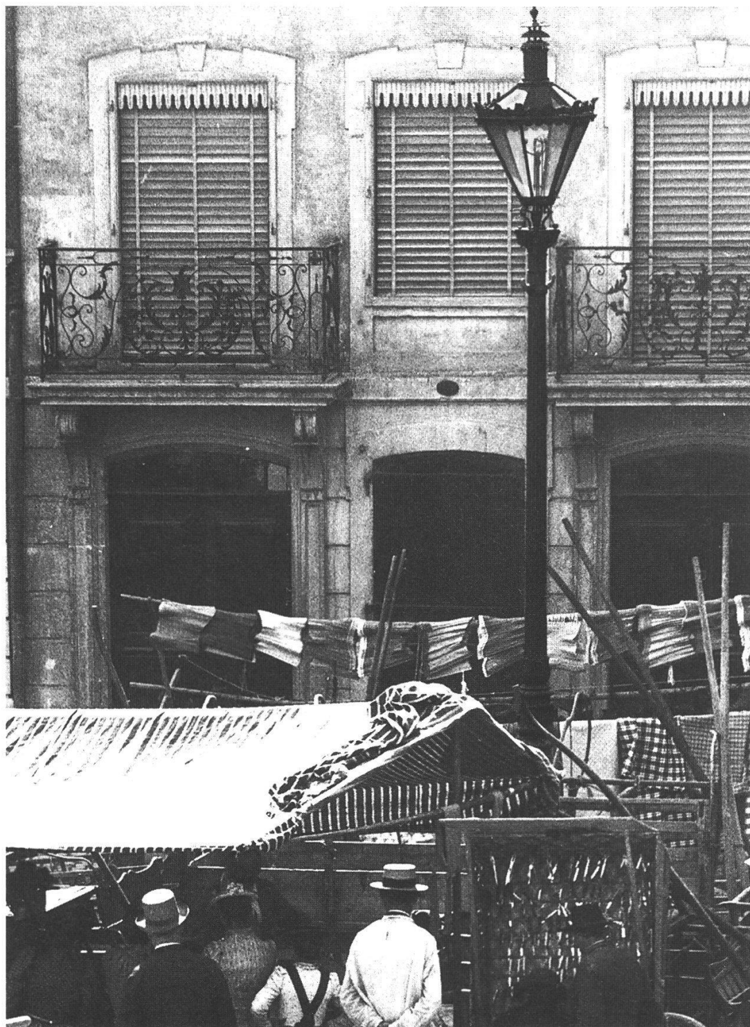
Abb. 35: Im Hintergrund steht das Haus Hauptgasse 48. Die Laterne zeigt einen Doppelbrenner (2 Becs). Die Glasverkleidung besteht aus einzelnen Scheiben. Rundmantel, Auerbrenner und BAMAG-Fernzünd- und Löschapparate fehlen noch. Erste Auerbrenner wurden vom Gaswerk Solothurn am 25. November 1897 vorgeschlagen und 1898 eingerichtet. Rundmantellaternen der Schweizerischen Gasapparatefabrik in Solothurn wurden 1906/07 eingerichtet. Die Fernzünd- und Löschapparate BAMAG stehen seit dem 1. August 1905 im Betrieb. Die Fotografie dürfte nach unseren verfügbaren Angaben und Überlegungen zwischen 1880 und 1890 entstanden sein. Nach unserem Dafürhalten zeigt die Abbildung eines der ersten Modelle einer Gaslaterne (Riedinger, 1860?) Auffallend ist der grosse Kamin, der für den stündlichen Abzug von 170 Liter verbranntem Leuchtgas zu sorgen hat. Auf die Bedienung der Laterne gehen wir unter dem Titel: Laternenanzünder, ein. Die Foto dürfte an einem Markttag aufgenommen worden sein: Marktstände, Karren und Leute mit Strohhüten sind auf engem Raume versammelt.
