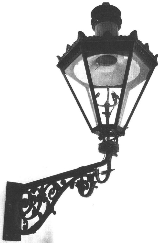
Abb. 53: Elektrische Zündung. Die Abbildung zeigt eine Gaslaterne (Berlin 1904) mit elektrischer Zündung. Der Gasdruckregler befindet sich unterhalb des Gehäuses (Quelle: Siemens Museum München, 1991).
