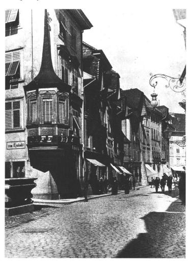
Abb. 86: An der Hauptgasse 22, elektrische Bogenlampe. Während bei der ersten Foto ein nüchterner Zylinder das komplizierte Innere der Bogenlampe verhüllt, ist hier der obere Rand des Zylinders jugendstilhaft mit einem gegliederten Kranz geschmückt. Die Gaslaterne hat in der Zwischenzeit keinen Fortschritt erfahren. Sie besitzt nach wie vor keinen Auerbrenner, ebenso fehlt die BAMAG-Zündvorrichtung. Die Bogenlampe hat offenbar jede Veränderung der Gaslaterne überflüssig gemacht.
