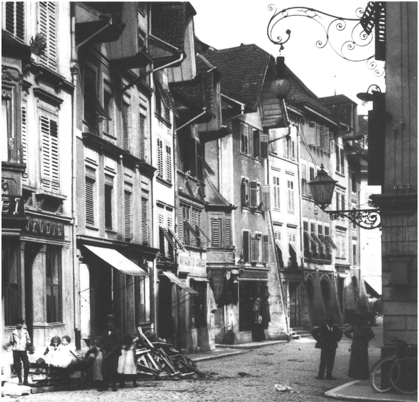
Abb. 85: Die erste Bogenlampe. Die Foto aus der Zentralbibliothek zeigt die im «Solothurner Anzeiger» besprochene Bogenlampe. (1. Modell, Herkunft unbekannt, Alioth?). Sie ist an einer weitausladenden Konsole in der Höhe des zweiten Stockes aufgehängt. Auf der Höhe des 1. Stockes sind zwei elektrische Glühlampen erkennbar, über den Velos ist der Schaltkasten angebracht mit den fünf abgehenden Leitungen. Auf der Höhe des Gesimses führen zwei lose herunterhängende Drähte zur Bogenlampe. Diese sind beweglich angeordnet, damit die Bogenlampe zur Revision an der Rolle auf die Strasse heruntergelassen werden konnte. Das über die Rolle führende Kabel ist auf der Foto nicht sichtbar. Diese Details sind besser erkennbar auf der Foto der Bogenlampe beim Hotel «Krone» (s.d.). Oberhalb des Gesimses erkennt man nur noch drei Drähte. Auf der Höhe der oberen zwei Isolatoren erkennt man die Leitungen, die zu den zwei Glühlampen führen. Zwei Leitungen gehören zur Beleuchtung des Gebäudes. Sie werden ausserhalb des Hauses hochgeführt. Die Foto ist von besonderer historischer und technischer Bedeutung, weil zwei Generationen von Beleuchtungskörpern abgebildet sind.
