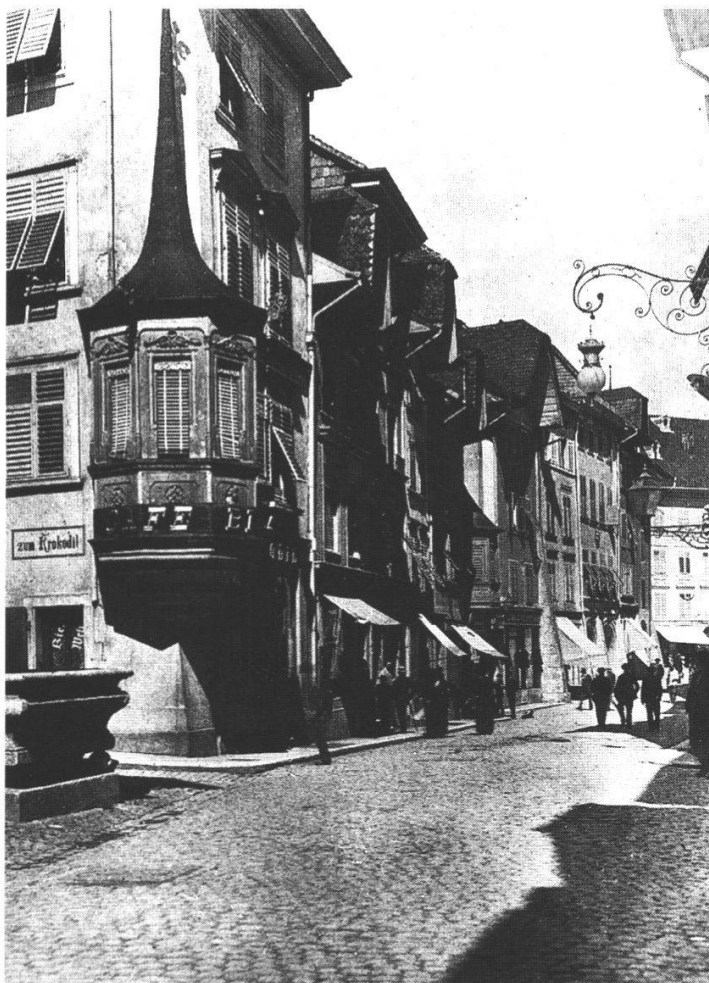
Abb. 86: An der Hauptgasse 22, elektrische Bogenlampe. Während bei der ersten Foto ein nüchterner Zylinder das komplizierte Innere der Bogenlampe verhüllt, ist hier der obere Rand des Zylinders jugendstilhaft mit einem gegliederten Kranz geschmückt. Die Gaslaterne hat in der Zwischenzeit keinen Fortschritt erfahren. Sie besitzt nach wie vor keinen Auerbrenner, ebenso fehlt die BAMAG-Zündvorrichtung. Die Bogenlampe hat offenbar jede Veränderung der Gaslaterne überflüssig gemacht.
