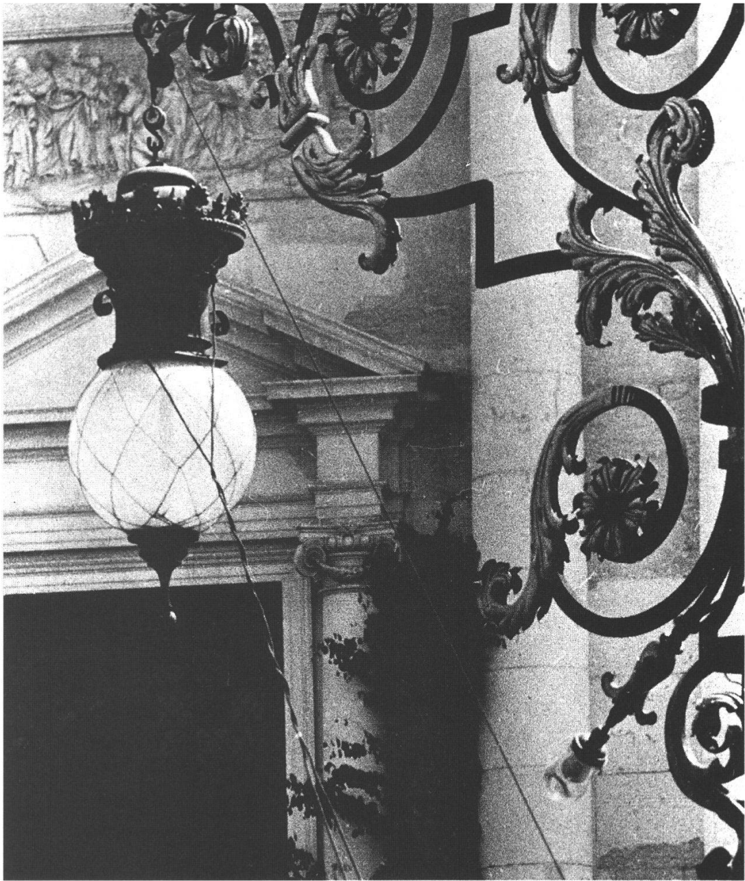
Abb. 88: Bogenlampe Hotel «Krone», Detailaufnahme. Die Aufnahme zeigt das zweite Modell einer Bogenlampe in Solothurn (Gleiche Lampe wie 2. Foto Hauptgasse 22). Die Bogenlampe hängt an einem kunstvoll geschmiedeten Wandarm. Die Abbildung zeigt wichtige Einzelheiten: Die Glaskugel, die den Flammenbogen vor dem Auslöschen durch den Wind schützt, besteht aus Opalglas. Sie ist von einem Drahtnetz umgeben, das entstehende Glassplitter auffangen soll. Das Opalglas sorgt für gleichmässige Lichtstreuung. Unterhalb der Glaskugel befindet sich der Aschensammler. Er fängt die bei der Verbrennung der Kohlenstäbe entstehende Asche auf. Der jugendstilhafte Metallaufsatz ist durchbrochen und muss die Verbrennungsgase ableiten. (Die Bogenlampe hat übrigens ihre Bezeichnung vom Flammenbogen zwischen den Kohlenstäben und nicht etwa von der Form der Lampe). Oberhalb der Bogenlampe erkennt man einen Haken, an dem sie aufgehängt ist. Über eine Rolle führt ein Drahtseil, an dem die Bogenlampe auf den Erdboden heruntergelassen werden kann, um die Kohlenstäbe zu ersetzen und die Lampe zu reinigen. Zwei zusammengedrehte Kabel leiten den elektrischen Strom von 125 Volt Spannung zu den Kohlenstäben. Rechts im Bild und zu unterst am Wandarm, erkennt man noch eine Glühlampe. Das Relief im Hintergrund gehört zur Frontseite der St. Ursenkirche, erbaut 1763–1772.
