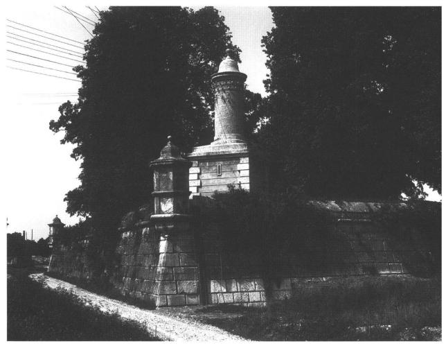
Abb. 76: Die Foto (Denkmalpflege Solothurn. Negativ Museum Blumenstein) zeigt einen Teil der Turnschanze mit zwei Erkern und der grossen, zweiten Transformatorenstation mit Isolatoren und Leitungen vor dem Abbruch des Schänzlis im Jahre 1905. Vor der Trafostation mit Turm, der als Leitungsmast diente, ist der Erker zu sehen, der die erste Trafostation (1895) enthielt. (Bild S. 211.).
