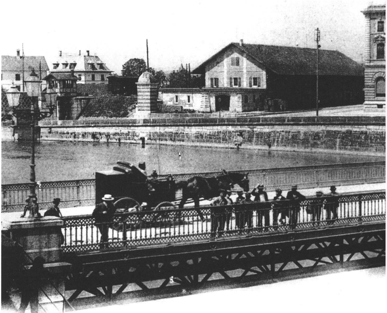
Abb. 43: Wengibrücke. Die Foto mit der Wengibrücke (Postkarte), bis 1898 Obere Brücke, zeigt noch die ursprüngliche Eisengitterkonstruktion, ebenso die Eisenbahnbrücke (1857). Die Aufnahme muss nach 1894 gemacht worden sein, da sie das in diesem Jahre erbaute Postgebäude zeigt. Am Brückenkopf, links im Vordergrund, sind Kandelaber mit 3 Laternen auszumachen. Von Interesse sind auch die Kutsche und die Zuschauer.
