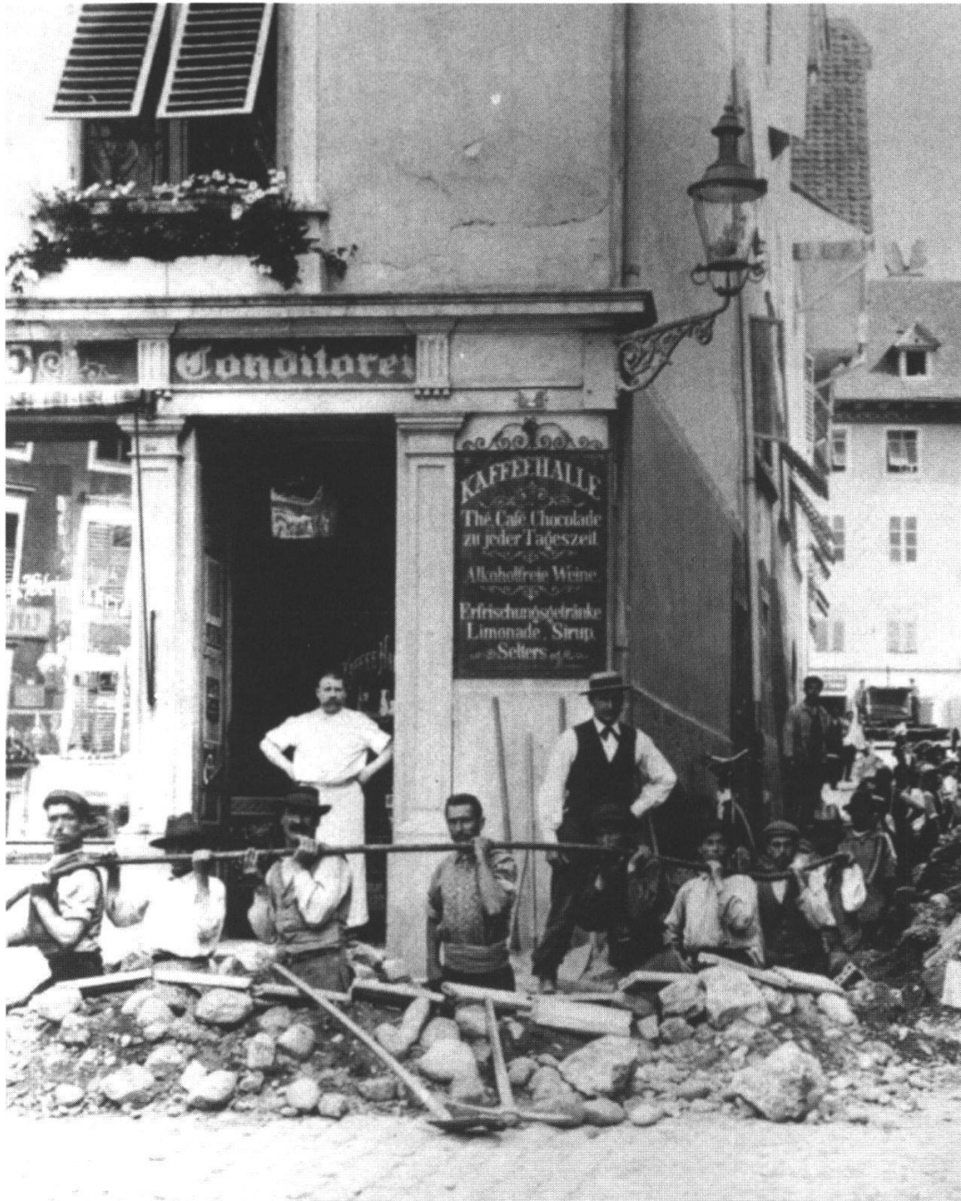
Abb. 77: Die Foto von der Kabelverlegung vom Riedholzturm (Majorenloch) zum Transformator im Bieltor zeigt die Kabelverlegung durch die Barfüssergasse herunter zum Marktplatz (Ecke ehemalige Konditorei Zurmühle). Auffallend ist die grosse Anzahl von Arbeitern, die bei der Verlegung beschäftigt ist. Das Kabel hatte eine Länge von 407 m (Foto EWS).
