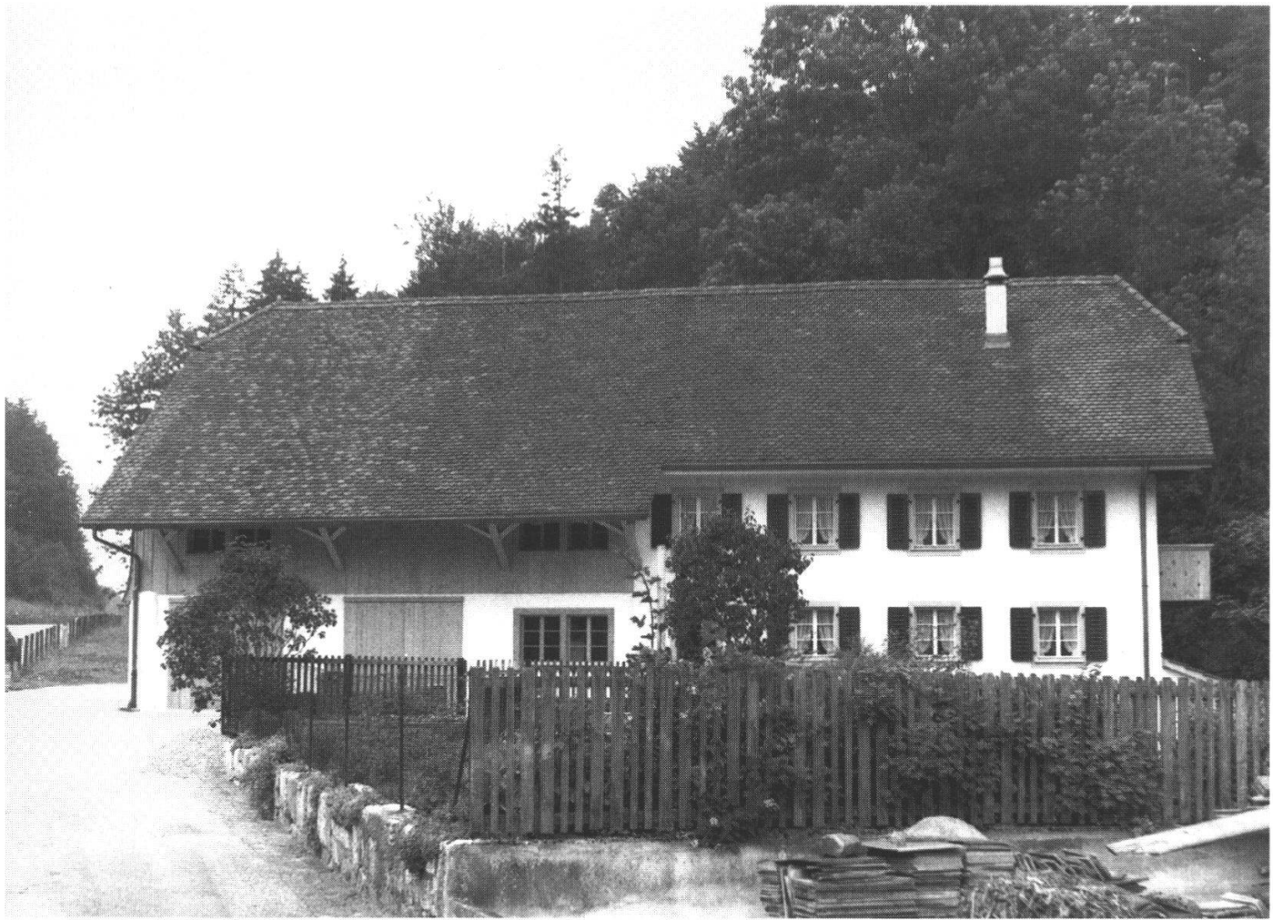
Abb. 1: Gesamtansicht der Lochmühle am Hammerrain nach der Restaurierung.
