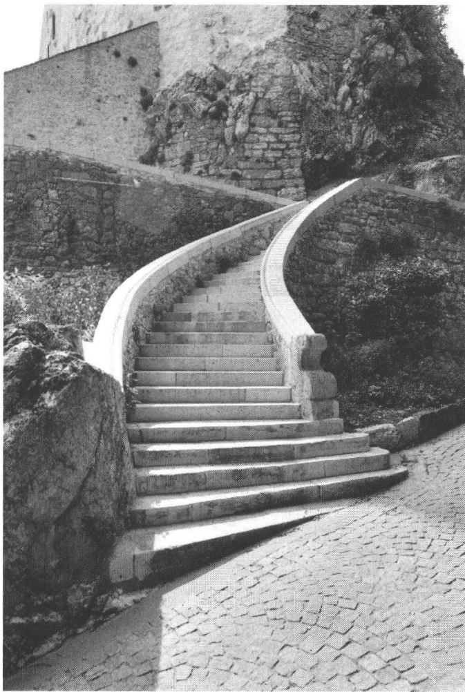
Abb. 1: Barocke Treppe von 1751.
