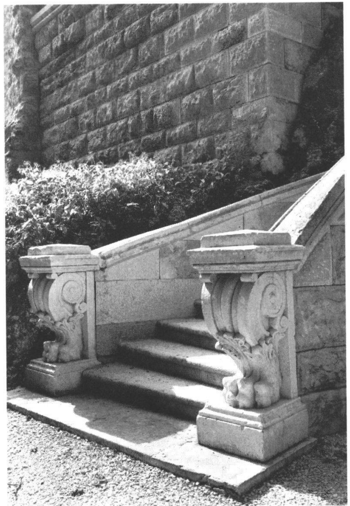
Abb. 4: Postamente der unteren Treppenanlage.
