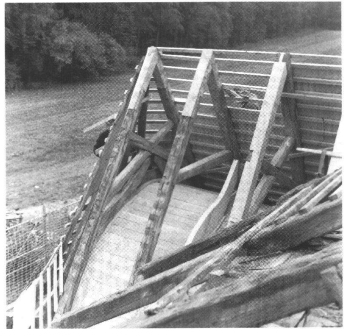
Abb. 10: Dachuntersicht des Hauptdaches mit profilierten Stichbalken.
