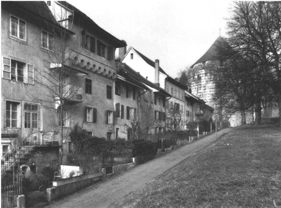
Abb. 6: Solothurn, Ostabschnitt der mittelalterlichen Befestigung. Am Bastionsweg, Blick nach Nordwesten. Links ist im Geschoss über dem verputzten Blendbogenfries ein spätmittelalterlicher Obergaden aus der Zeit um 1450 erhalten geblieben. (Dendroproben 393 SO – 398 SO)
