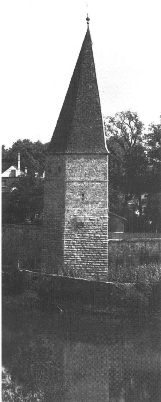
Abb. 4: Der Krummturm in der Solothurner Vorstadt ist identisch mit dem in zeitgenössischen Quellen von 1462/63 «nüwen Thurn in der Vorstatt» genannten Bau. Seine Sockelpartie mit Kalksteinbossenquadern stammt noch aus dem 13. Jahrhundert, die Obergeschosse aus Tuffquadern sind 1462/63 aufgesetzt worden. (Dendroproben 289 SO – 306 SO)
