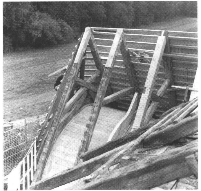
Abb. 10: Dachuntersicht des Hauptdaches mit profilierten Stichbalken.
