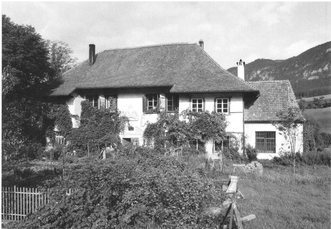
Abb. 1: Gesamtansicht des Ischenhofes von Süden mit der Kapelle (rechts).
