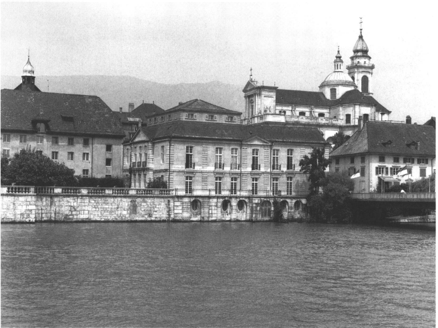
Abb. 1: Solothurn, Palais Besenval, Südseite. Im Keller des Südflügels, unter der rechten Hälfte der Südfassade, befinden sich Turmreste zur unteren Schiffflände.
