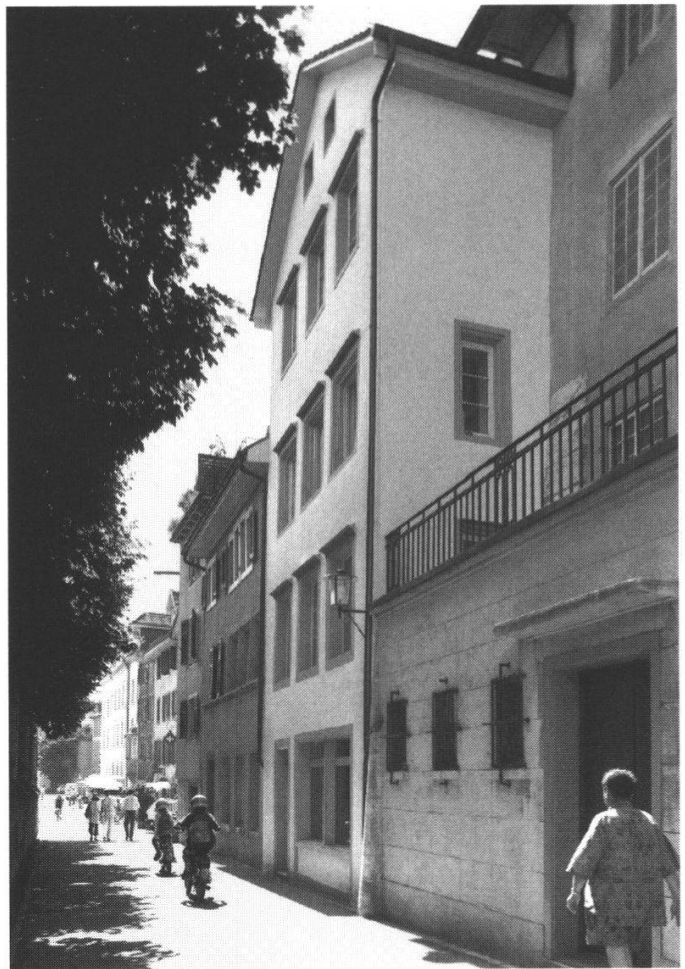
Abb. 2: Die Südfassade nach der Restaurierung.
