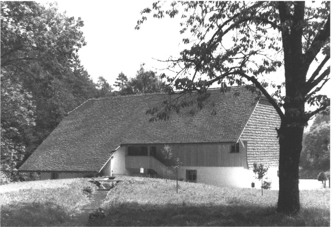
Abb. 2: Rückfassade nach der Wiederherstellung des Wasserkanals.
