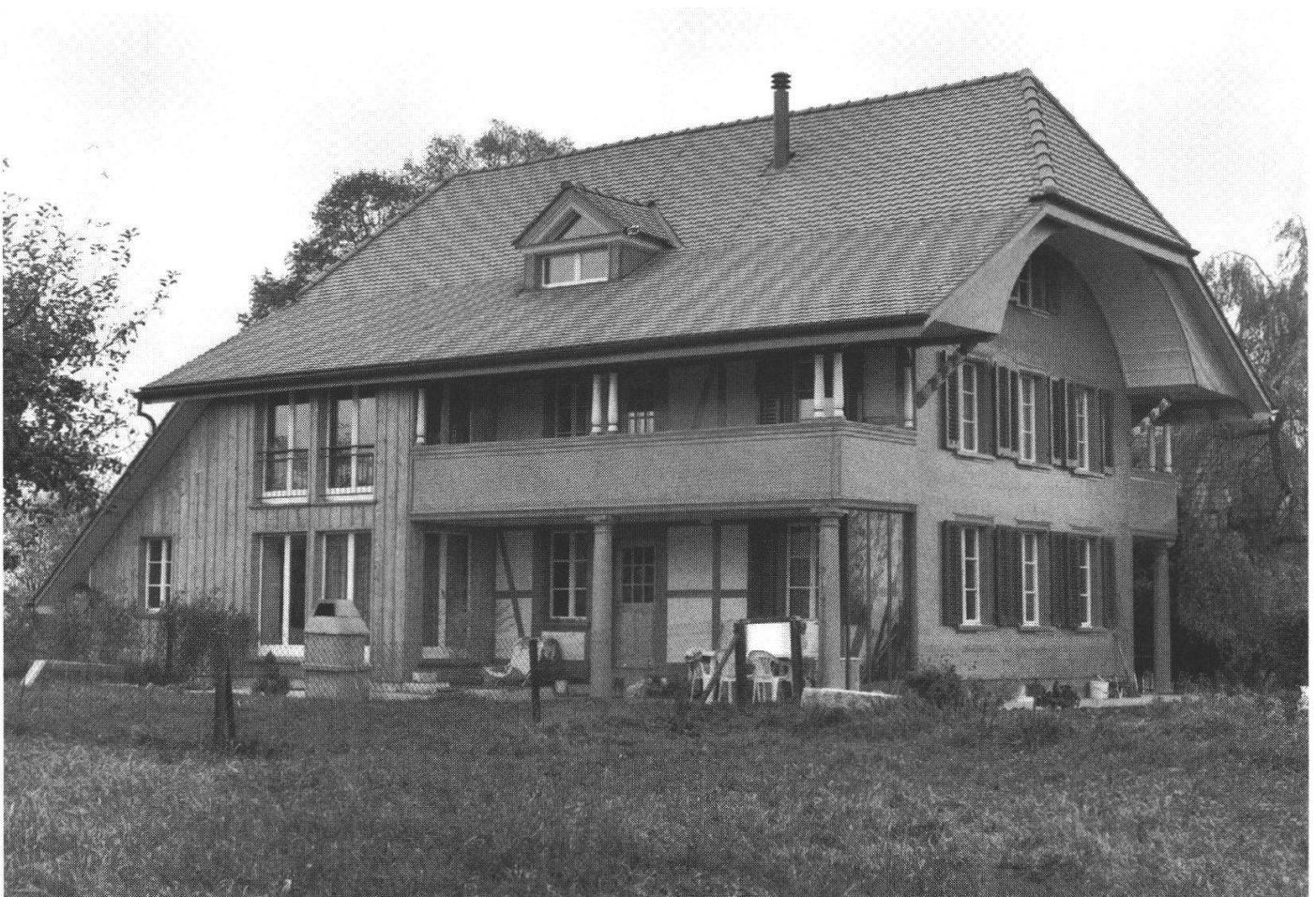
Abb. 2: ...und nach der Restaurierung.
