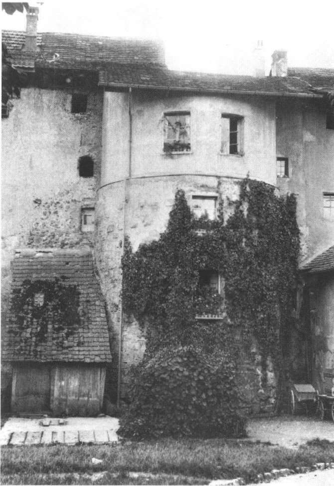
Abb. 4: Der Turm am Haus St. Urbangasse 71. Zustand vor der Rekonstruktion von 1964...
