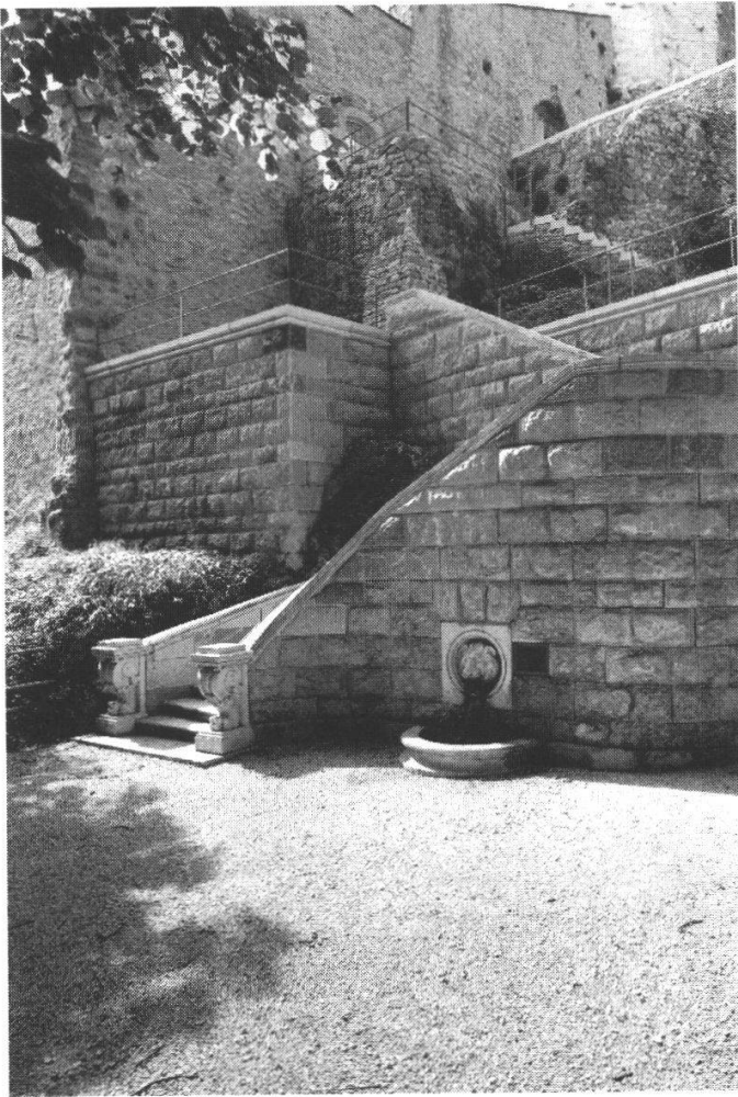
Abb. 3: Untere Terrasse mit Stützmauer von 1867.
