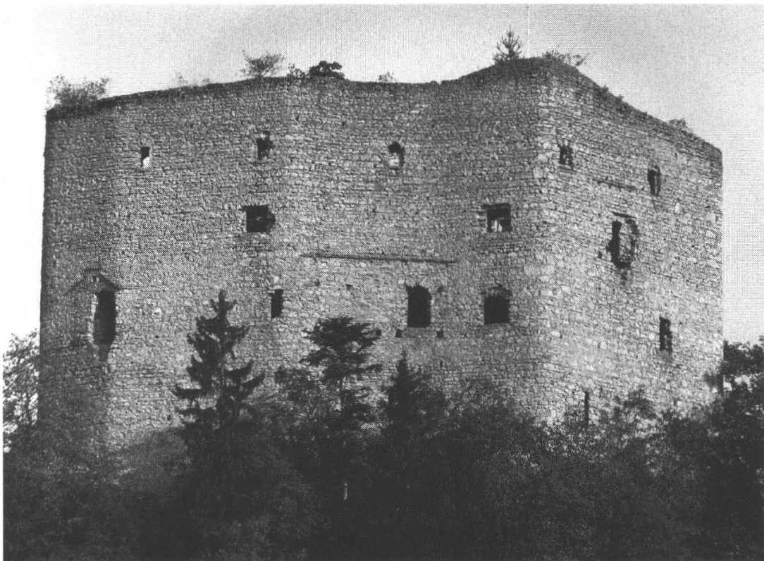
Abb. 3: Die Burgruine Gilgenberg bei Zullwil SO ist offenbar etwas älter als bisher vermutet. Die Burg dürfte um 1200 entstanden sein, wenn man der Einzelprobe eines Gerüstbalkens aus der Bauzeit glaubt.
