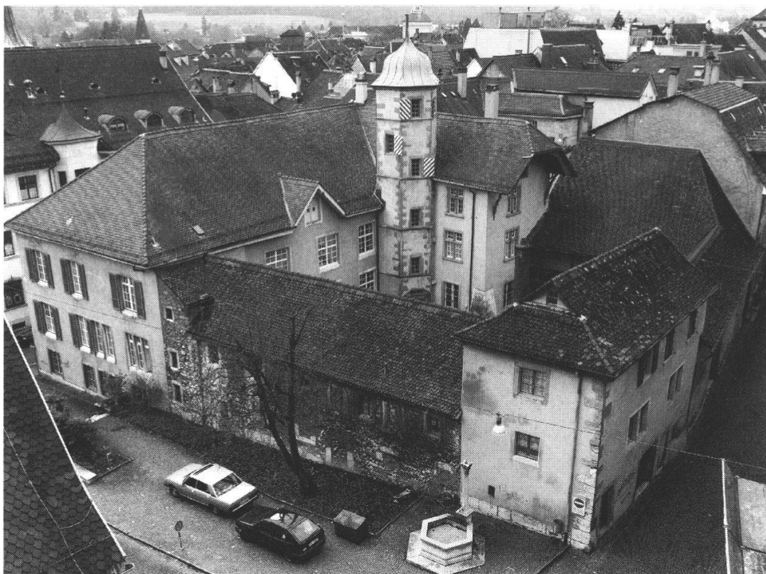
Abb. 7: Grissachs Haus, Barfüssergasse 17 in Solothurn, samt Hinterhaus und Trepenturm. (Foto: Kant. Denkmalpflege Solothurn)
