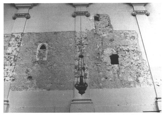
Innenseite der Nordwand des Chores: Rechts unten befindet sich die zugemauerte Öffnung der Ambassadorenloge von 1665/66. Rechts oben ist eine weitere Loge auszumachen, die nach dem Neubau des Ambassadorenhofes von 1717–1724 eingerichtet worden sein dürfte. Links ist der profilierte Rahmen eines gotischen Krankenfensters zu erkennen (Befunde der Bauuntersuchung von 1981, Zustand 1992).
