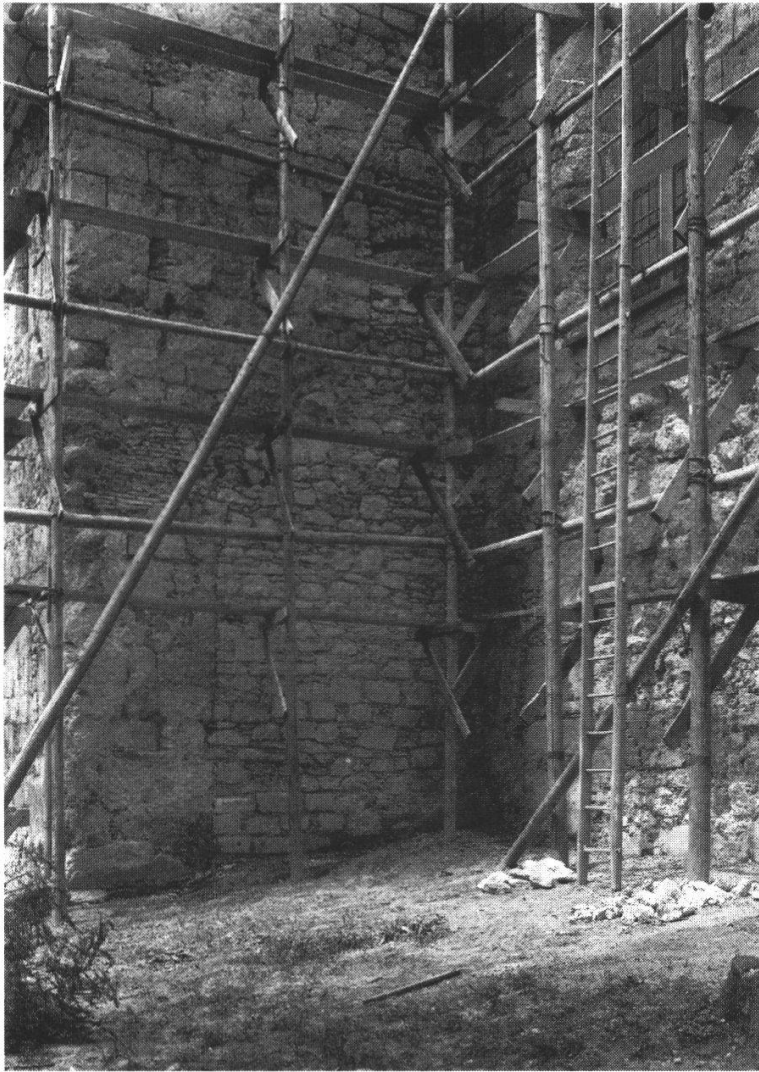
Zugänge zur Schiffleutenkapelle: Im Mauerwerk des östlichen Abschlusses des südlichen Seitenschiffes zeichnet sich eine zugemauerte Öffnung ab, welche in die ehemalige Schiffleutenkapelle führte. Rechts ist an der Südwand des Chores eine weitere zugemauerte Türe erkennbar (Aufnahme anlässlich der Renovationsarbeiten 1922–1927).
