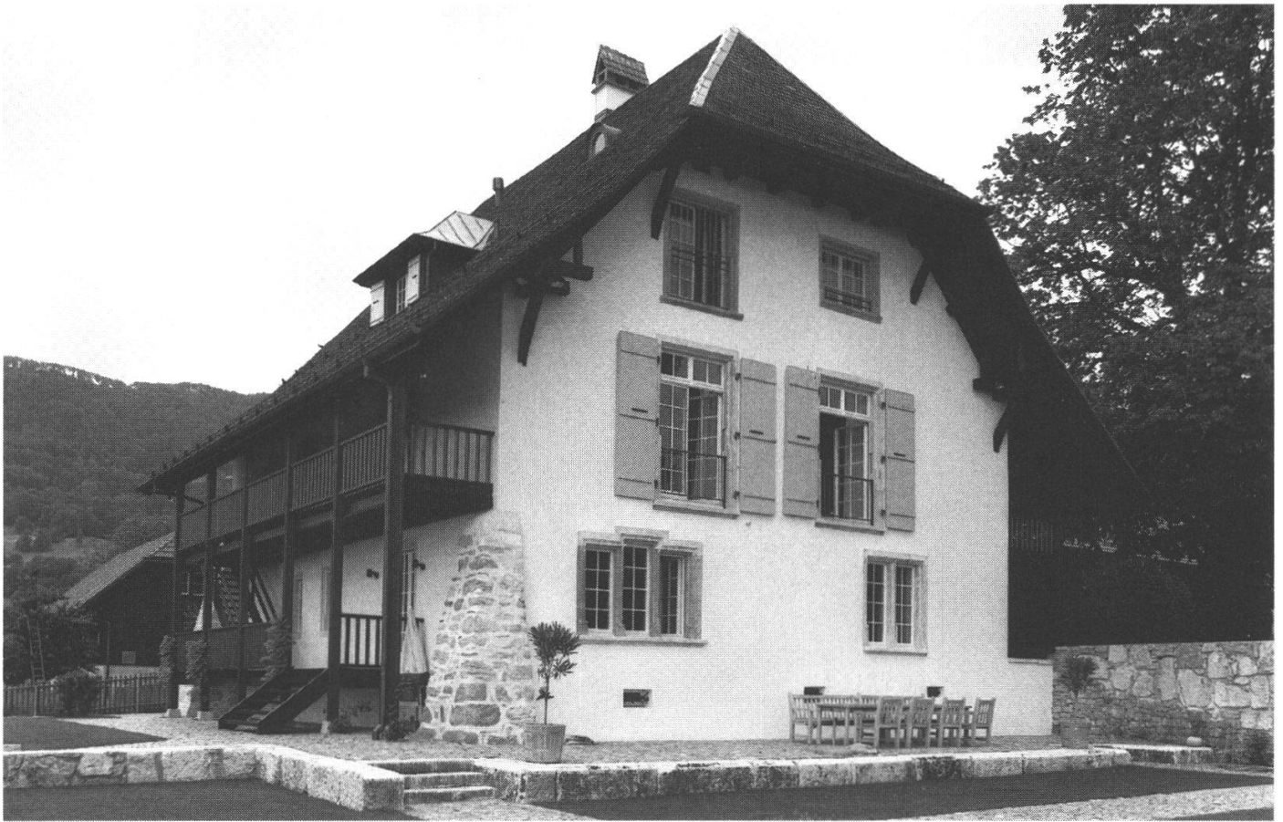
Abb. 2: Das Herrenhaus nach der jüngsten Renovation.
