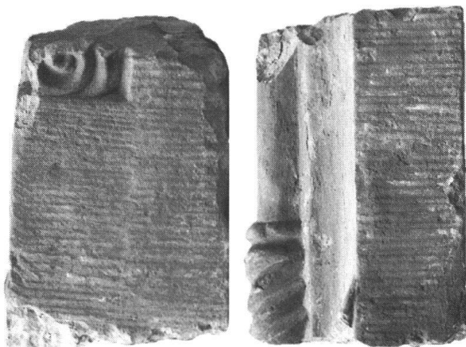
Abb. 2: Bruchstücke von Fenstergewänden aus Sandstein, aus der Zeit um 1550. Seitenansicht und Profil.
