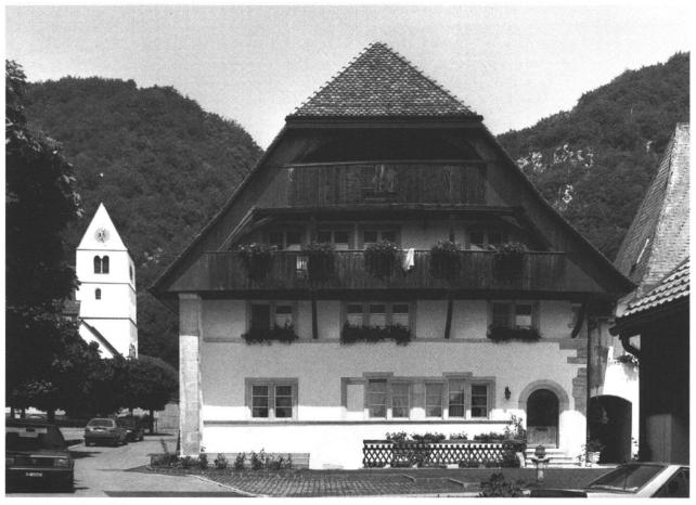
Abb. 8: Südansicht nach dem Umbau. Die überdimensionierte Stirnverkleidung seitlich der Lauben entstand durch die unsachgemässe Richtung der neuen Sparren, die nicht mehr direkt auf der alten Binderkonstruktion aufliegen.
