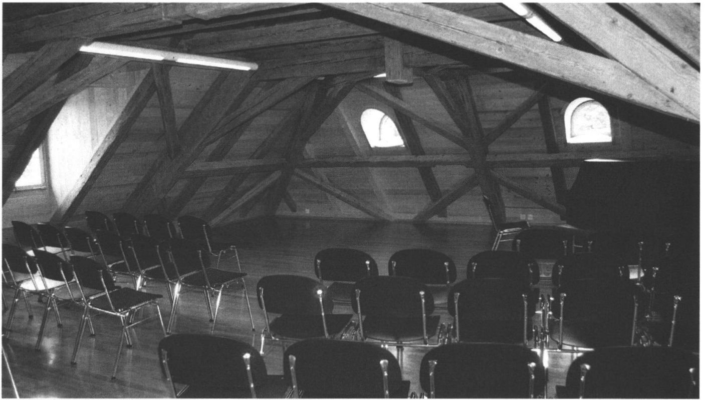
Abb. 3: Mehrzweckraum im neu ausgebauten Dachstock mit der alten Dachkonstruktion.
