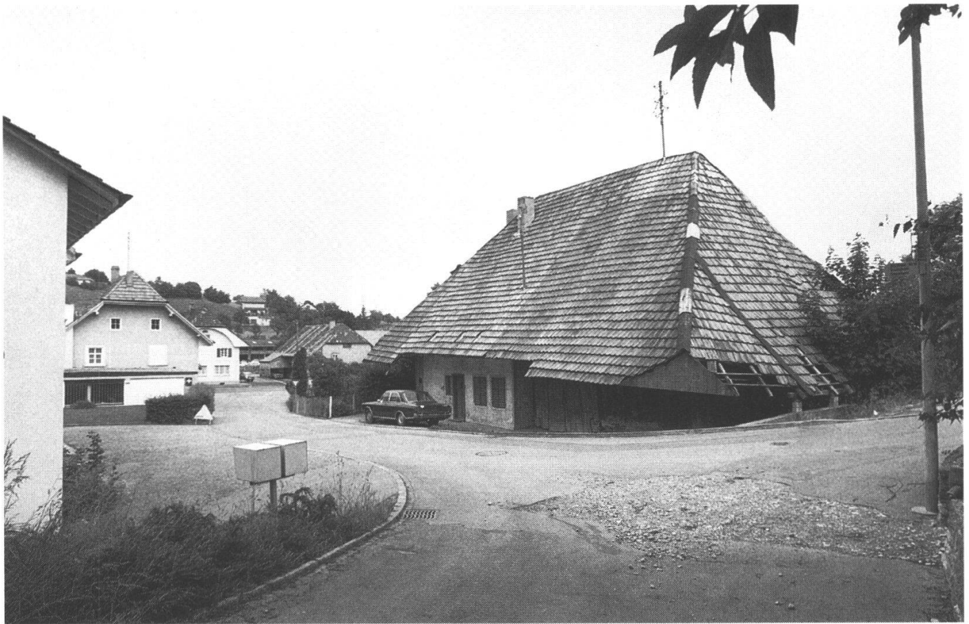
Abb. 1: Das Haus Nummer 42 vor dem Umbau.
