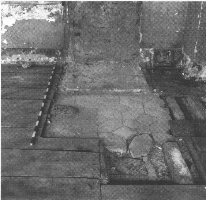
Abb. 13: Bettensaal Ost, Tonplattenboden unter dem Parkett, Fundzustand.
