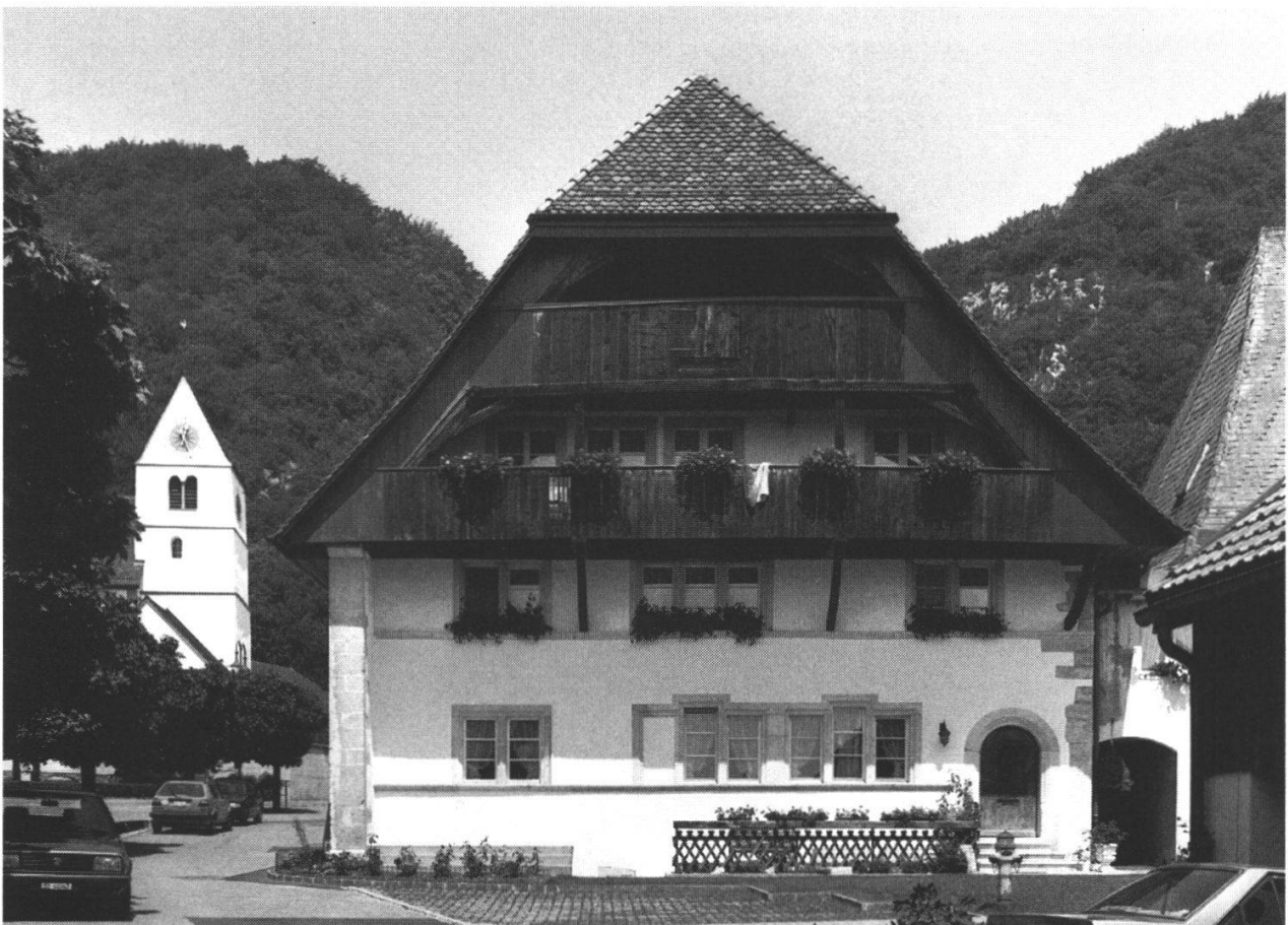
Abb. 8: Südansicht nach dem Umbau. Die überdimensionierte Stirnverkleidung seitlich der Lauben entstand durch die unsachgemäße Richtung der neuen Sparren, die nicht mehr direkt auf der alten Binderkonstruktion aufliegen.
