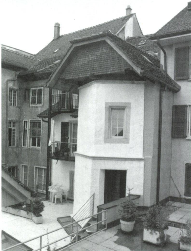
Abb. 9: Treppenturm, Obergeschosse, nach der Renovation.
