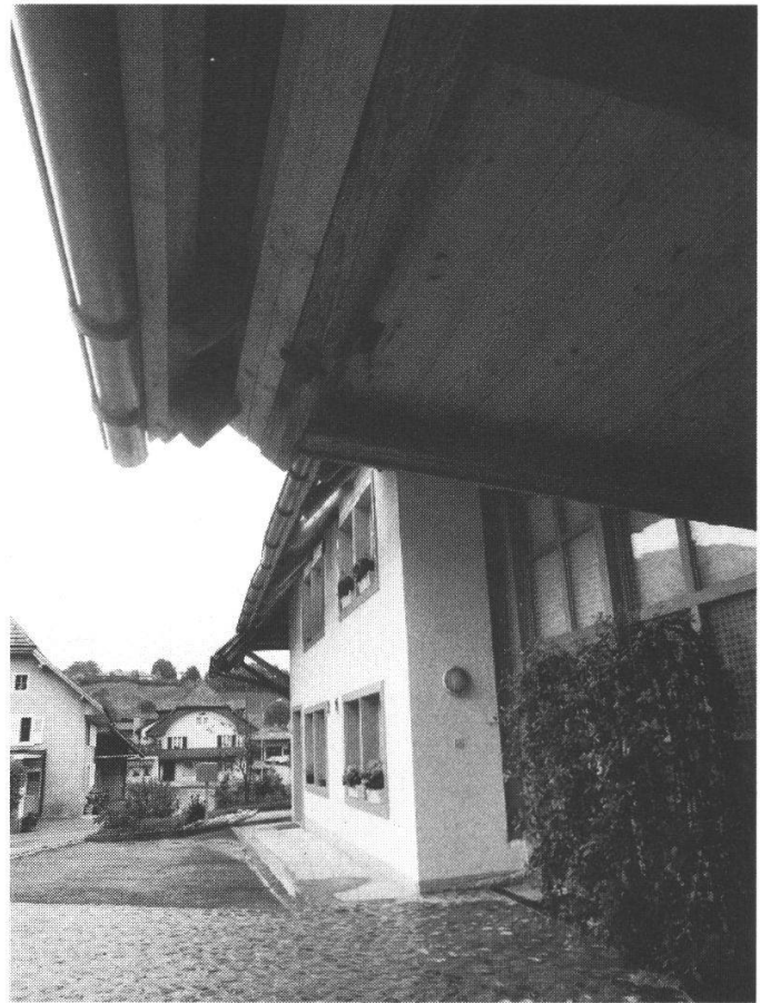
Abb. 7: ... und nach dem Umbau.
