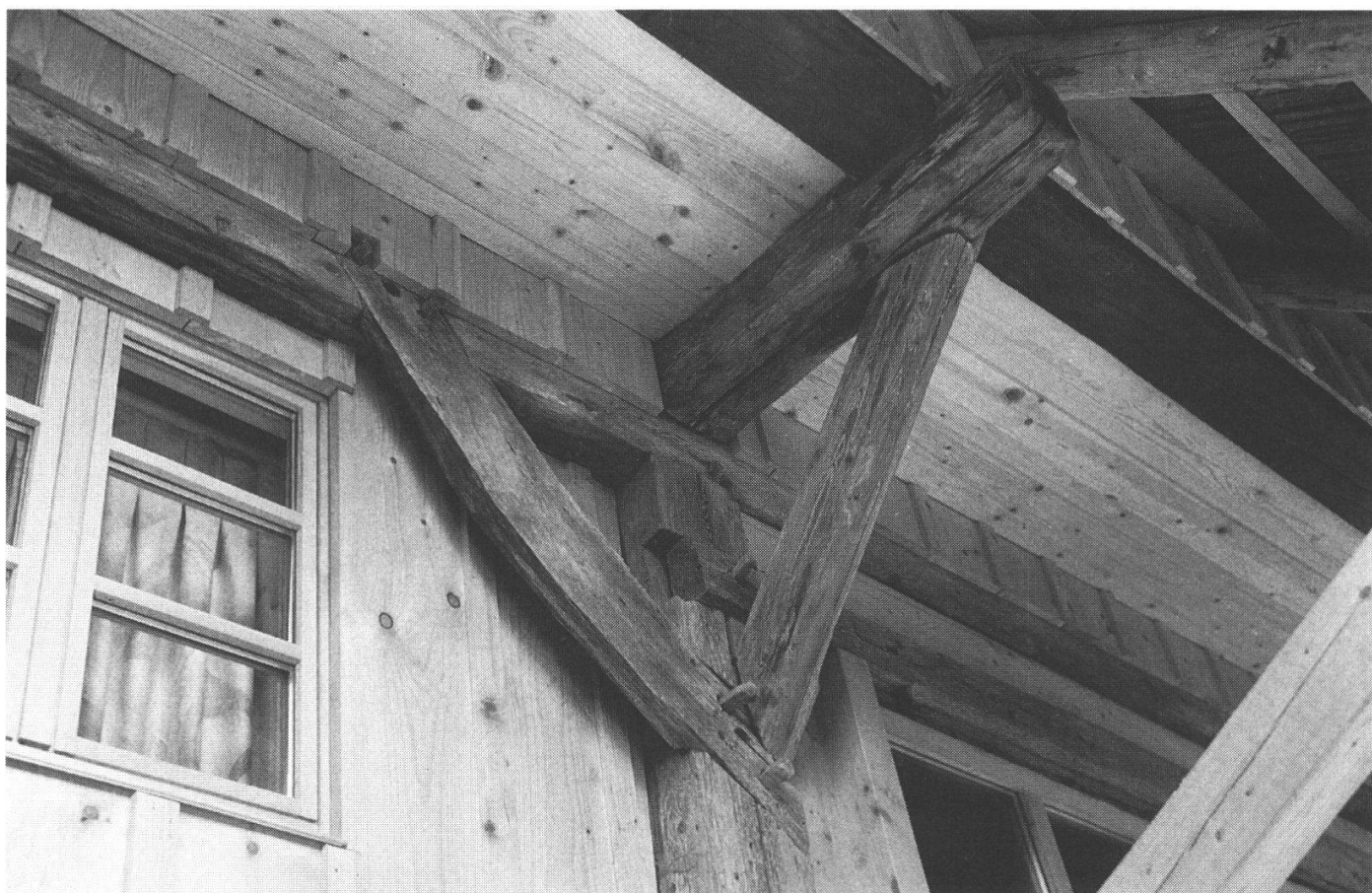
Abb. 8: Konstruktionsdetail Dachvorsprung/Wandverbund, nach dem Umbau.
