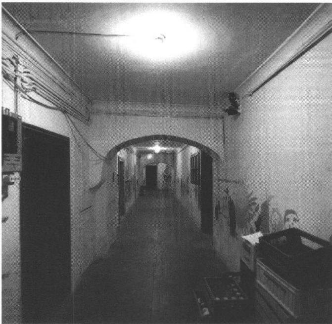
Abb. 6: Korridor EG, vor ...
