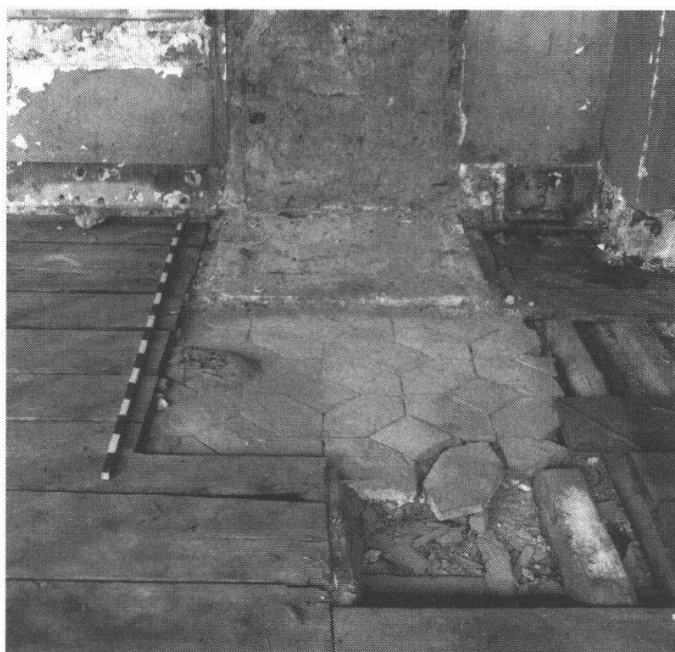
Abb. 13: Bettensaal Ost, Tonplattenboden unter dem Parkett, Fundzustand.
