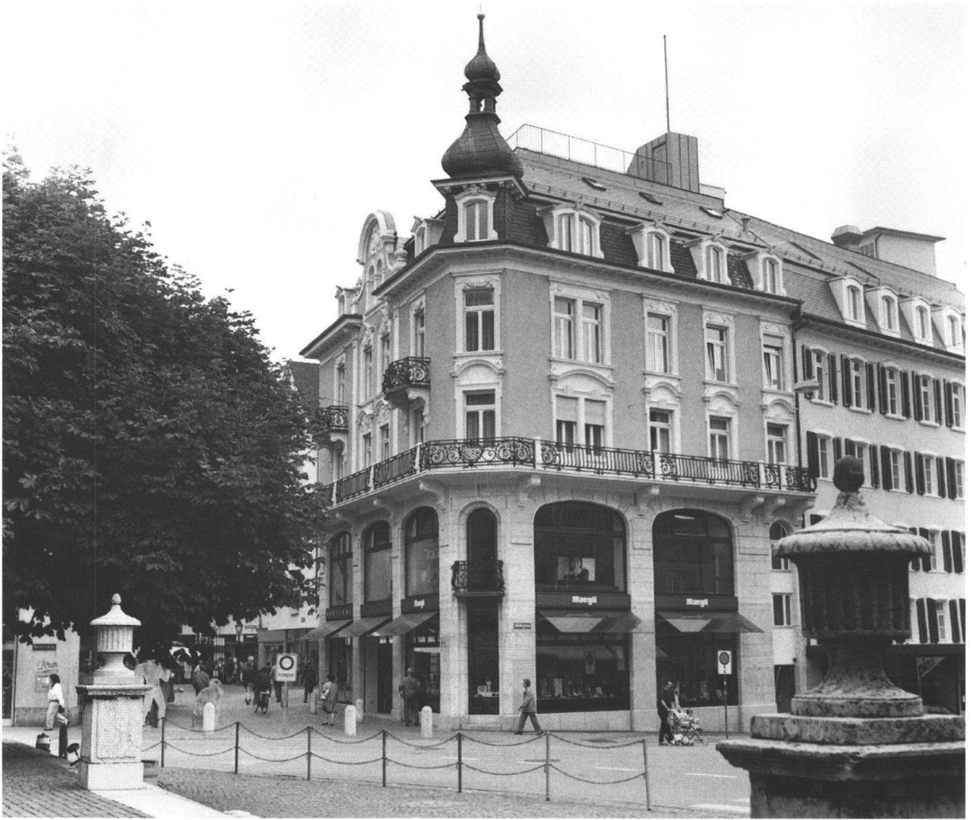
Abb. 1: Zustand nach der Restaurierung.
