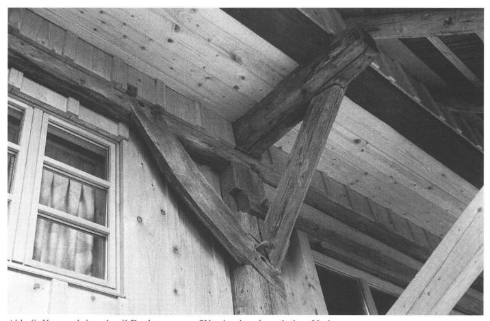
Abb. 8: Konstruktionsdetail Dachvorsprung/Wandverbund, nach dem Umbau.
