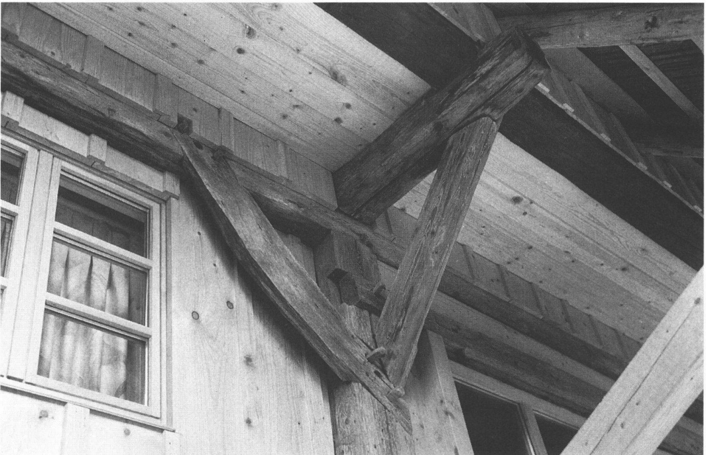
Abb. 8: Konstruktionsdetail Dachvorsprung/Wandverbund, nach dem Umbau.
