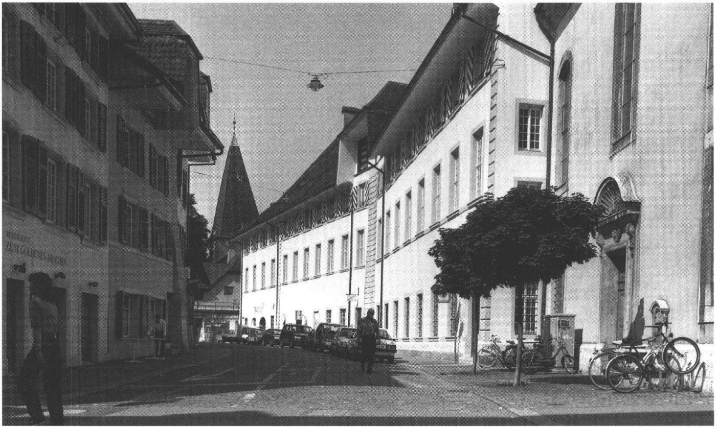
Abb. 2: ... und nach der Renovation.
