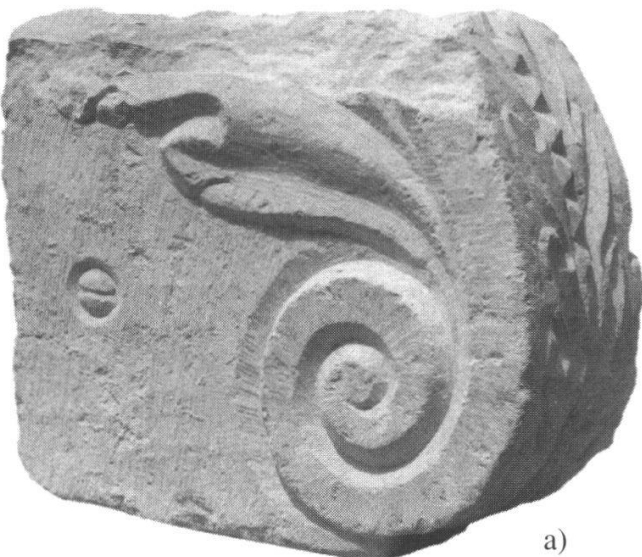
Abb. 19: Bruchstücke älterer Werkstücke, die im Erdgeschoss in einer Trennwand als Baumaterial verwendet wurden.
