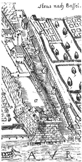
Abb. 2: Ausschnitt aus dem Stadtprospekt von Küng/ Schlenrit, 1653. Nr. 17 der Ritter mit den an ihn anschliessenden Stadtmauern im Norden. Die innere Mauer zeigt offene Zinnen ohne Wehrgang, die äussere ist mit einem Wehrgang versehen.
