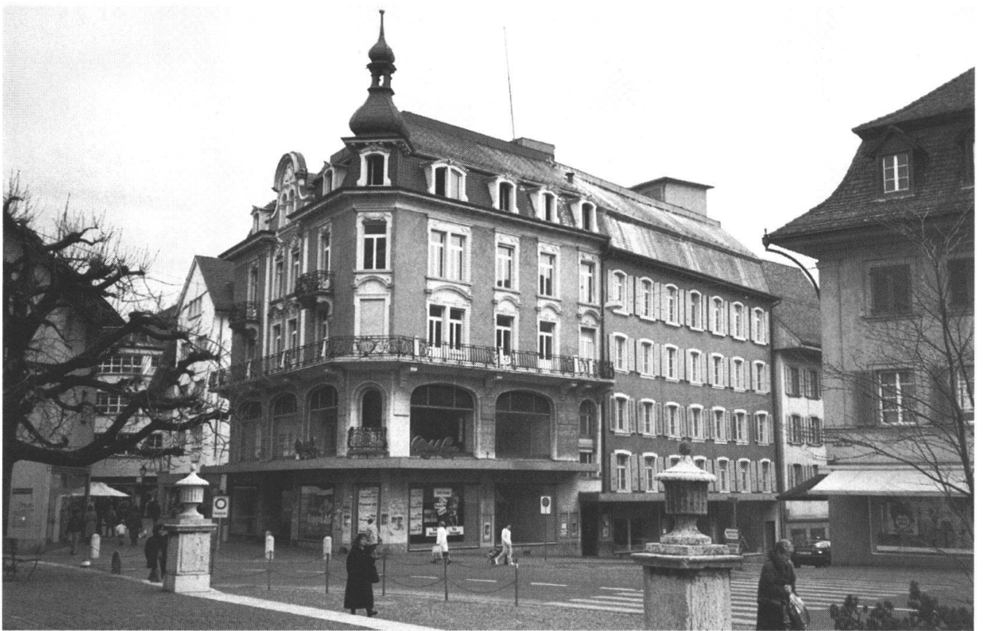
Abb. 2: Zustand vor der Restaurierung. Das klobige Vordach zerschneidet die grosszügige Schaufensterfront.
