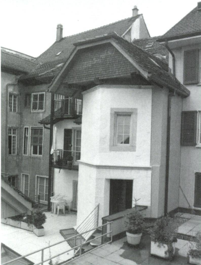
Abb. 9: Trepenturm, Obergeschosse, nach der Renovation.
