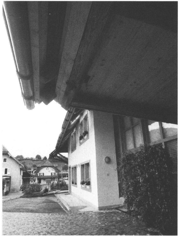
Abb. 7: ... und nach dem Umbau.
