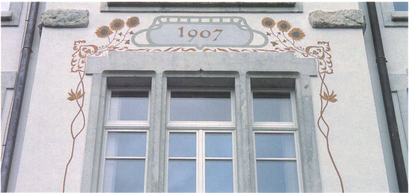
Abb. 2: Detail der rekonstruierten Fassadenmalerei.
