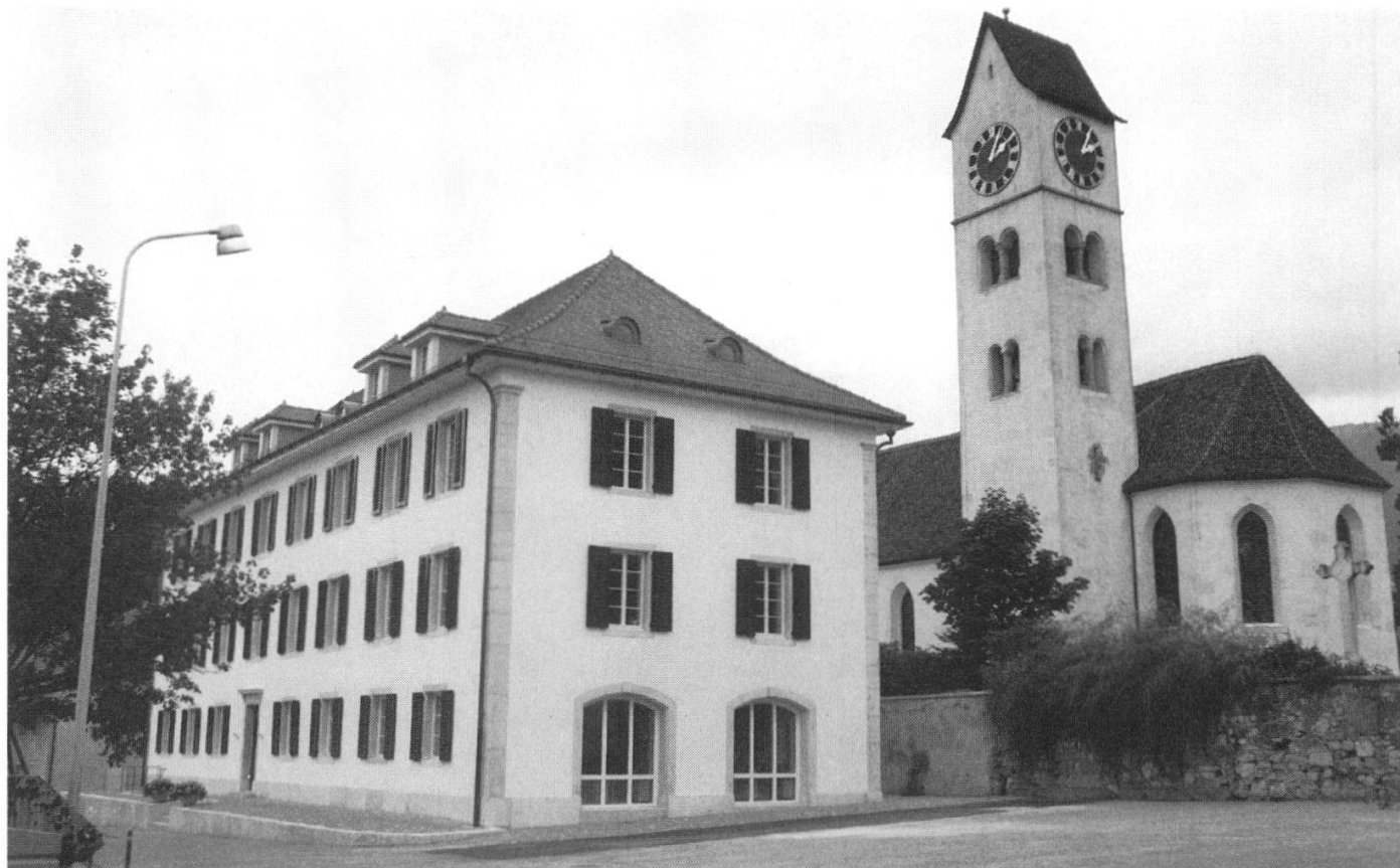
Abb. 1: Restauriertes Schulhaus mit der alten Kirche im Hintergrund.
