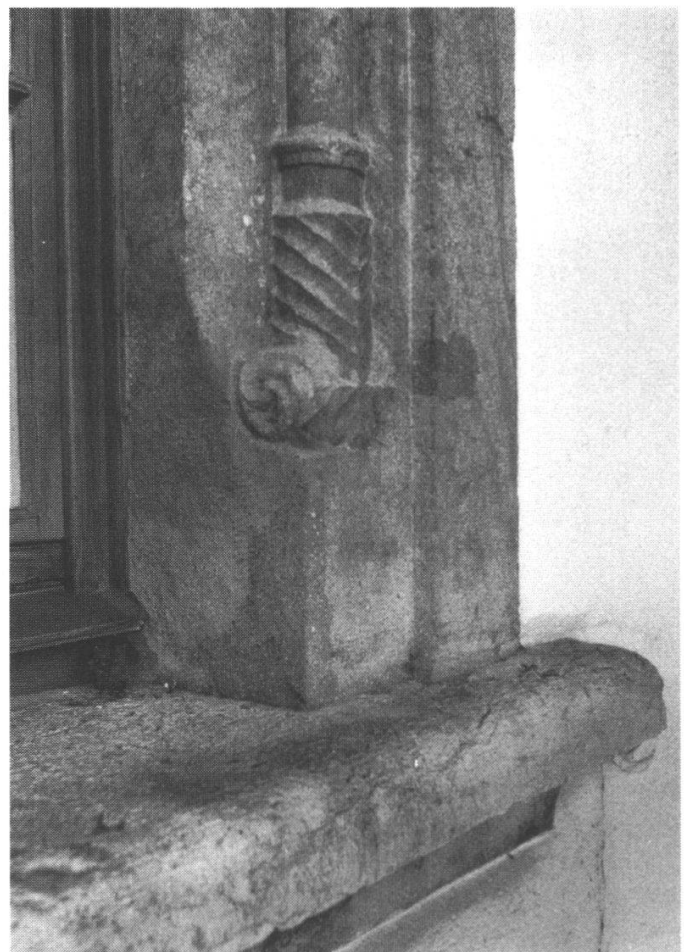
Abb. 5: Profilanlauf an einem der Fenster aus der Bauzeit des Hauses (1577/78).
