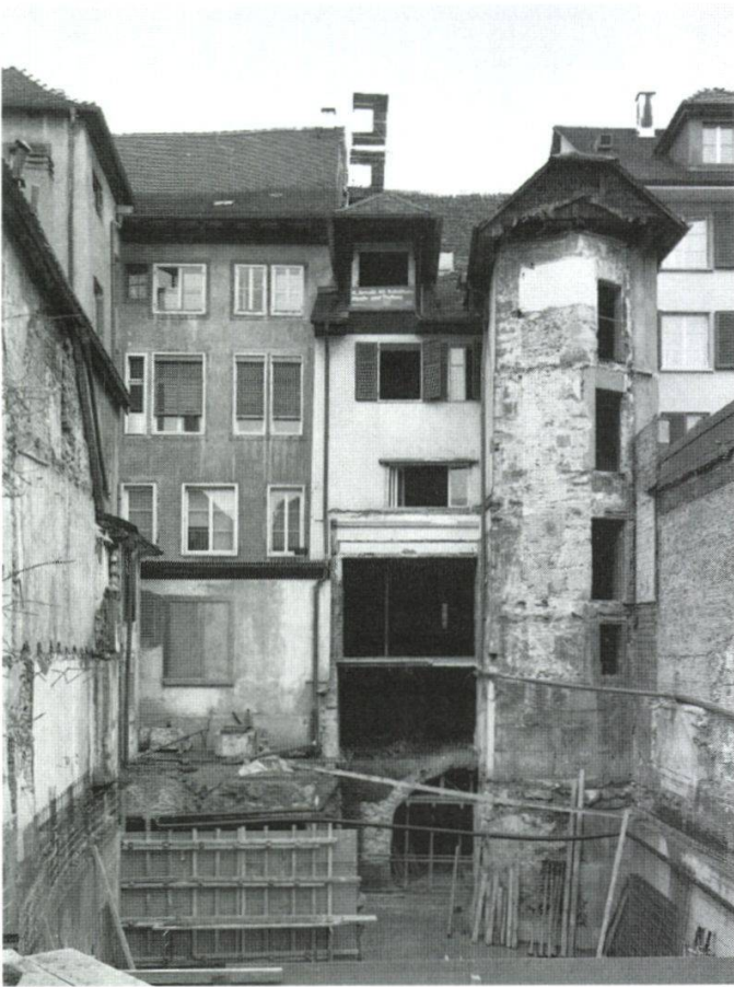
Abb. 8: Blick in den Innenhof an die Fassaden der Häuser Gurzelgasse 25 (links) und Gurzelgasse 21 (rechts, mit Trepenturm). Nach dem Abbruch des Saaltraktes aus dem 19. Jahrhundert.
