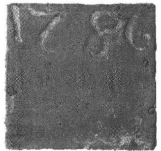
Abb. 19: Bruchstücke älterer Werkstücke, die im Erdgeschoss in einer Trennwand als Baumaterial verwendet wurden.
