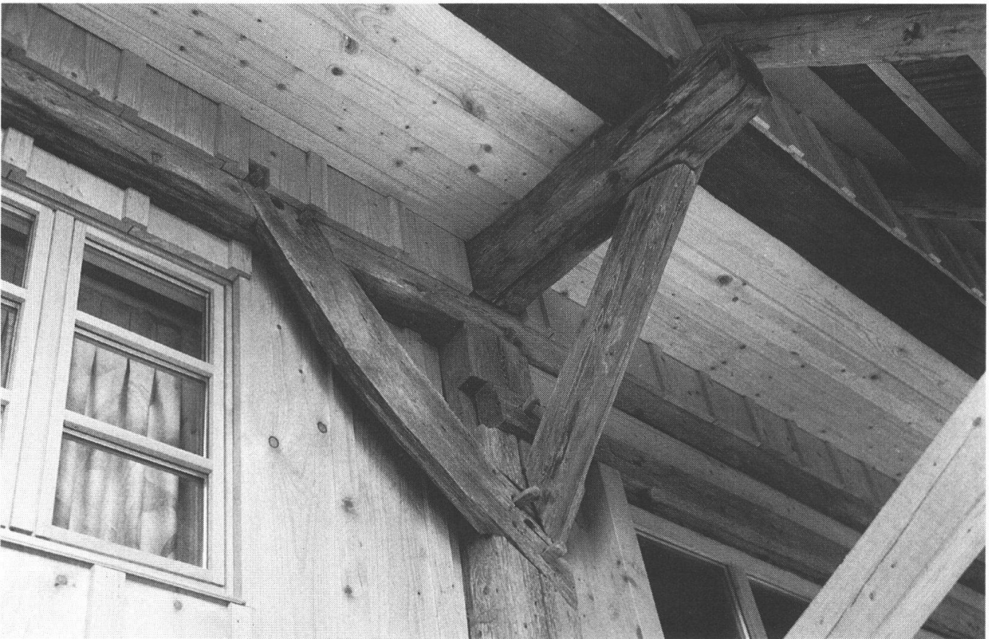
Abb. 8: Konstruktionsdetail Dachvorsprung/Wandverbund, nach dem Umbau.
