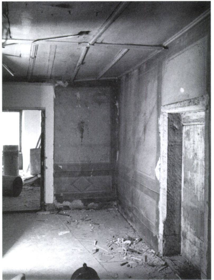
Abb. 10: Flur im zweiten Obergeschoss mit Wandmalereien aus dem 19. Jahrhundert und Bretterdecke aus dem 15. Jahrhundert. Fundzustand, Blick nach Norden.
