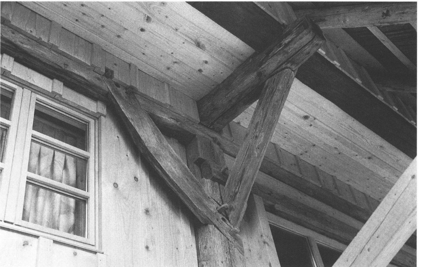
Abb. 8: Konstruktionsdetail Dachvorsprung/Wandverbund, nach dem Umbau.
