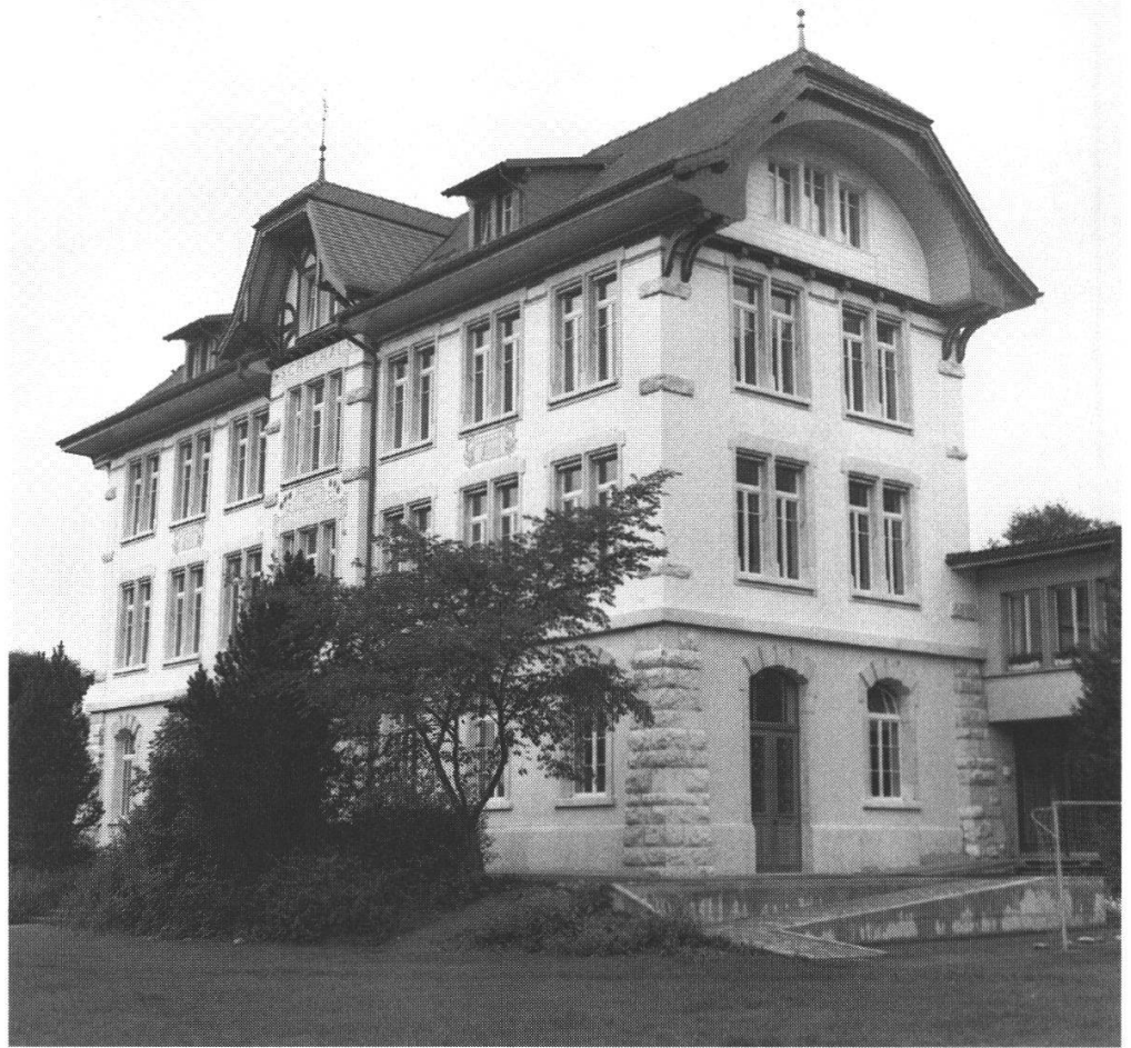
Abb. 1: Gesamtansicht nach der Restaurierung.
