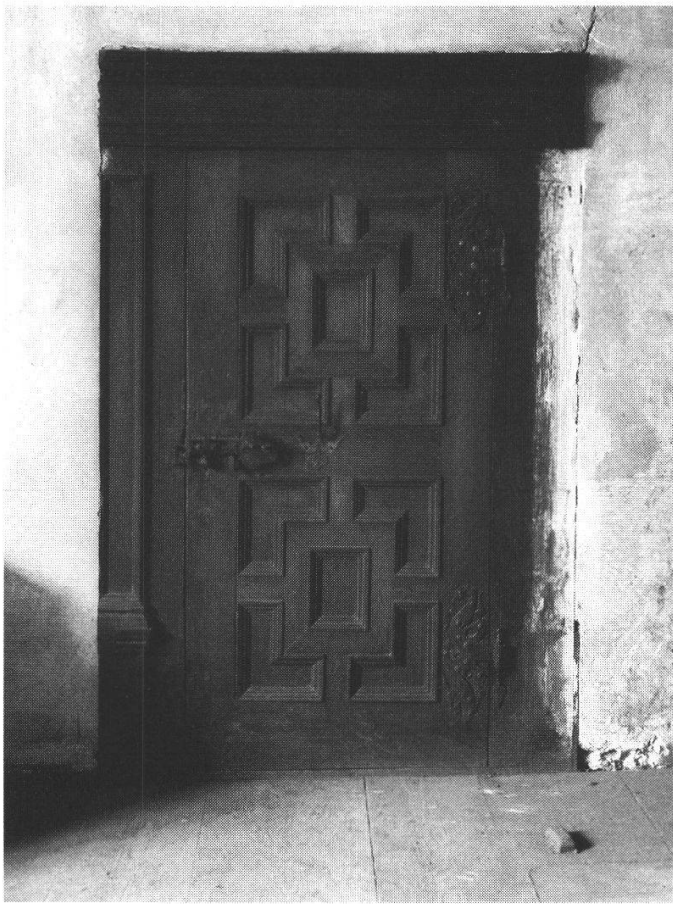
Abb. 8: Türblatt in einem Zimmer im Obergeschoss, Zustand um 1925.
