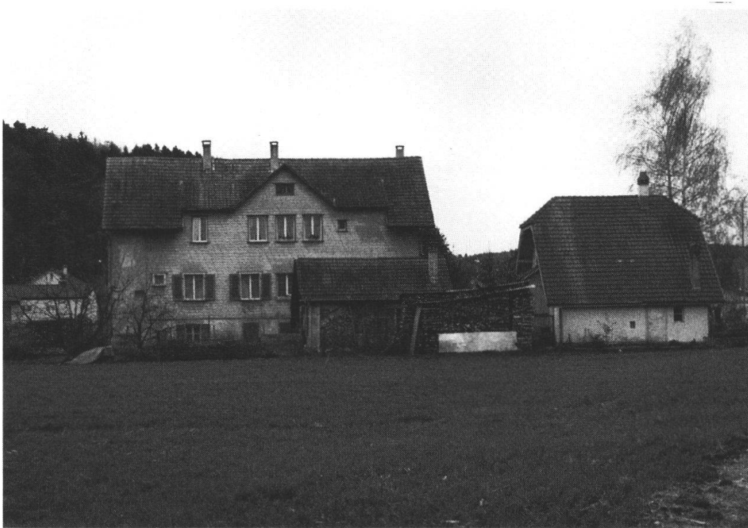
Fabrikationsgebäude der ehemaligen Genossenschafts-Schusterei «Einigkeit» in Gretzenbach (Foto des Verfassers).
