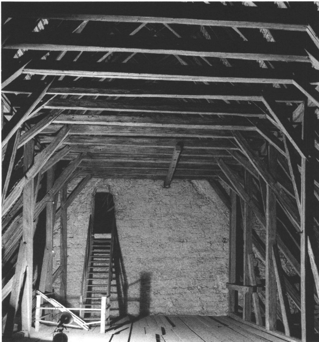
Der spätmittelalterliche Dachstuhl über dem Langhaus (um 1425). Im Hintergrund Aufgang in den Dachstuhl über dem Chor.
