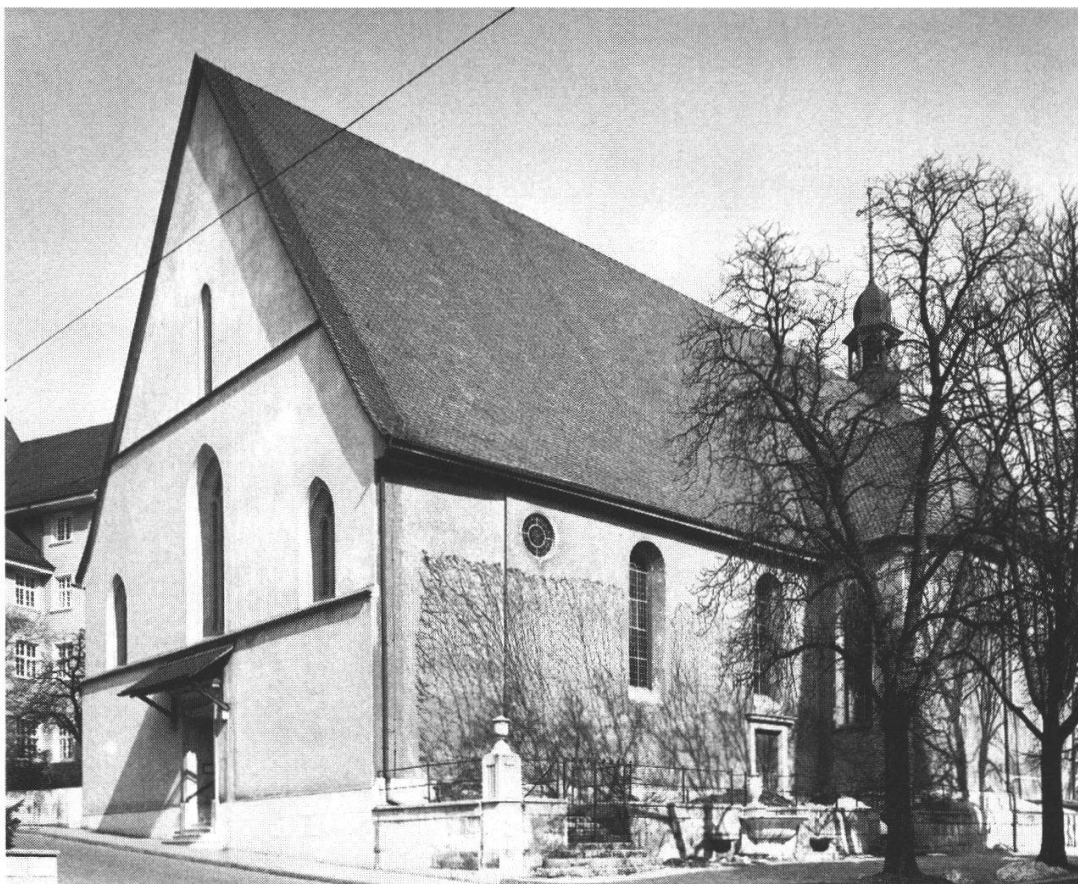
West- und Südfassade der Franziskanerkirche mit Antoniuskapelle (1661–1663).
