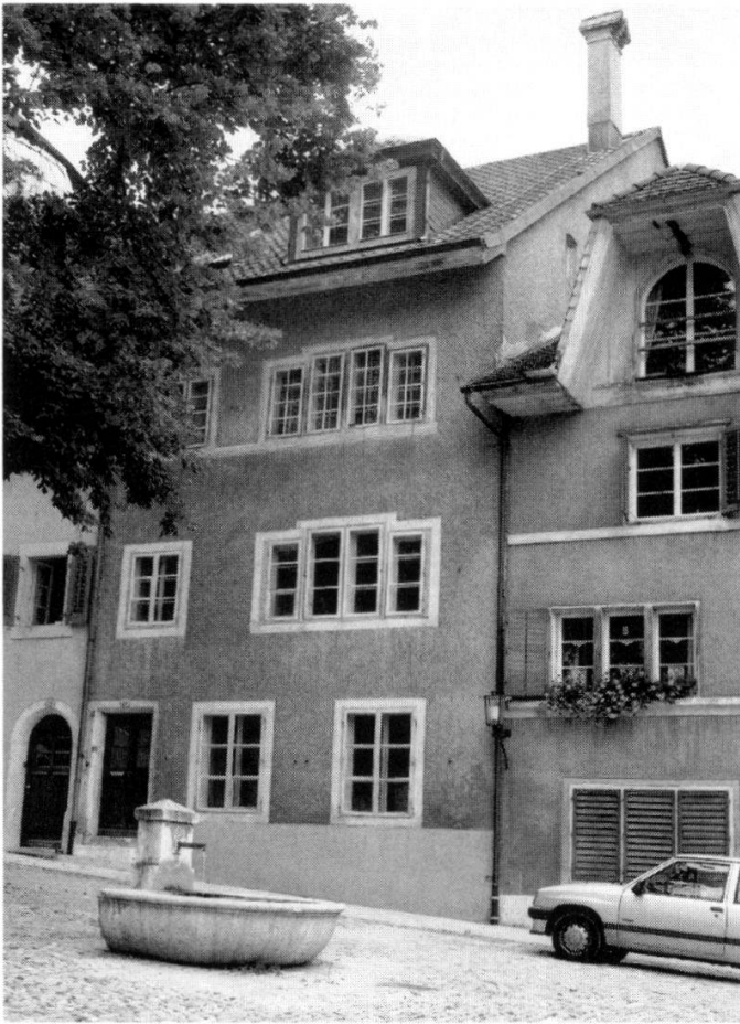
Abb. 4: Riedholzplatz Nr. 30, «Rüeflihaus» vor der Renovation von 1990/91 mit schwerfällig wirkender Lukarne von 1941 ...
