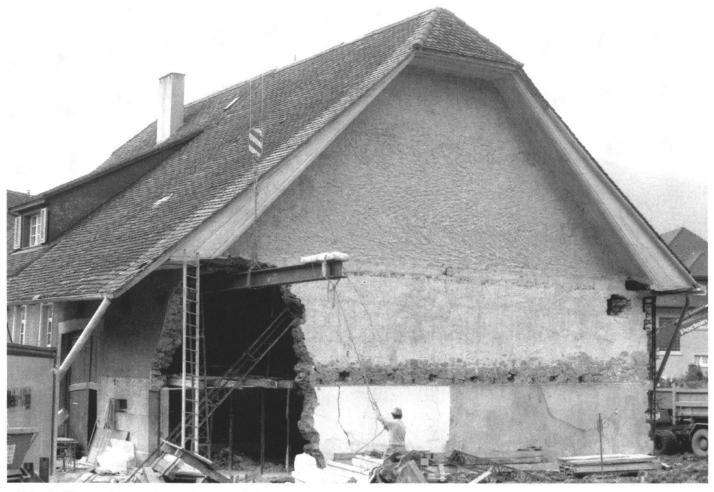
Abb. 4: Wenn einem alten Haus zuviel zugemutet wird: Einsturz einer Hausecke während des Umbaus. Aufnahme vom 28. August 1987.
