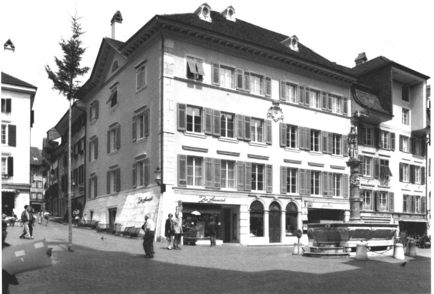
Abb. 2: ... und nach der Fassadenrenovation von 1991.
