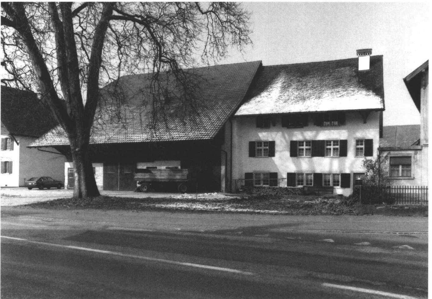
Abb. 12: Das renovierte Wohnhaus und der neu errichtete Stallteil im Januar 1992.
