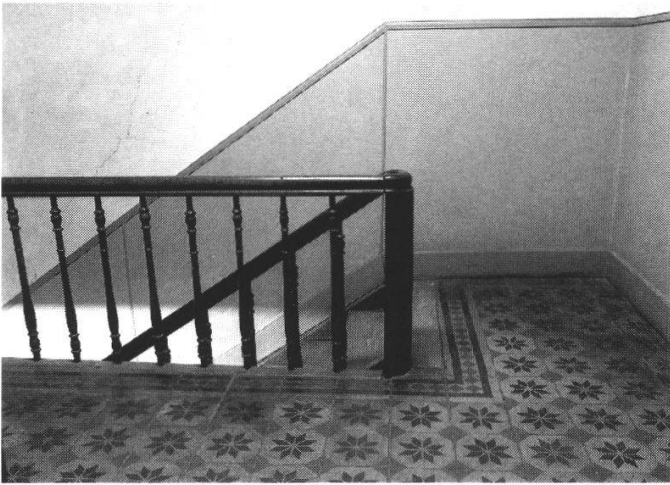
Abb. 3: Blick ins Treppenhaus, mit gedrechseltem Treppengeländer und farbigem Plattenboden von 1874, vor dem Umbau.
