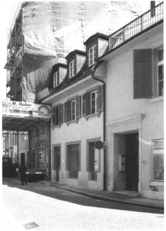
Abb. 11: ... und nach der Sanierung.
