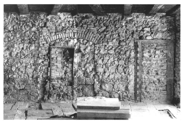
Abb. 12: Brandmauer Ost, Bereich Stube 1. Obergeschoss. Sekundär ins Mauerwerk eingesetzte und später wieder zugemauerte Türöffnungen zum östlichen Nachbarhaus. Sie stammen aus den Zeitspannen von 1634–1642 und 1672–1706, als die beiden Häuser Hauptgasse Nr. 9 und Nr. 11 dem gleichen Besitzer gehörten.
