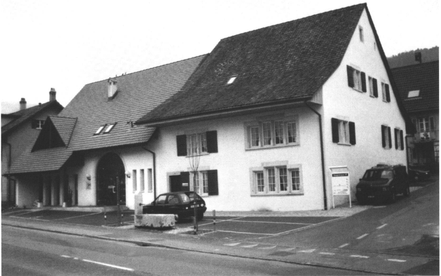
Abb. 2: ... und 1991, nach Abschluss der Arbeiten.
