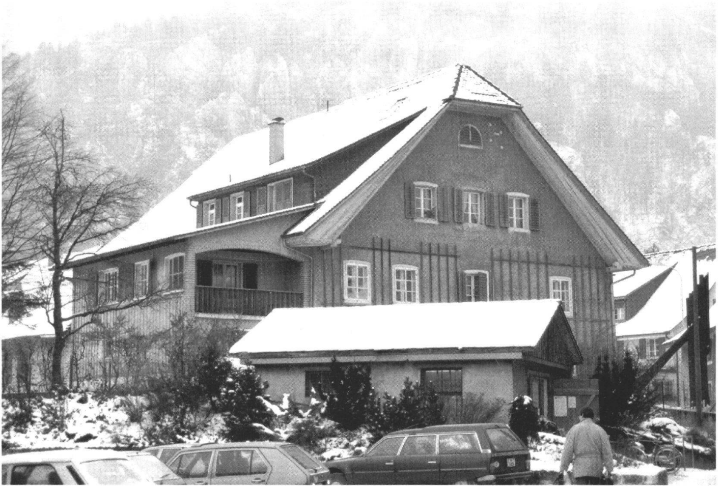
Abb. 2: Das Haus Nr. 17 vor der Restaurierung mit dem unschönen Anbau links.
