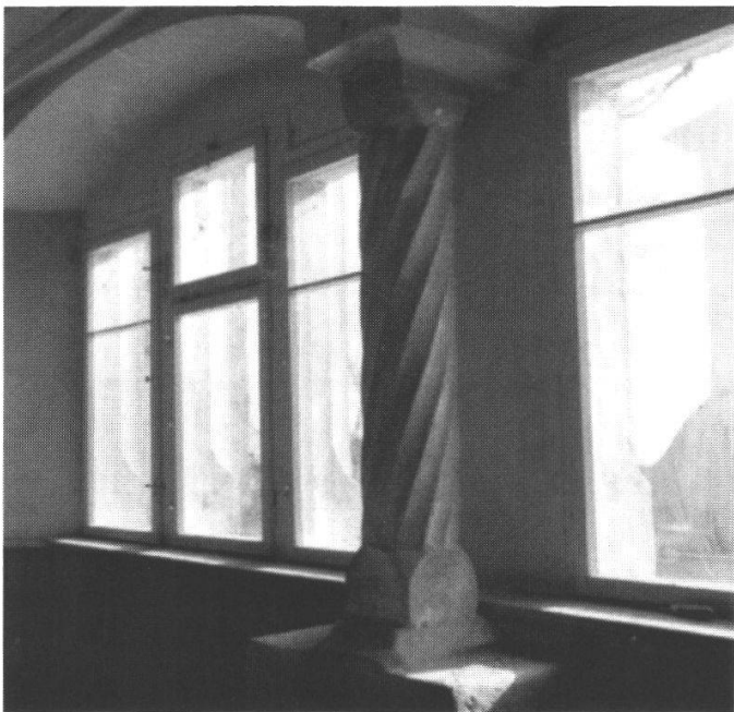
Abb. 3, oben links: Fenstersäule zwischen den beiden Staffelfenstern im Erdgeschoss von zirka 1550, während der Restaurierung 1961.
