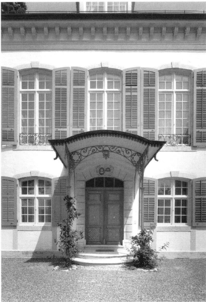
Abb. 3: Fassadendetail mit Haupteingang.
