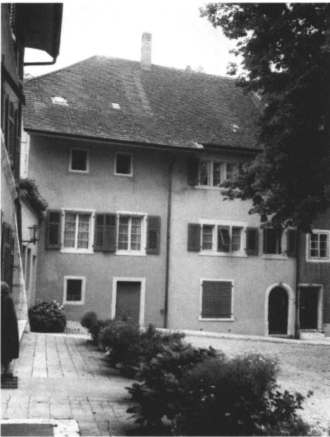
Abb. 11: Riedholzplatz Nr. 32, «Schwallerhaus», vor der Renovation von 1990/91 ...
