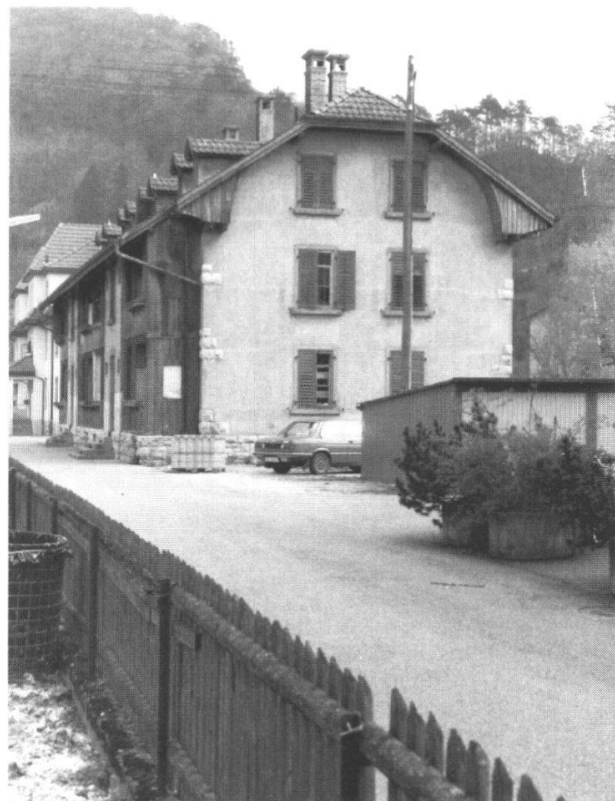
Abb. 2: Das abgebrochene Doppelhaus von etwa 1906 am Wyssenfluhweg Nrn. 4/6.
