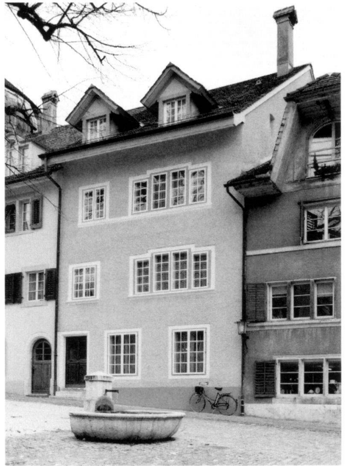
Abb. 5: ... und das gleiche Haus nach der Renovation von 1990/91, mit neuen Lukarnen.
