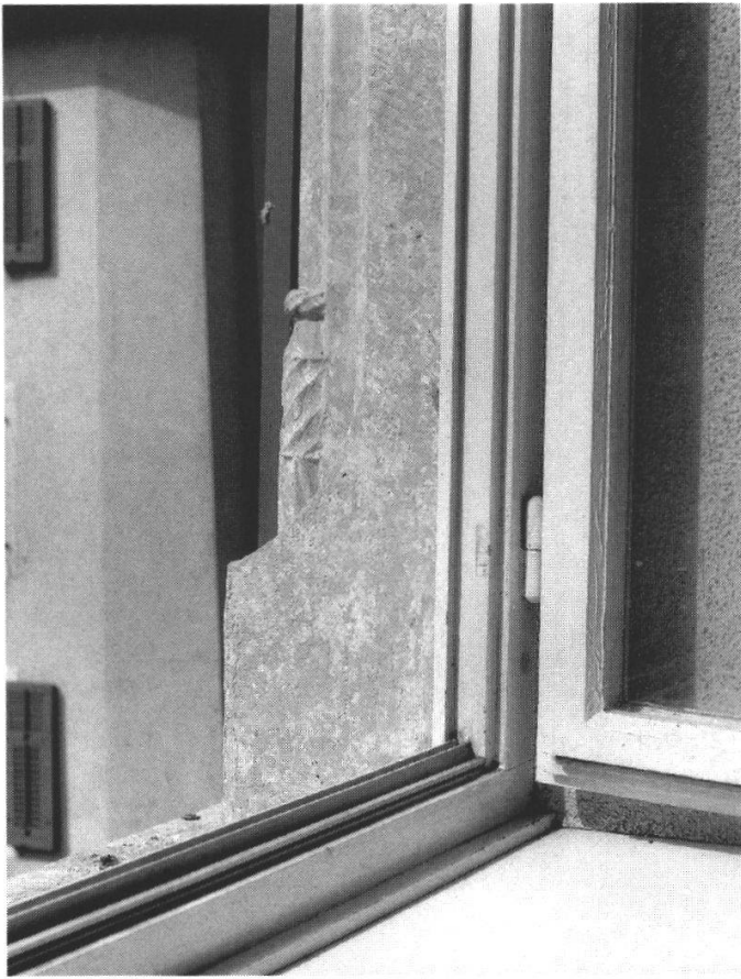
Abb. 2: Fenstergewände im zweiten Obergeschoss mit Zierformen aus dem 16. Jahrhundert.
