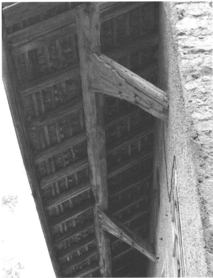
Abb. 4: Südseite, Stützstreben mit Brettbügen, die die Flugpfette abfangen. Sie gehören zur älteren Dachkonstruktion von etwa 1550.
