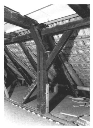
Abb. 1: Pfosten mit Zug- und Druckbug, die in die Mittelpfette, die Fussschwelle und das Kehlgebälk eingeblattet und mit einem Holznagel gesichert sind.
