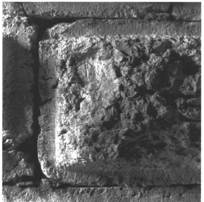
Abb. 5: Ausschnitt aus einem Bossenquader an der Südseite des Riedholzturms. Oben links ist im Bossen eine kleine flache Vertiefung zu erkennen, darin ein armbrustförmiges Steinmetzzeichen.
