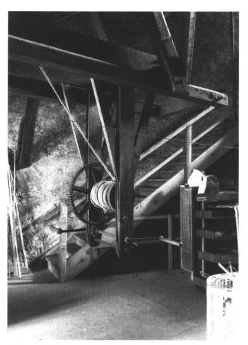
Abb. 4: Holzaufzugswinde im Estrich, beim Umbau von 1989/90 demontiert.
