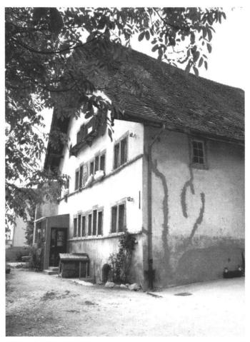
*Abb. 6:* Die Mühle vor der Restaurierung, von Südosten. Im Vordergrund zeichnen sich markante Setzrisse ab.
