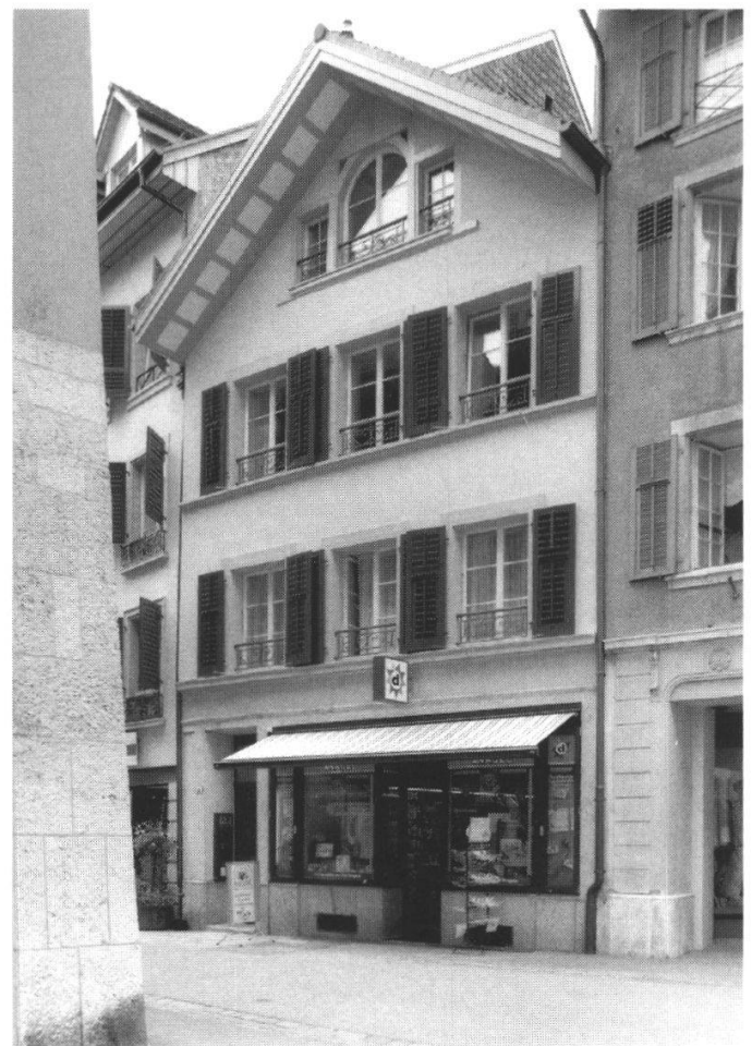
Abb. 2: ... und nach der Renovation von 1989/90.
