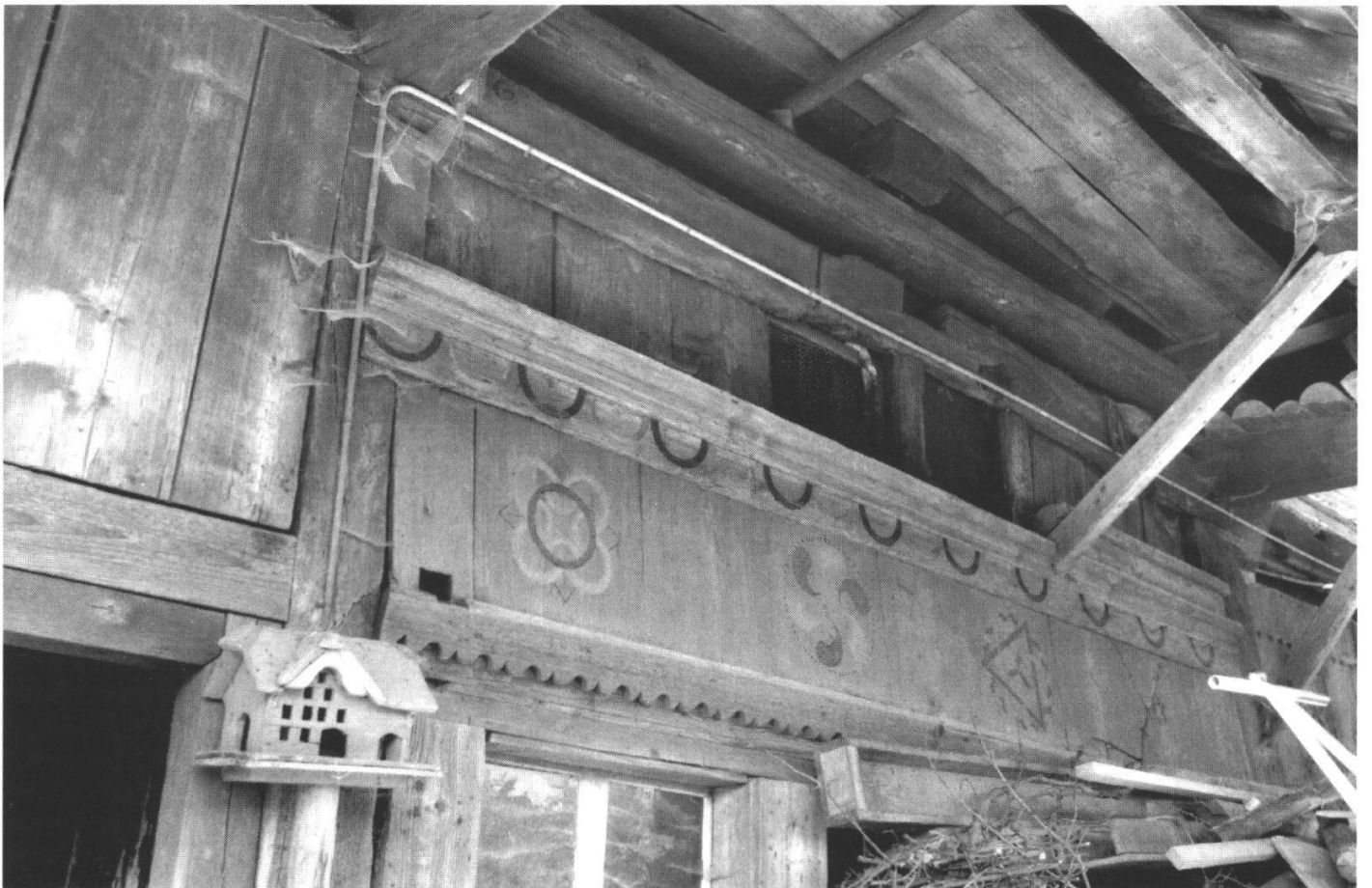
Abb. 8: Brüstungselement im Bereich über der mittleren, südlichen Stube mit Dekorationen in Rot und Weiss (um 1730).
