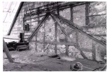
Abb. 4: Schmiedengasse Nr. 29, Brandmauer Süd, nach dem Abbruch der beschädigten Dachkonstruktion.
