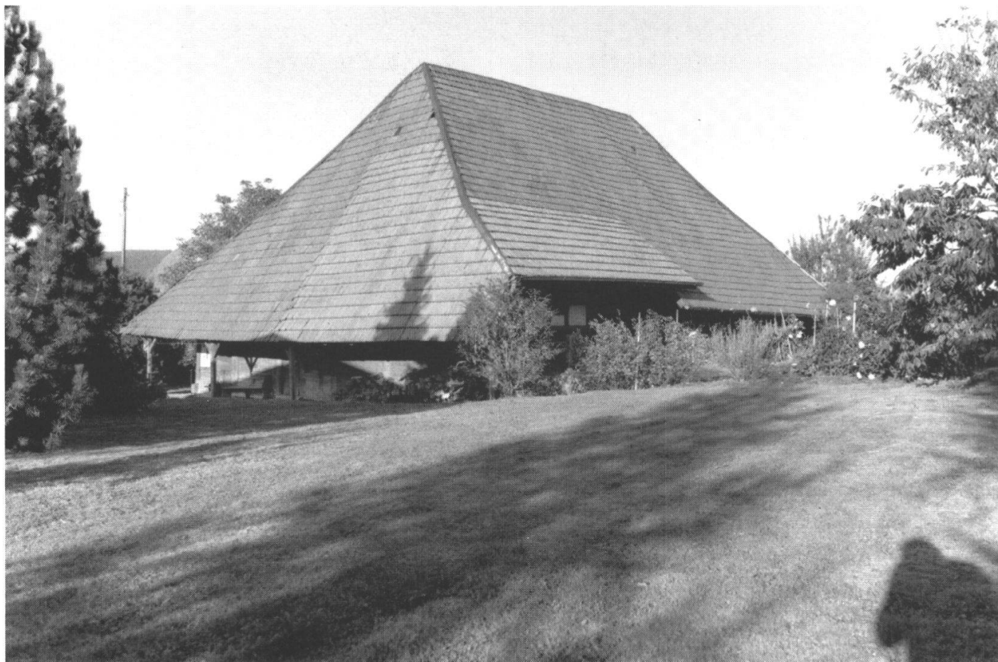
Abb. 1: Das Haus von Südwesten mit seinem imposanten Walmdach.
