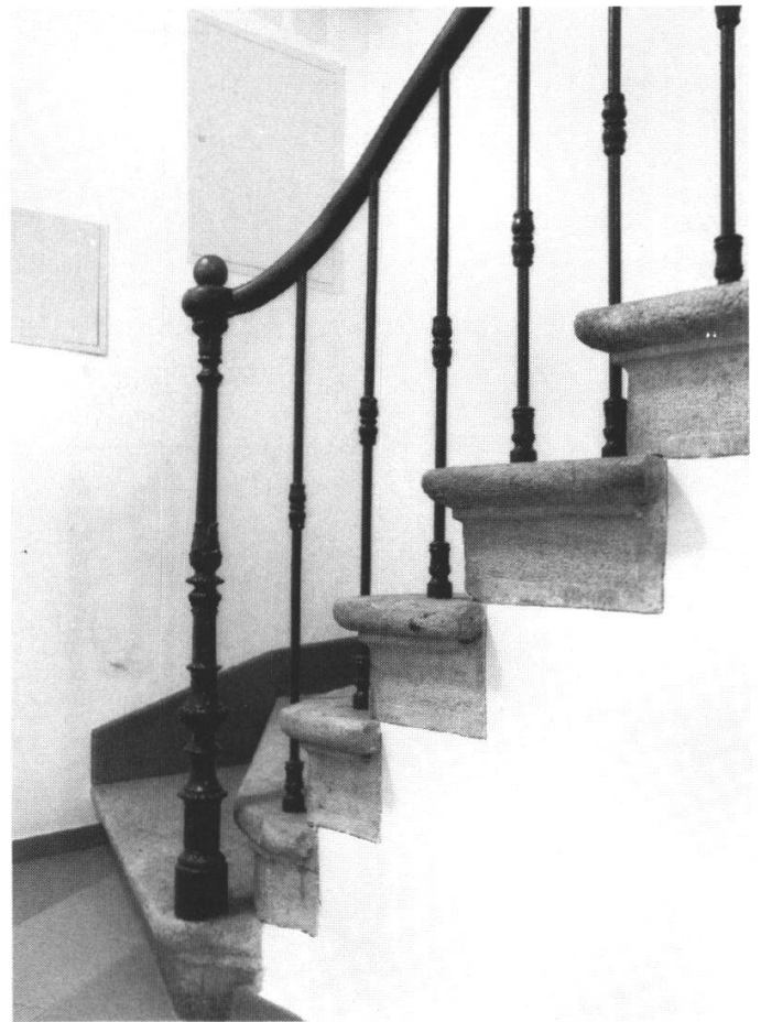
Abb. 5: Treppenanlage nach der Restaurierung.
