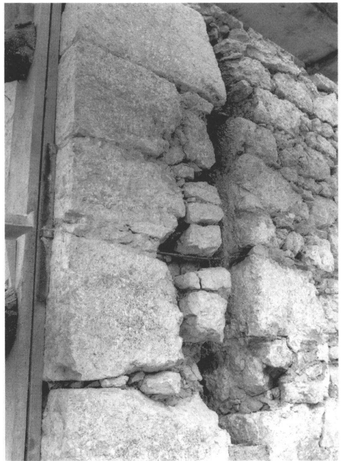
Abb. 7: Nach dem Entfernen des Verputzes zeigen sich im Bereich der Südostecke zwei Gebäudeecken, die ungenügend miteinander im Verband stehen. Links die Südostecke zur heutigen Fassade von 1614, rechts die ältere Südostecke eines Vorgängerbaus aus dem 16. Jahrhundert.
