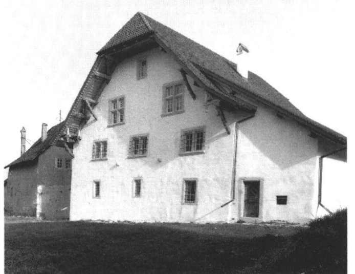
... und nach der Renovation.
