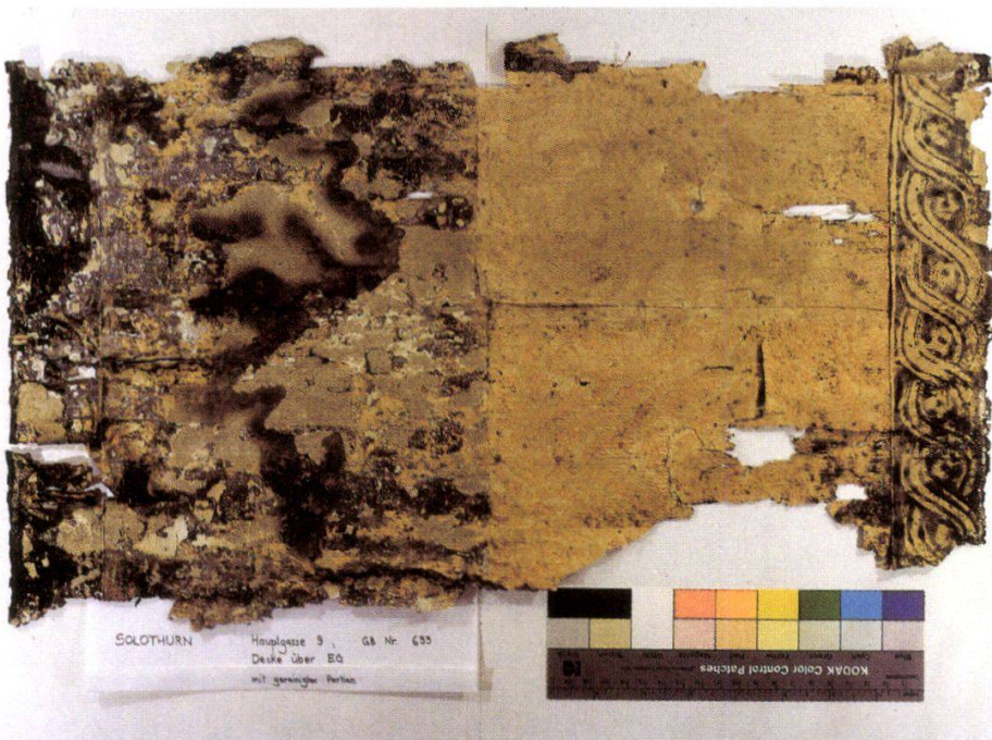
Abb. 14: Abgelöstes Tapetenfragment von der Decke über dem Erdgeschoss. Linke Hälfte im Fundzustand, verschmutzt und mit Kalkfarbe überstrichen. Rechte Hälfte freigelegt. Oben trocken mit Skalpell und Pinsel, unten zusätzlich mit Watte und Brennsprit gereinigt. Die gleiche Tapete befand sich auch unter der Rankenmalerei Abb. 13.
