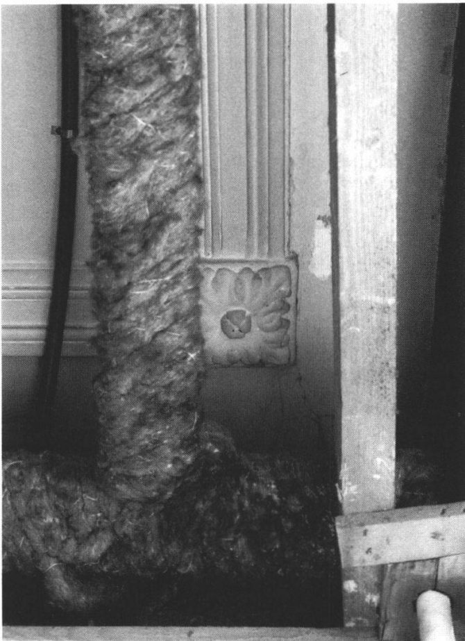
Abb. 4: Blick in eine Sondieröffnung während der Bauuntersuchung. Über der Fastäferdecke aus den 1970er Jahren kommt die spätbiedermeierliche Gipsdecke zum Vorschein (vgl. Abb. 9).
