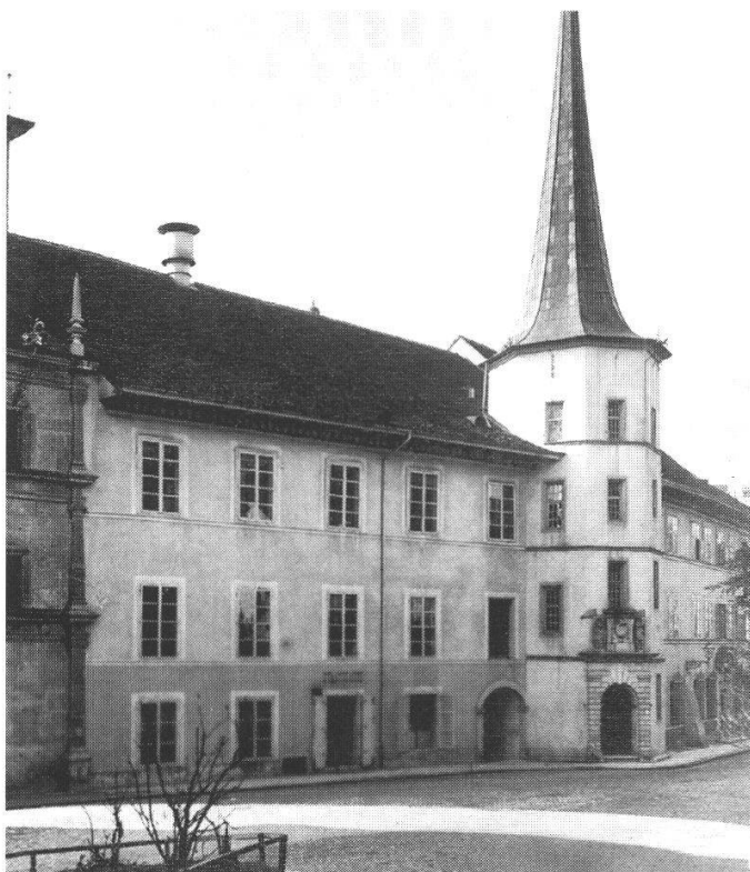
Abb. 2: Treppenturm und Ostabschnitt der Nordfassade, Zustand um 1900...
