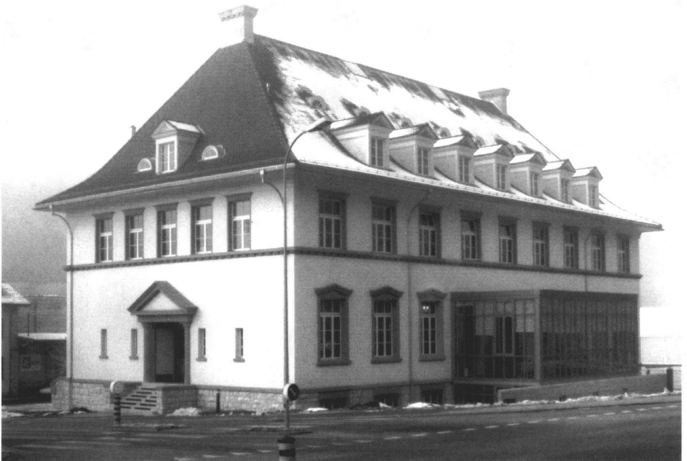
Abb. 4: Der Schmelzihof heute, nach Umbau und Restaurierung.
