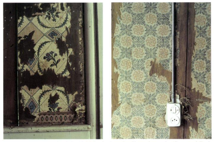
Abb. 7/8: Tapetenreste aus dem frühen 19. Jahrhundert im zweiten Obergeschoss an der Alkovenwand, Fundzustand.
