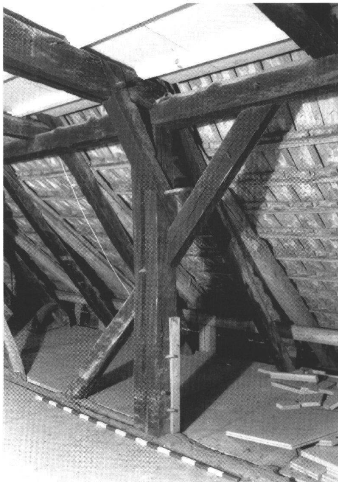
Abb. 1: Pfosten mit Zug- und Druckbug, die in die Mittelpfette, die Fusschwelle und das Kehlgebälk eingebettet und mit einem Holznagel gesichert sind.
