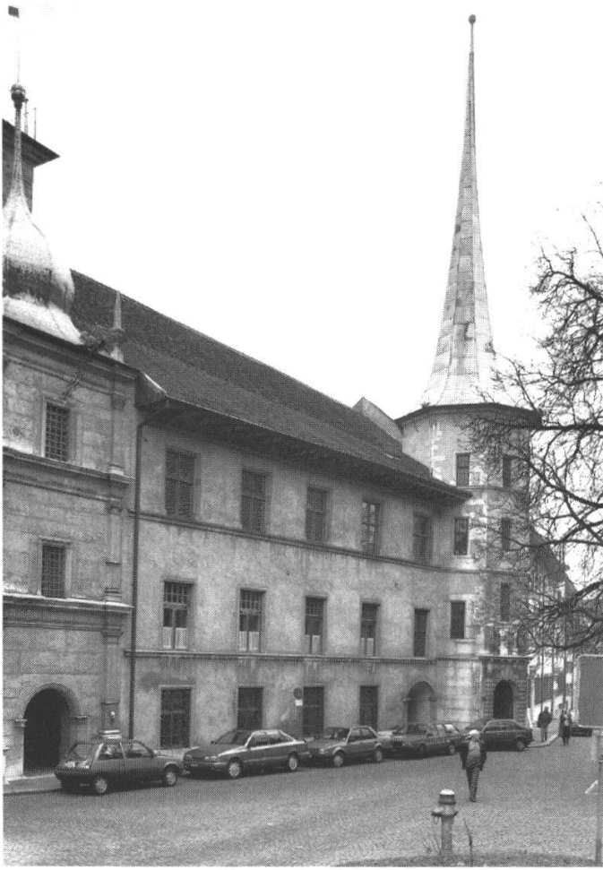
Abb. 4: Treppenturm und Ostabschnitt der Nordfassade, Zustand 1963–1990...
