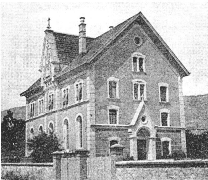
Abb. 2: Aufnahme aus der Zeit kurz nach der Erbauung.
