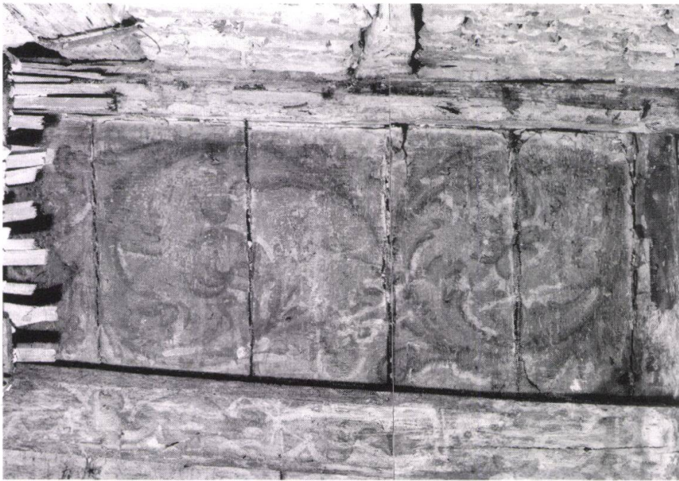
Abb. 13 a. Kammerdecke im ersten Obergeschoss. Über der Gipsdecke des 18. Jahrhunderts erscheint eine Balkendecke mit Rankenmalereien aus dem späten 17. Jahrhundert (1692?).
