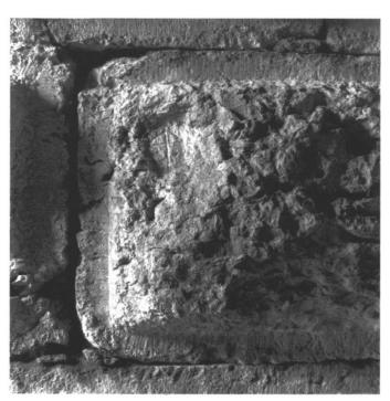
Abb. 5: Ausschnitt aus einem Bossenquader an der Südseite des Riedholzturms. Oben links ist im Bossen eine kleine flache Vertiefung zu erkennen, darin ein armbrustförmiges Steinmetzzeichen.
