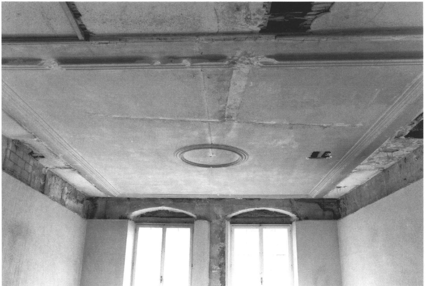
Abb. 9: Die spätbiedermeierliche Stubendecke im zweiten Obergeschoss nach Abbruch der Einbauten aus den 1970er Jahren (vgl. Abb. 4).
