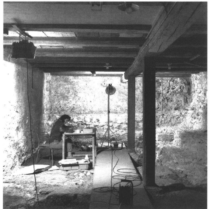
Abb. 1: Blick nach Osten, in den Stallteil von Riedholzplatz Nr. 32. Im bis 1990 als Keller genutzten Parterterraum sind im Hintergrund die Fundamentreste des 1546 explodierten Nydeggturms zu erkennen.
