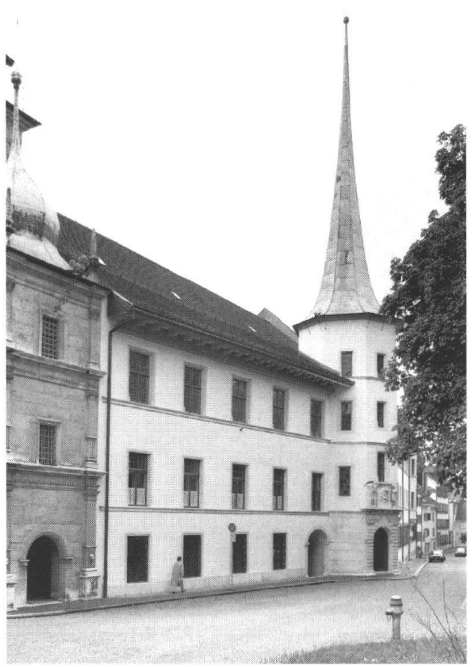
Abb. 5: ... und nach der Renovation von 1990/91.
