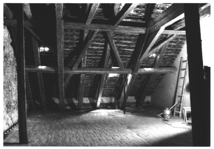
Abb. 14: Dachkonstruktion auf dem Haus Riedholzplatz Nr. 32 (Wohnteil). Innenansicht Ostseite mit Windverstrebungen.
