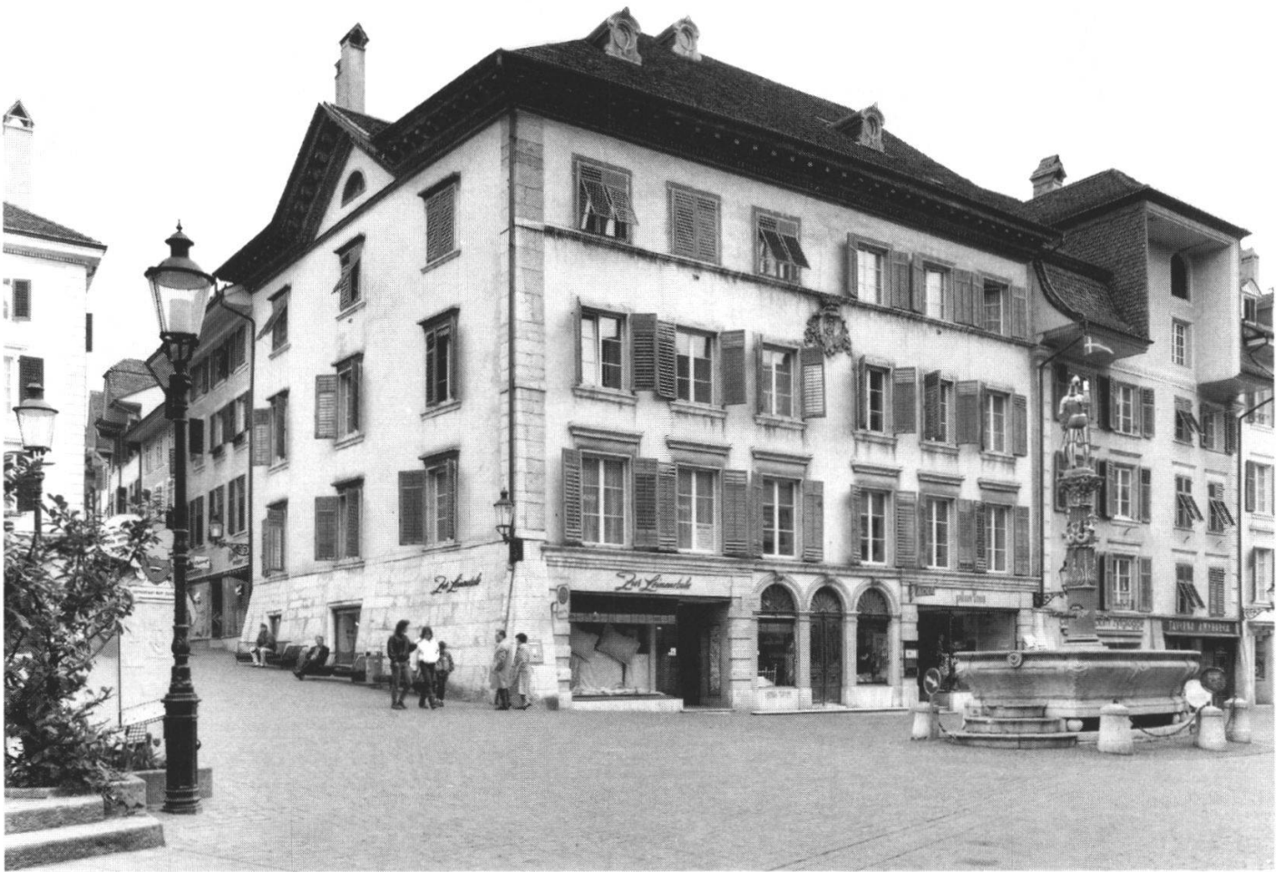
Abb. 1: Das Haus Hauptgasse Nr. 47 vor ...
