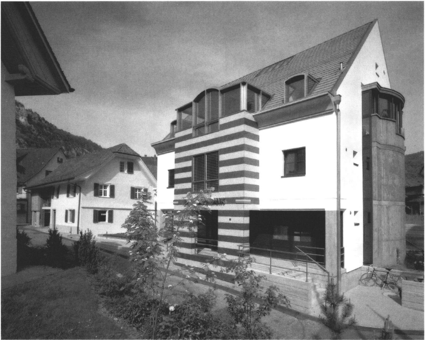
Abb. 6: Exemplarische Verbindung von restauriertem Altbau und zeitgemäßem Neubau bei der Raiffeisenbank an der Goldgasse in Balsthal.
