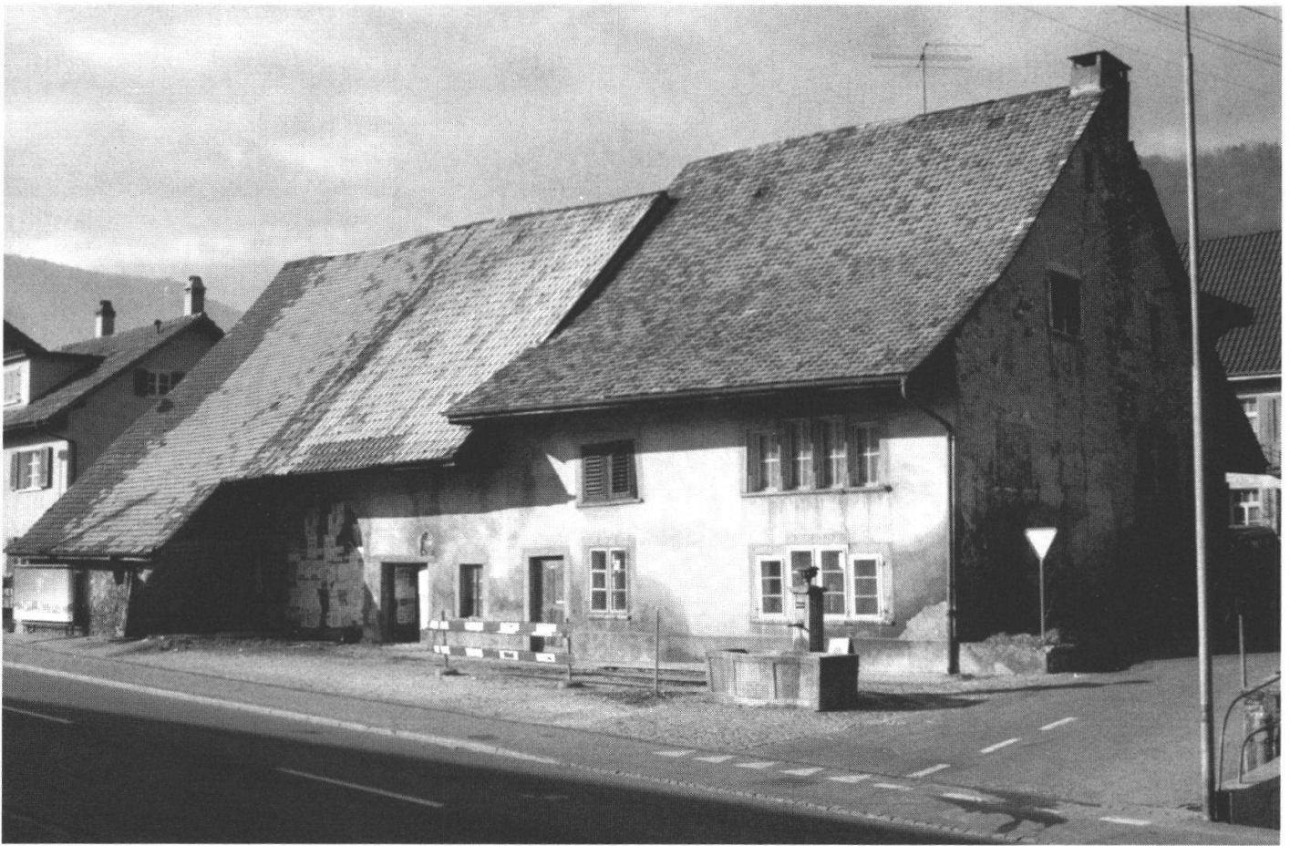
Abb. 1: Das Haus Oensingen Hauptstrasse Nr. 47, 1989, vor dem Umbau ...
