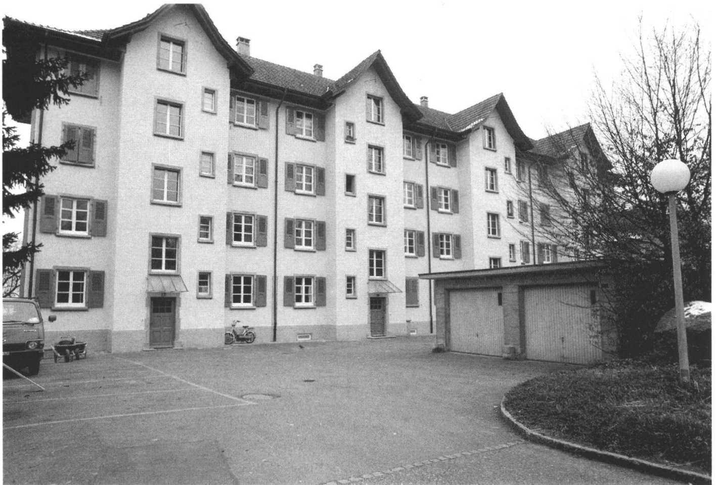
Abb. 2: Die Nordfassade an der Promenadenstrasse.
