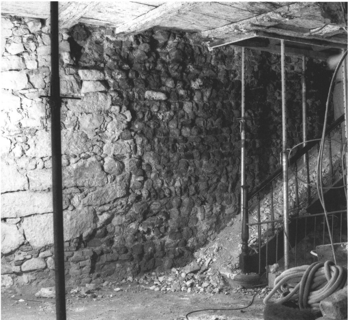
Abb. 6: Erdgeschoss, Partie der westlichen Brandmauer aus kleinen Bollensteinen (mittelalterlich, 13. Jh.?). Links grössere Quaderstücke, mit der die Mauer beim Hausneubau im 16. Jahrhundert geflickt wurde.
