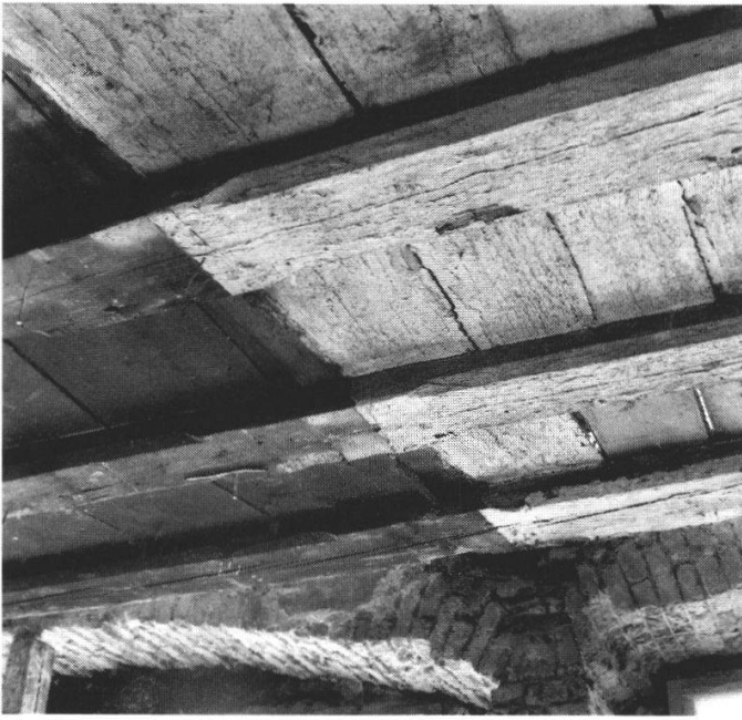
Abb. 5: Ausschnitt aus der Balkendecke über den gassenseitigen Zimmern im ersten Obergeschoss. Links die Stubendecke mit rotbraunem Lasuranstrich, die wahrscheinlich im 17. Jahrhundert mit einer heruntergehängten Täferdecke verdeckt wurde. Rechts die Decke über der Nebenkammer. Hier fanden sich über der Gipsdecke des 18. Jahrhunderts vier Fassungen übereinander, nämlich als älteste 1. ein braunrötlicher Lasuranstrich (16. Jh.), dann 2. eine Überklebung mit einer gedruckten Holzmasertapete mit Zierstreifen (um 1600, vgl. Abb. 14), dann 3. eine Dekorationsmalerei mit Rankenwerk (um 1690, vgl. Abb. 13) und schliesslich der auf der Foto sichtbare weisse Kalkanstrich (Mitte 18. Jh.).
