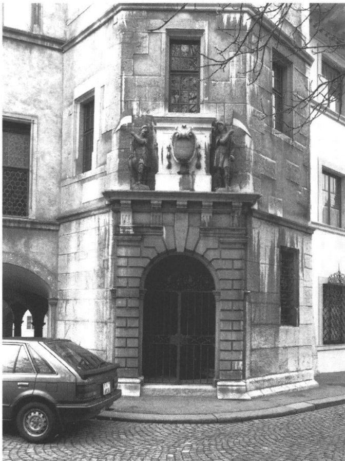
Abb. 6: Eingangspartie des Treppenturms vor ...
