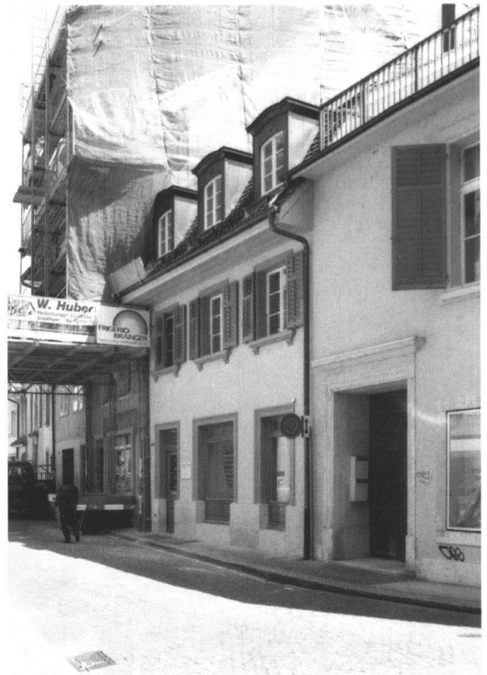
Abb. 11: ... und nach der Sanierung.
