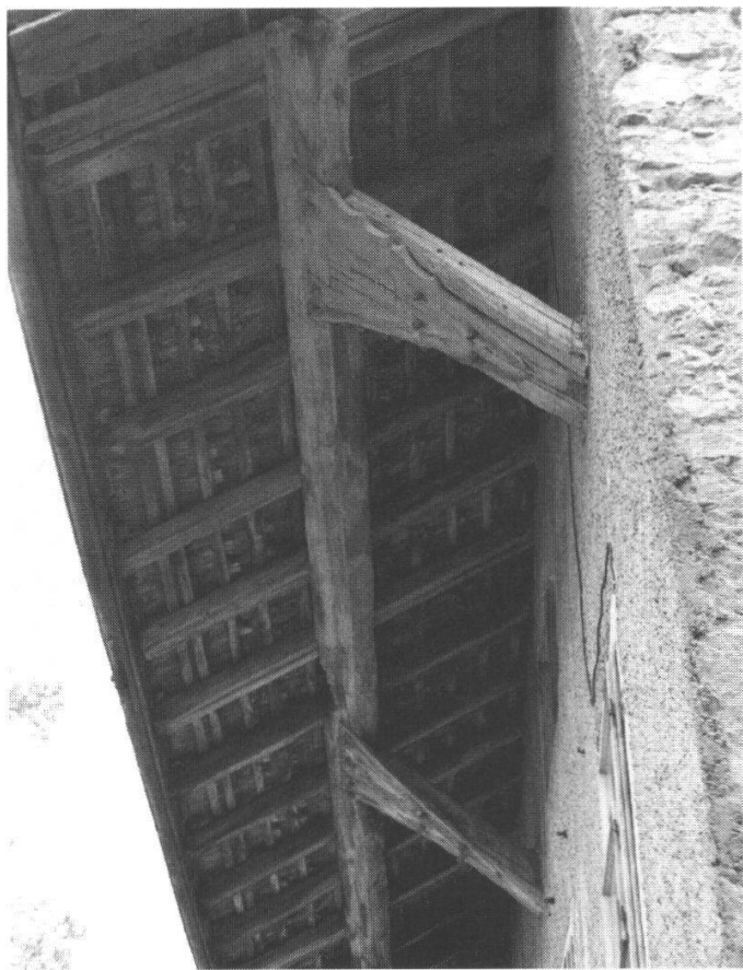
Abb. 4: Südseite, Stützstreben mit Brettbügel, die die Flugpfette abfangen. Sie gehören zur älteren Dachkonstruktion von etwa 1550.
