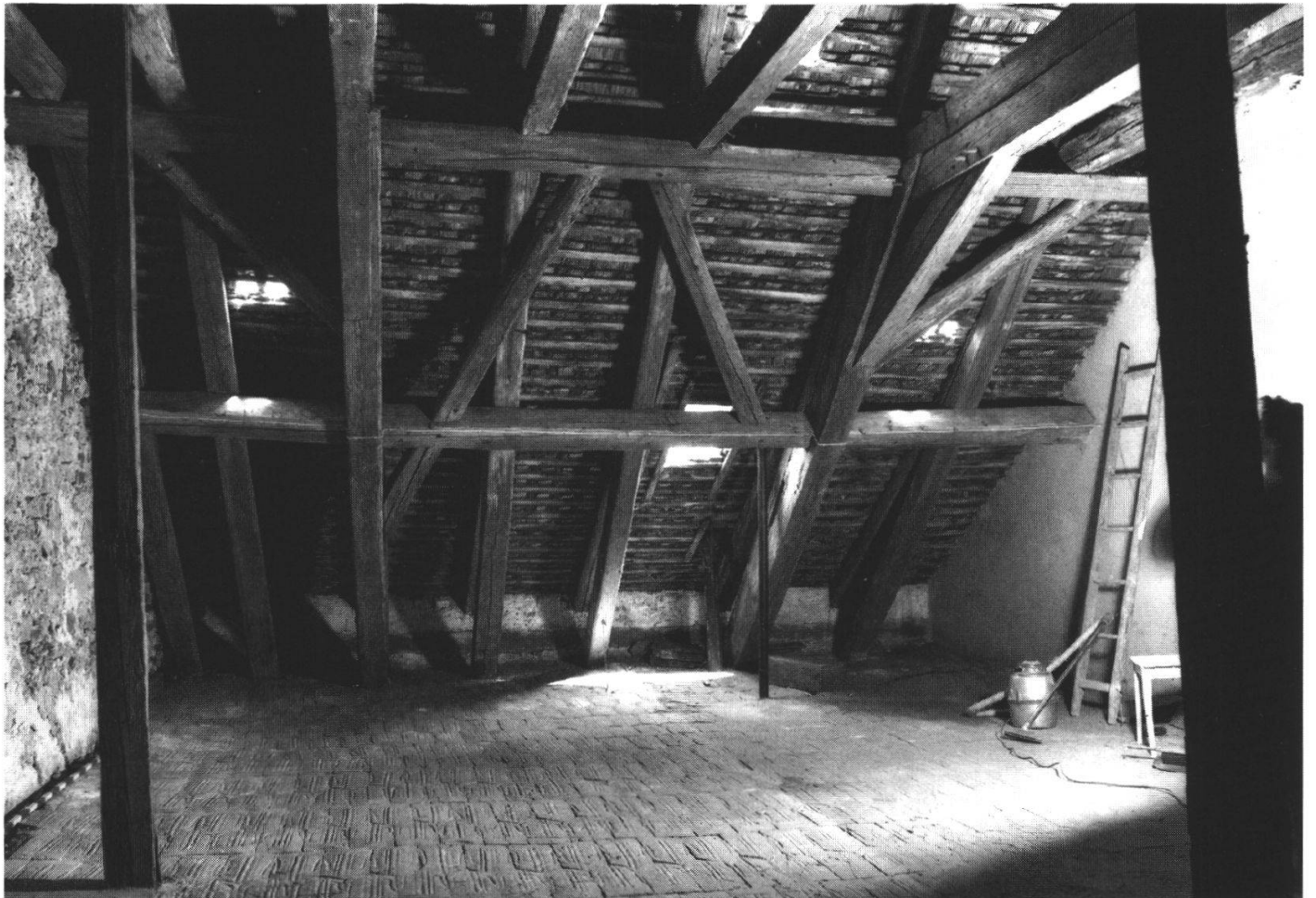
Abb. 14: Dachkonstruktion auf dem Haus Riedholzplatz Nr. 32 (Wohnteil). Innenansicht Ostseite mit Windverstrebrungen.
