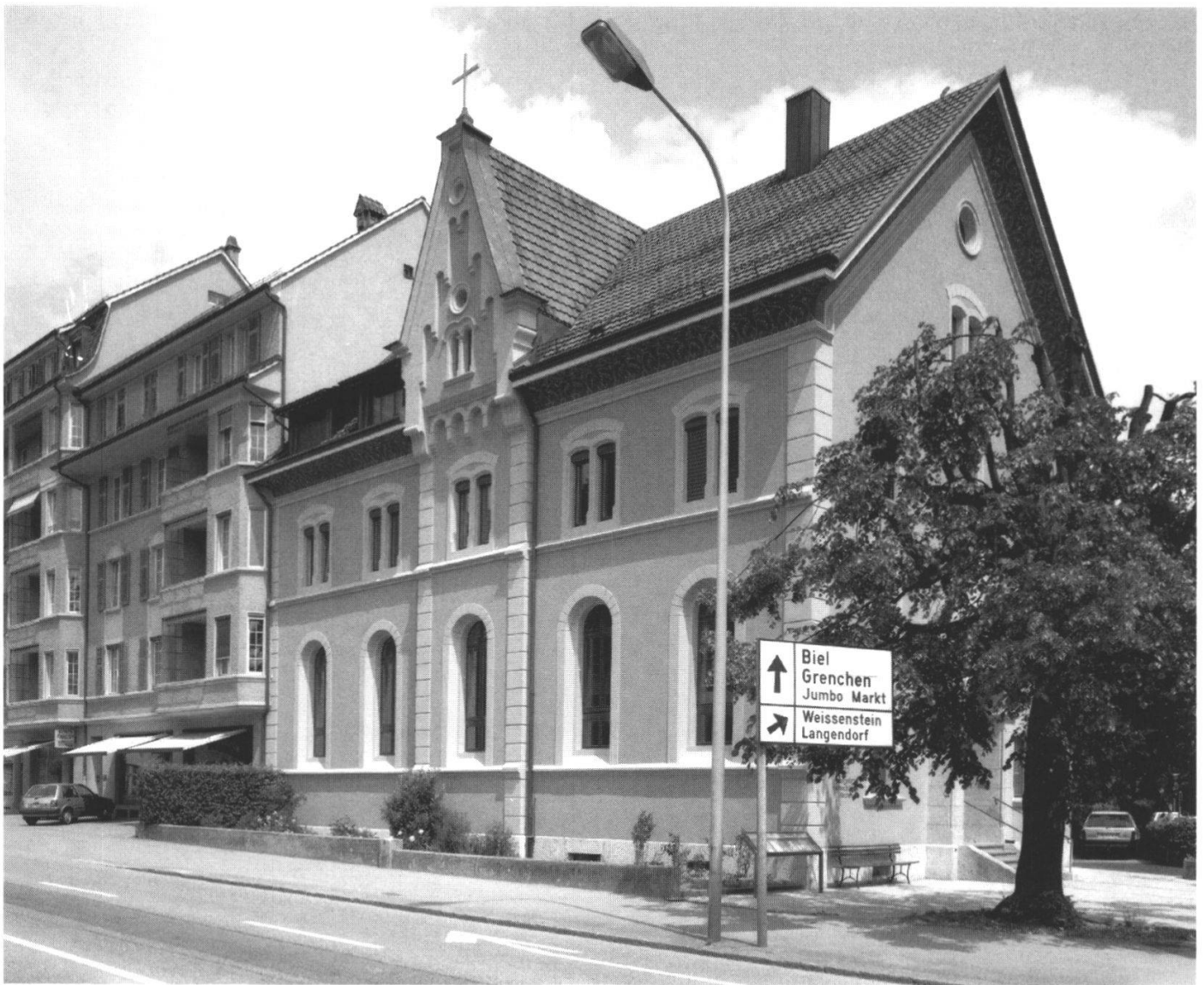
Abb. 1: Solothurn, Kapelle der Evangelisch-methodistischen Kirche. Nach der Renovation von 1991.
