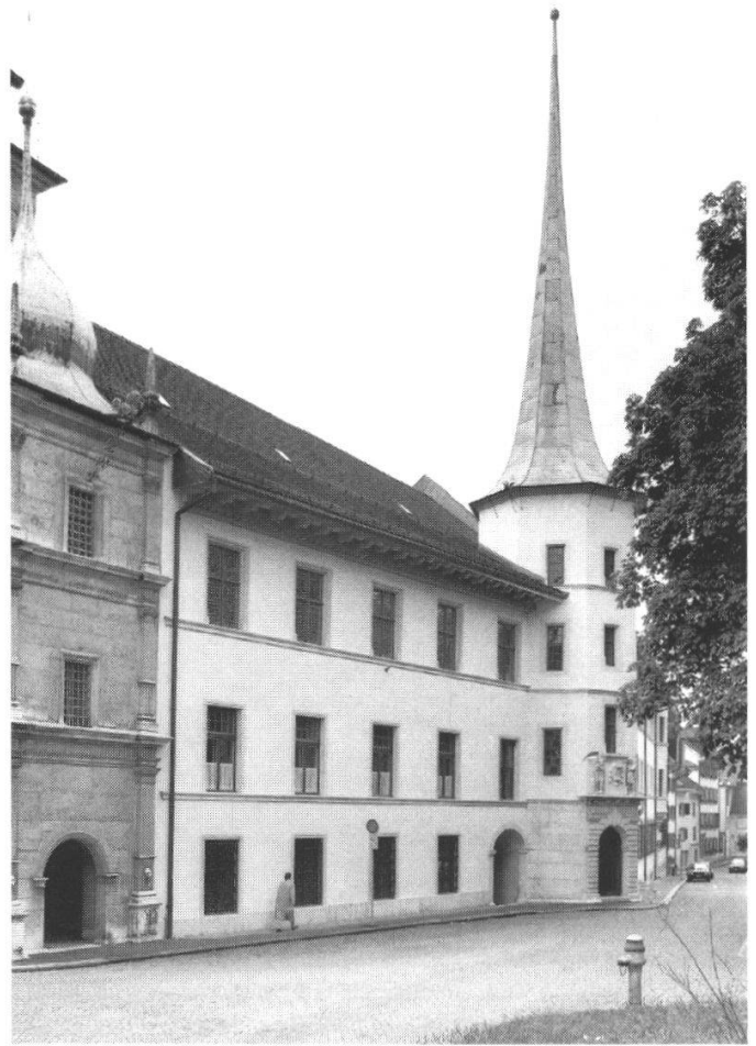
Abb. 5: ... und nach der Renovation von 1990/91.
