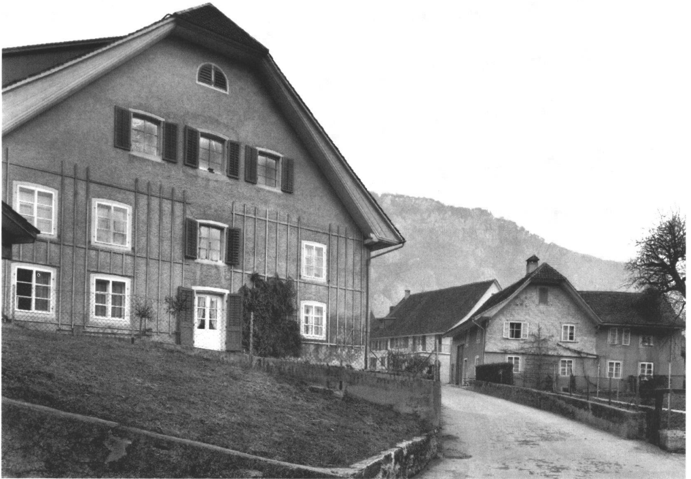
Abb. 1: Balsthal. Die Goldgasse mit den Häusern Nr. 17 («Hübeli», links) und Nr. 18 (rechts) in den 1950er Jahren.
