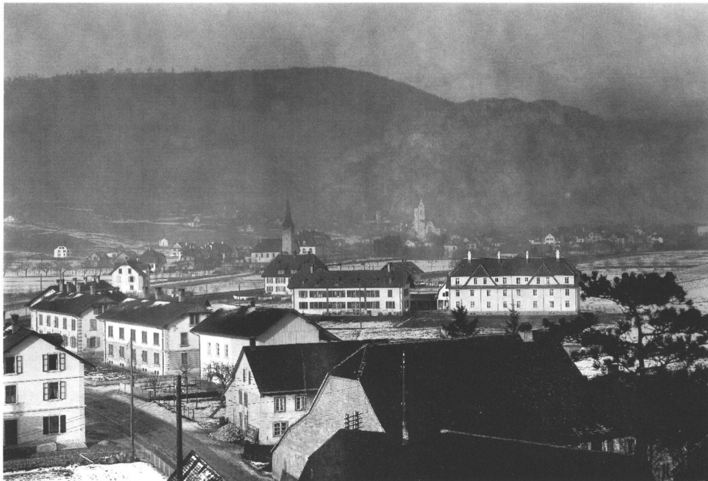
Abb. 1: Balsthal. Die Solothurnerstrasse nördlich der Klus, im Hintergrund die reformierte und die katholische Kirche. In der Bildmitte links die Häuser Thalbruggweg Nr. 6 und Nr. 8, rechts die Doppelhäuser Wyssenfluhweg Nrn. 4/6 und Nrn. 8/10. Historische Aufnahme um 1920.
