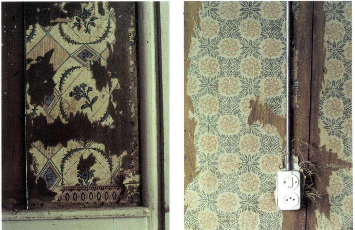
Abb. 7/8: Tapetenreste aus dem frühen 19. Jahrhundert im zweiten Obergeschoss an der Alkovenwand, Fundzustand.
