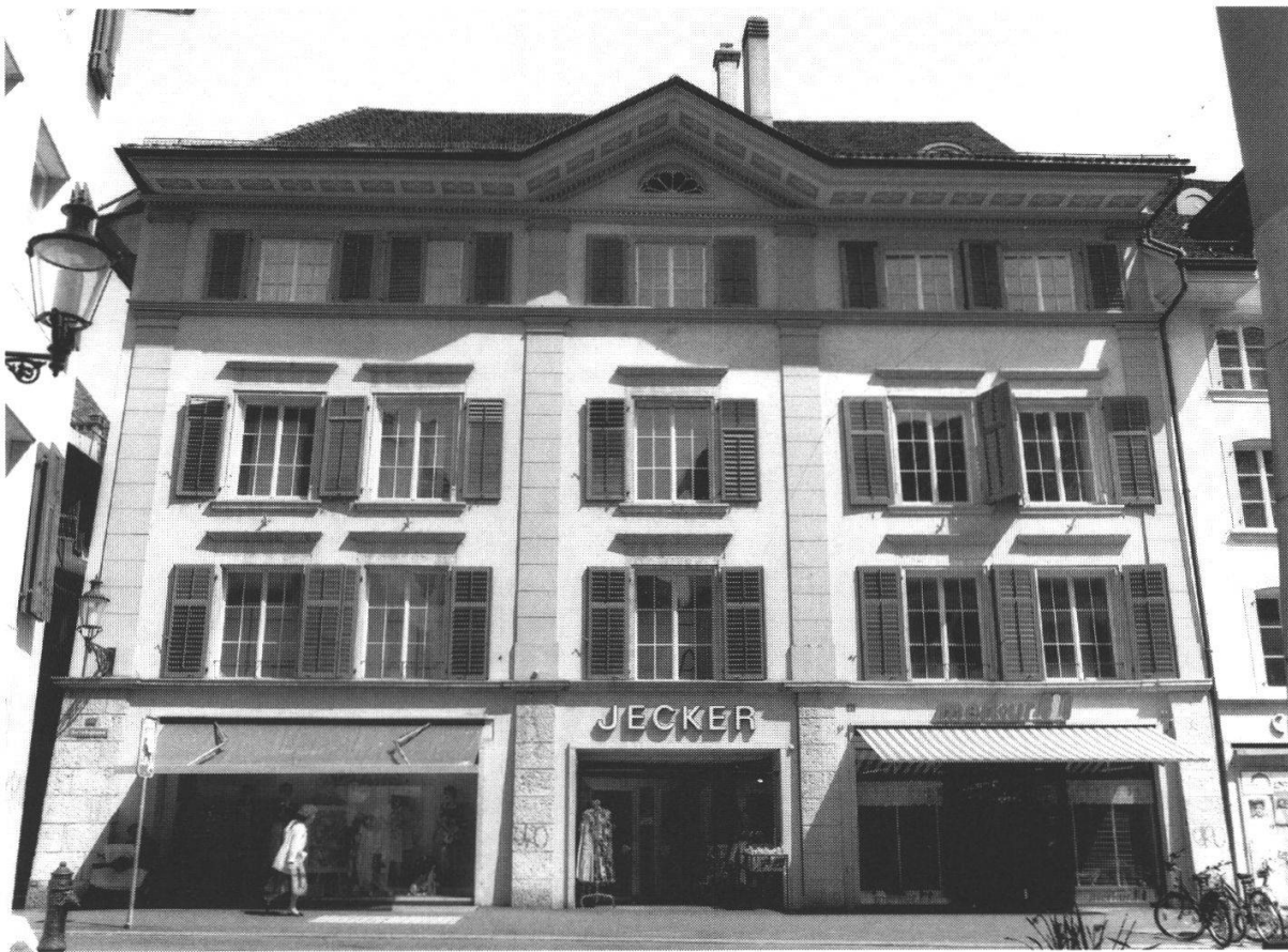
Abb. 1: Die durch eine einheitliche Fassadengestaltung zusammengefassten Häuser Gurzelngasse Nr. 36 und Nr. 38.
