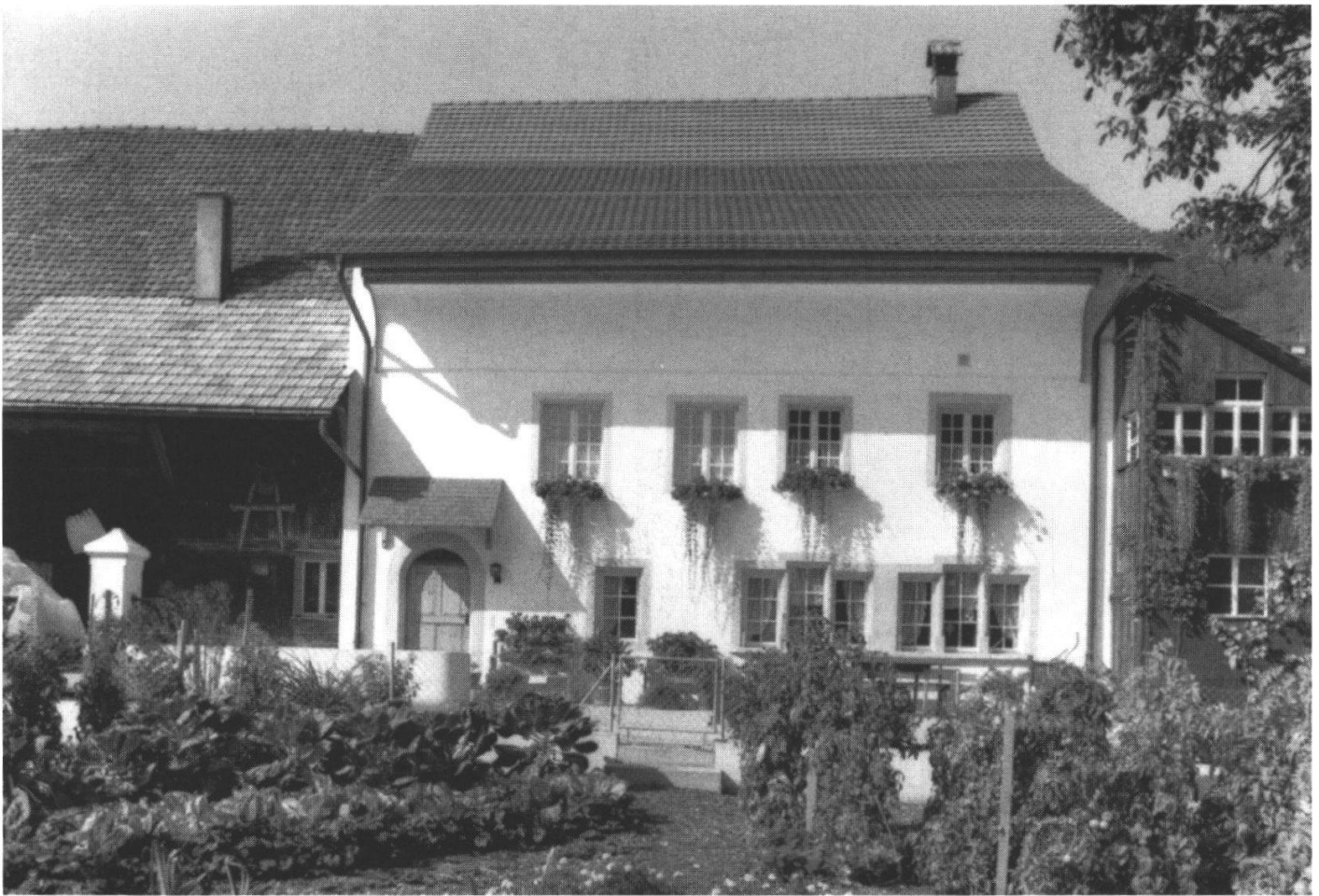
Abb. 2: ... und 1991 nach dem Abschluss der Arbeiten.
