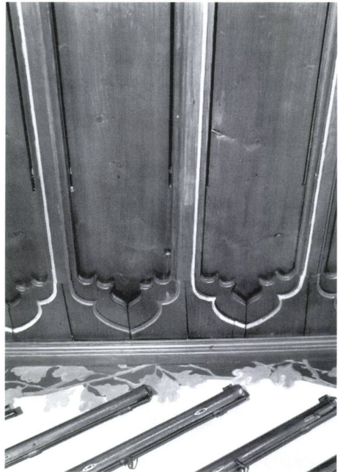
Abb. 4: Deckendetail im Restaurant, Erdgeschoss.
