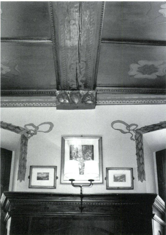
Abb. 5: Deckendetail im Speiserestaurant, erstes Obergeschoss.
