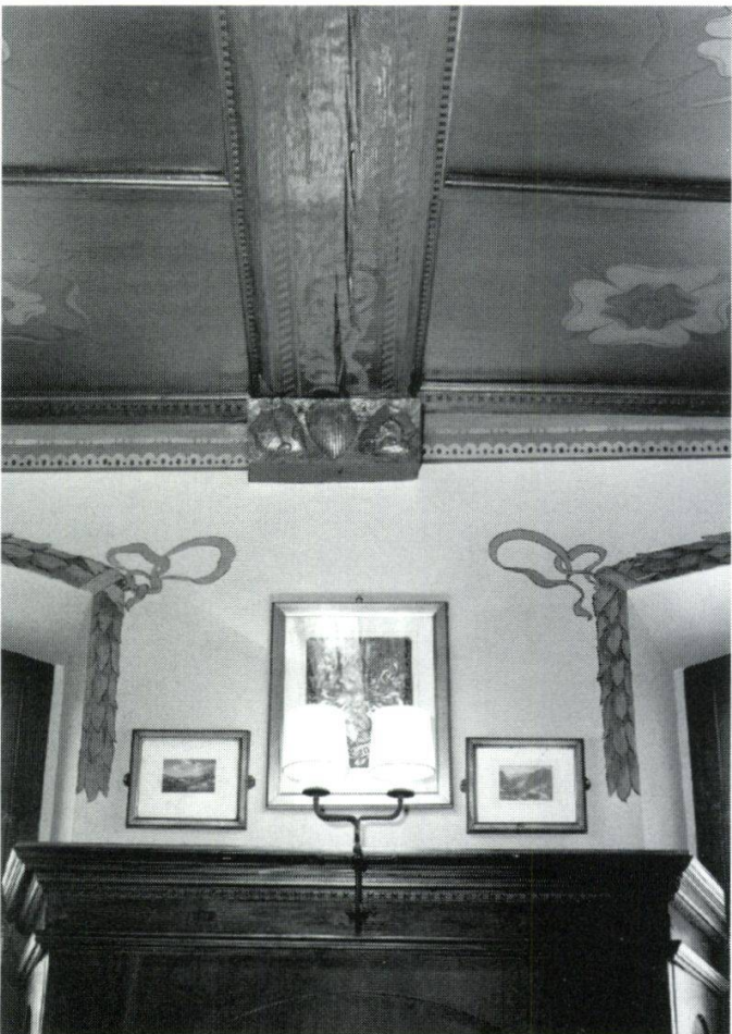
Abb. 5: Deckendetail im Speiserestaurant, erstes Obergeschoss.
