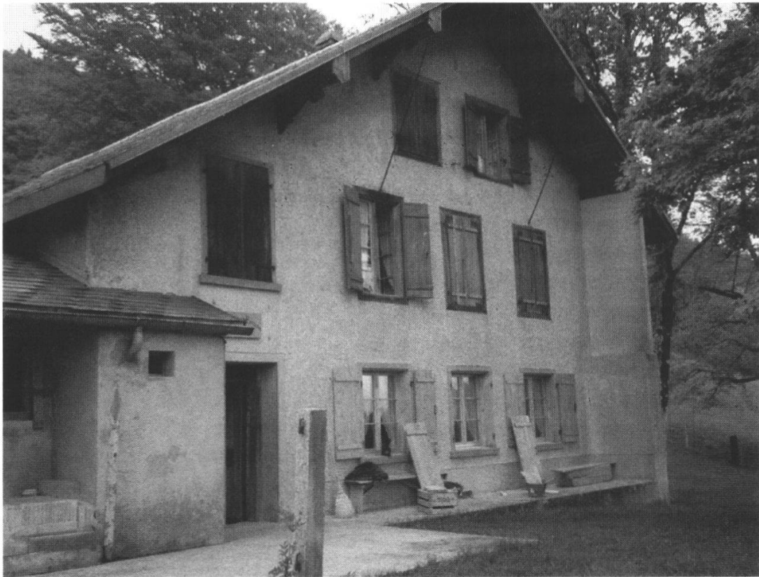
Abb. 18: Vorderes Hofbergli, 1990. Foto: Verfasser. Oben: Südansicht. Unten: Renovationsarbeiten
