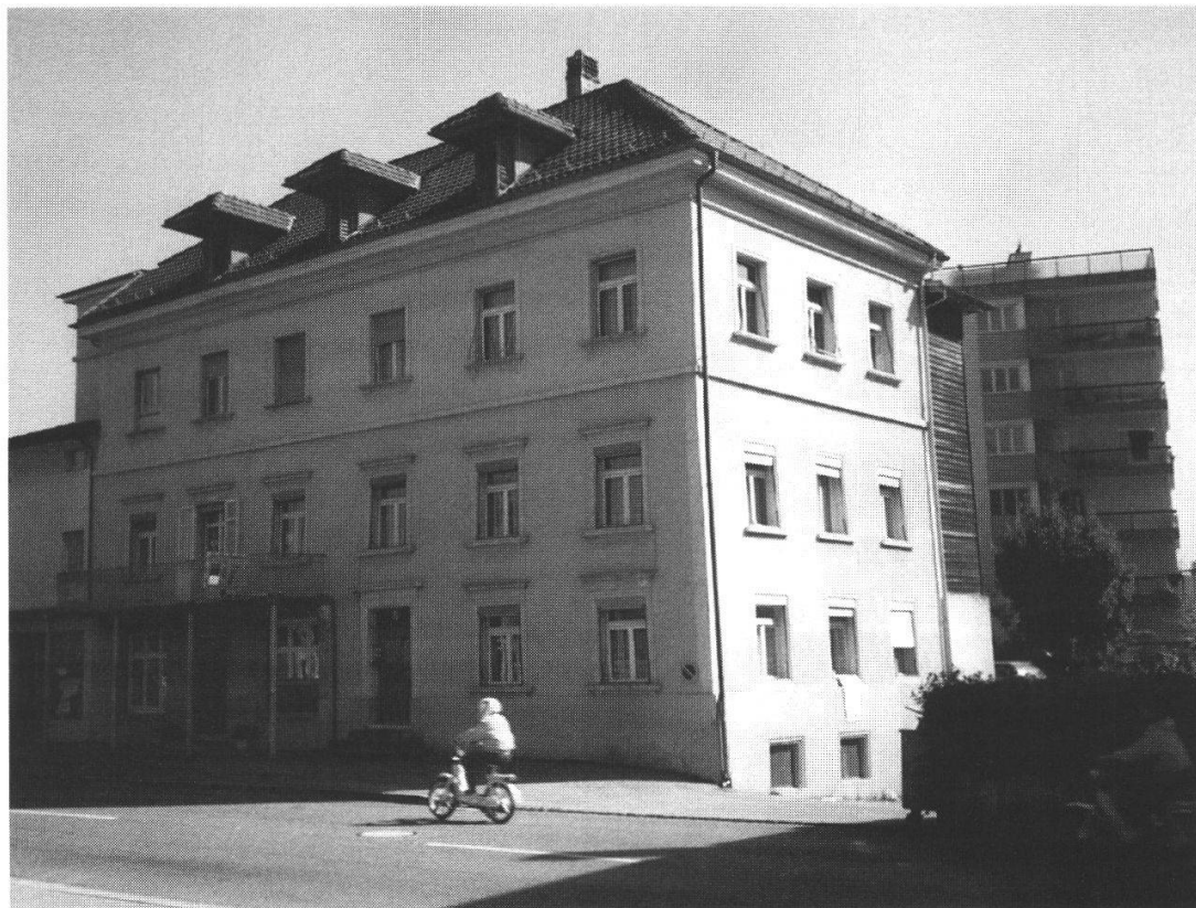
Abb. 12: Möllinger-Haus in der Ischeren, Zuchwilerstrasse 84, Solothurn. Das dritte Stockwerk und die Anbauten sind aus dem 20. Jahrhundert. – Oben: Rückfront. Unten: Strassenfront. Foto: Verfasser.
