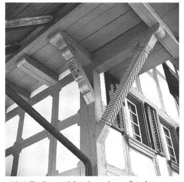
Abb. 4: Dachuntersicht mit verzierten Stützbögen.
