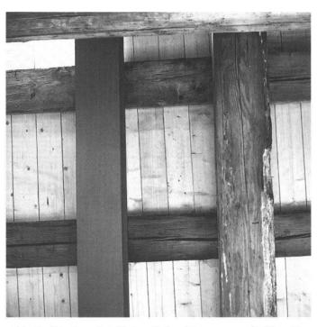
Abb. 8: Deckendetail im Schmitteraum mit Verstärkung durch einen Stahlträger.
