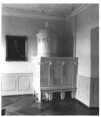
Abb. 9: Der weiss glasierte Turmofen aus dem späten 18. Jahrhundert an seinem neuen Standort in der Stube im 1. OG des «Glutzenhübeli» (bis 1976 stand er im Haus Weberngasse 2 in Solothurn).
