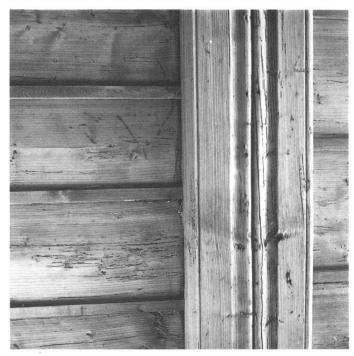
Abb. 7: Deckendetail mit profiliertem Deckenträger in der Stube.
