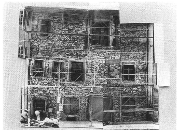
Abb. 2: Fassade Rathausgasse 8, nach dem Entfernen des Verputzes, Fotomontage.
