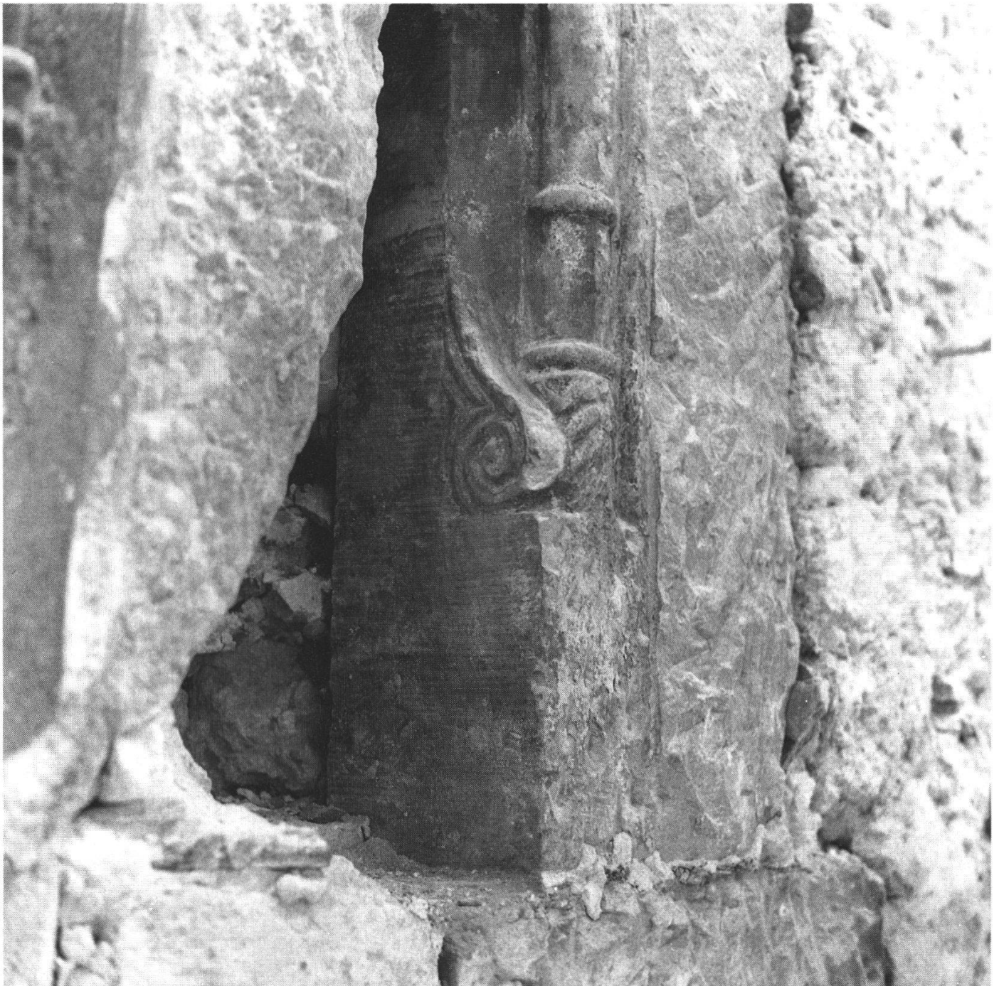
Abb. 5: Detail vom ehemaligen Saalfenster im 2. Obergeschoss, Profilanlauf.
