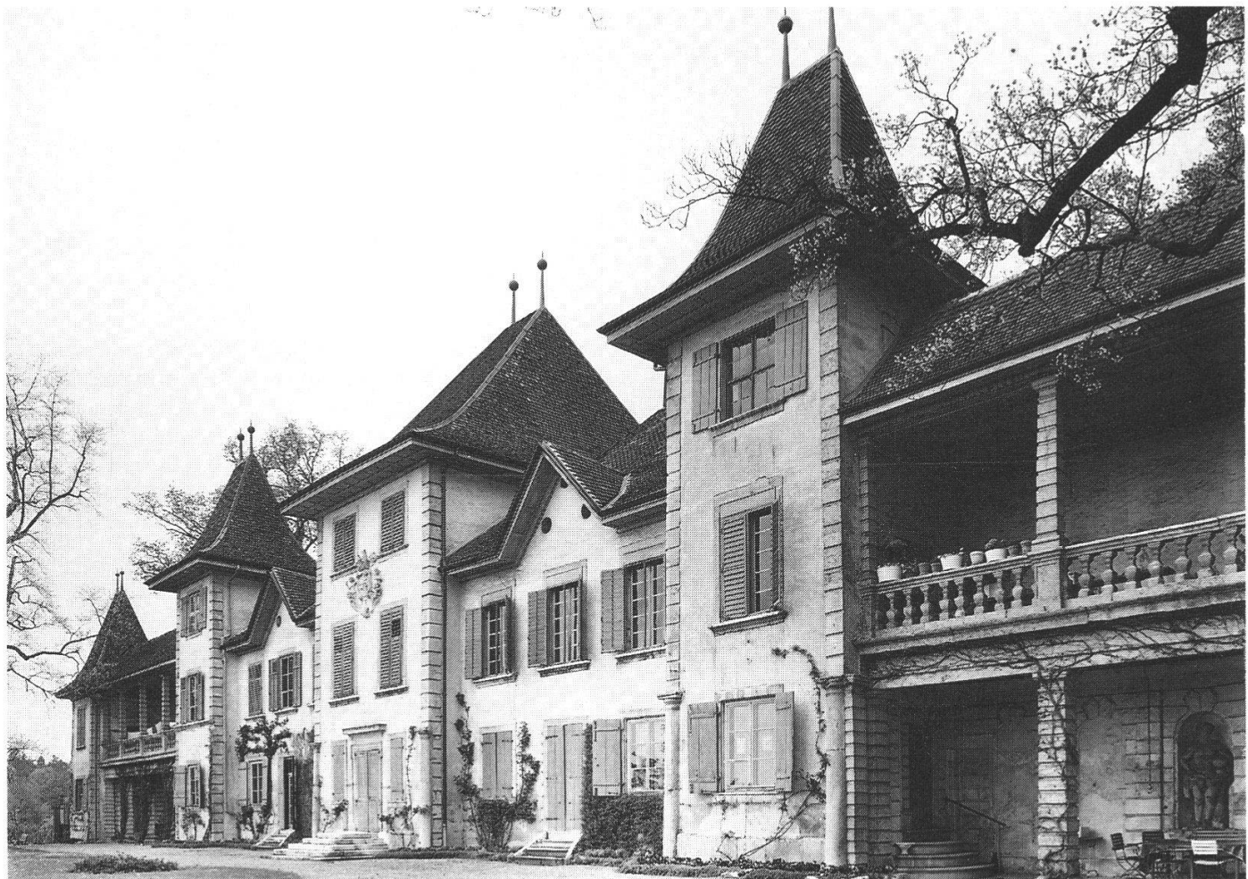
Schloss Waldegg. Die Südfassade vor der Restaurierung. Aufnahme aus dem Jahre 1978.
