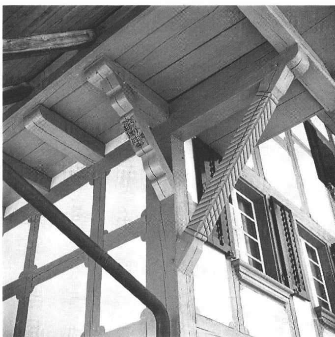
Abb. 4: Dachuntersicht mit verzierten Stützbögen.
