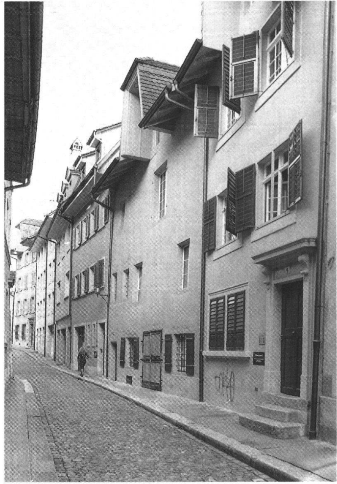
Abb. 7: ...und nach der Erneuerung von 1989/90.
