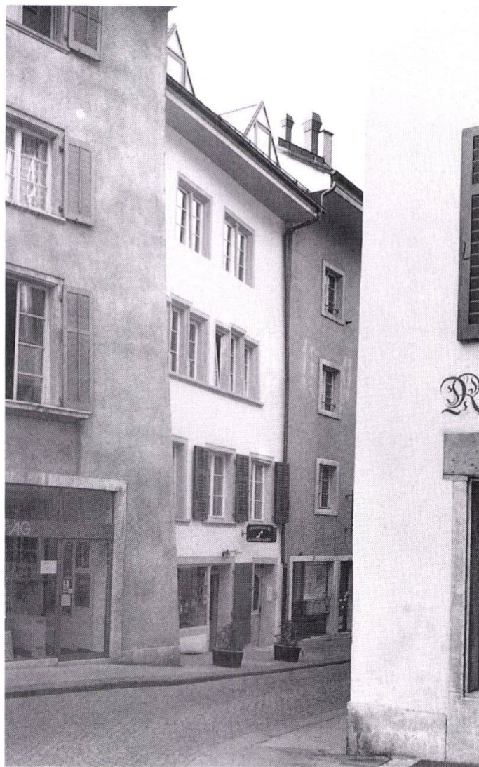
Abb. 3: Nordfassade an der Gerberngasse nach der Renovation.
