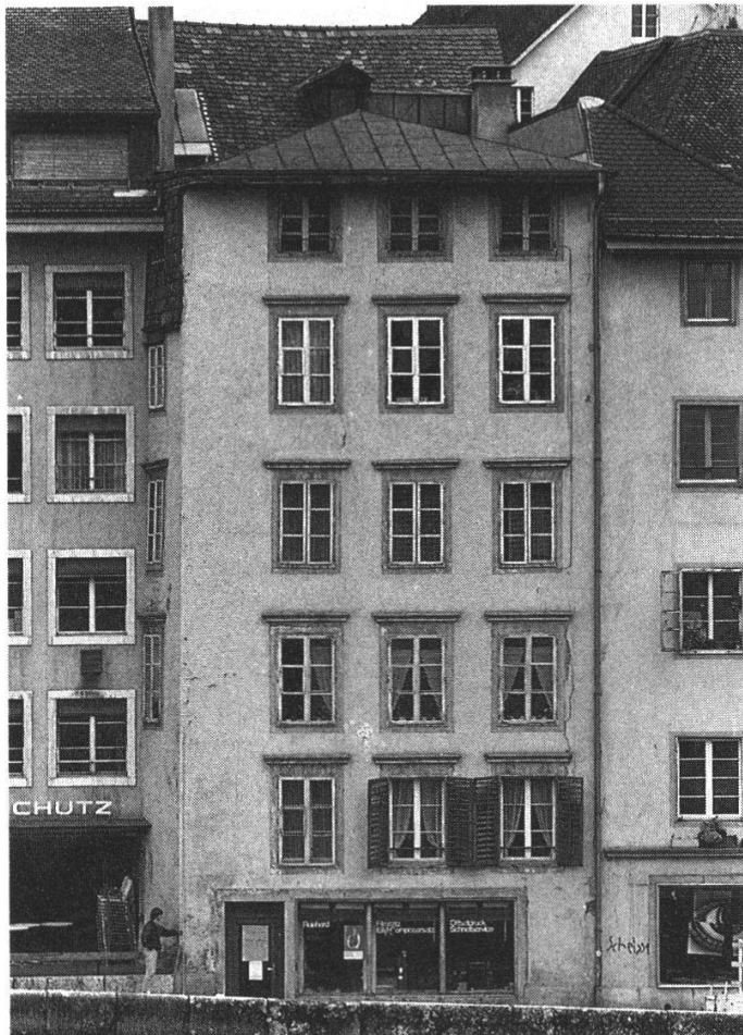
Abb. 1: Die Südfassade am Landhausquai, vor dem Dachumbau (1988).
