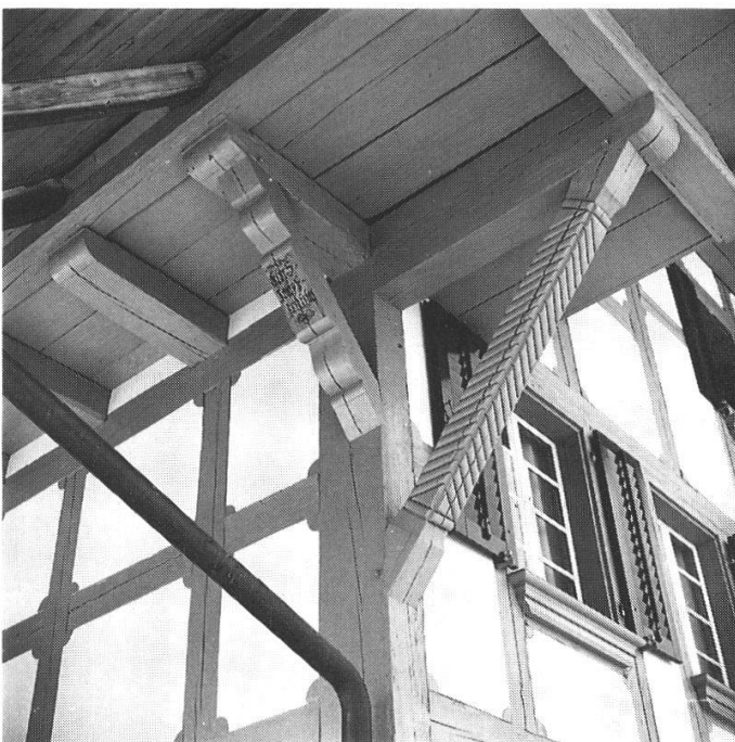
Abb. 4: Dachuntersicht mit verzierten Stützbögen.
