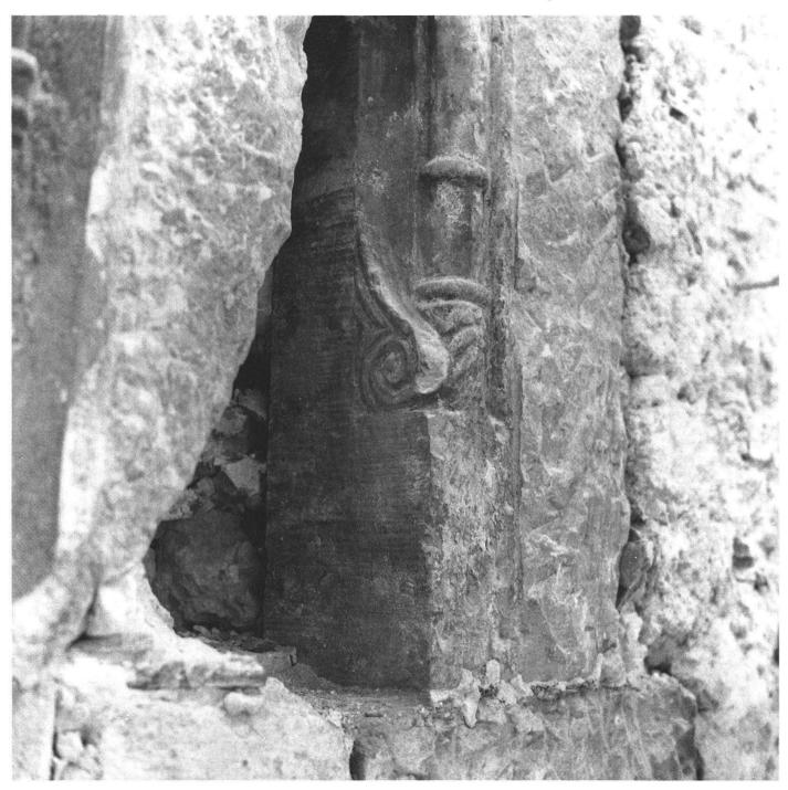
Abb. 5: Detail vom ehemaligen Saalfenster im 2. Obergeschoss, Profilanlauf.
