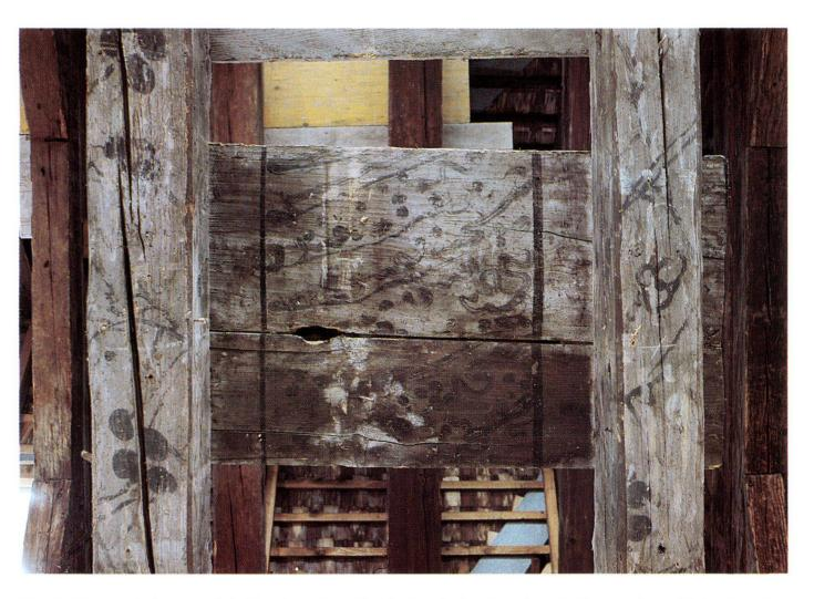
Abb. 2: Fragment der «en Grisaille» bemalten Holzbalkendecke über dem 2. Obergeschoss. Wahrscheinlich von 1682. Fundzustand 1989.
