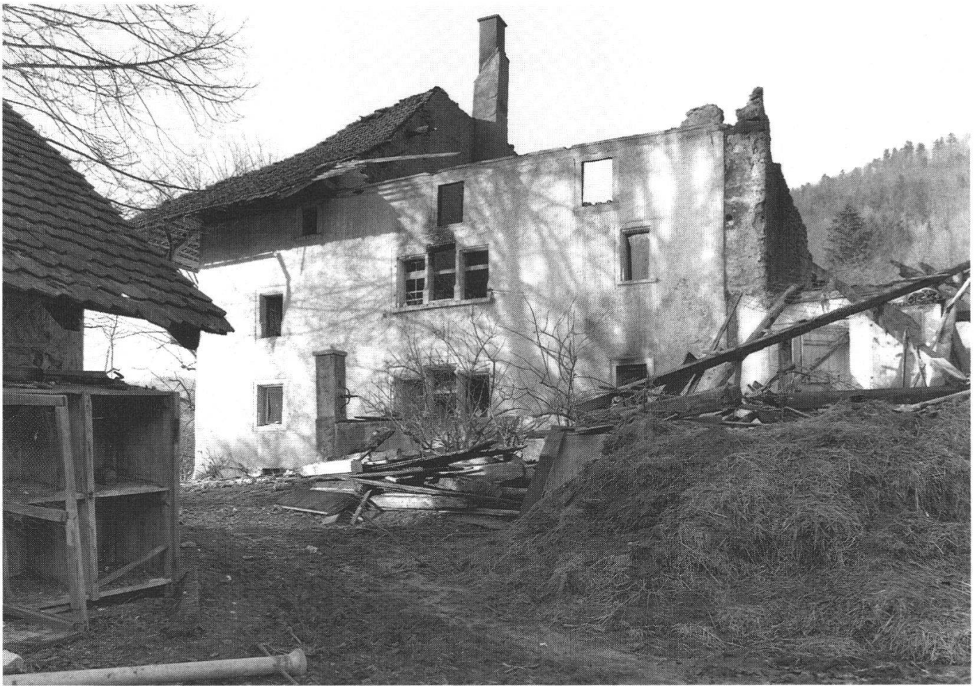
Abb. 6: Zustand nach dem Brand.
