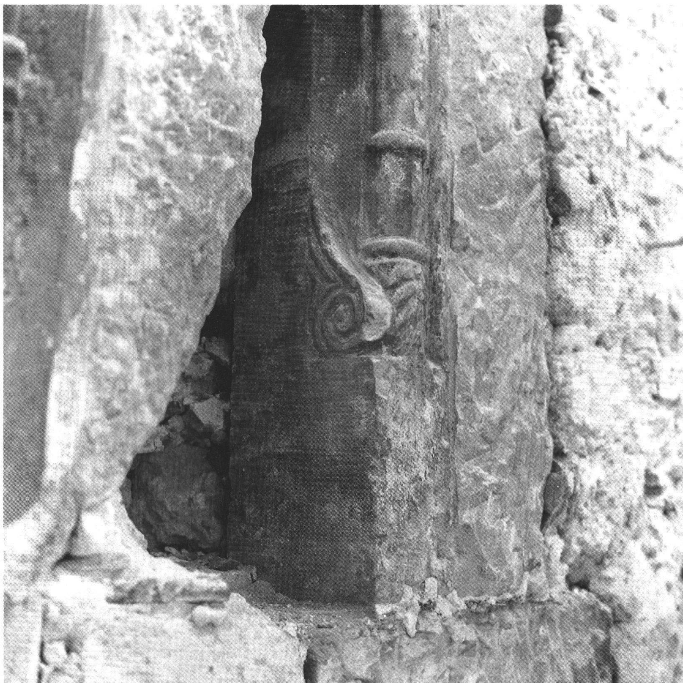
Abb. 5: Detail vom ehemaligen Saalfenster im 2. Obergeschoss, Profilanlauf.
