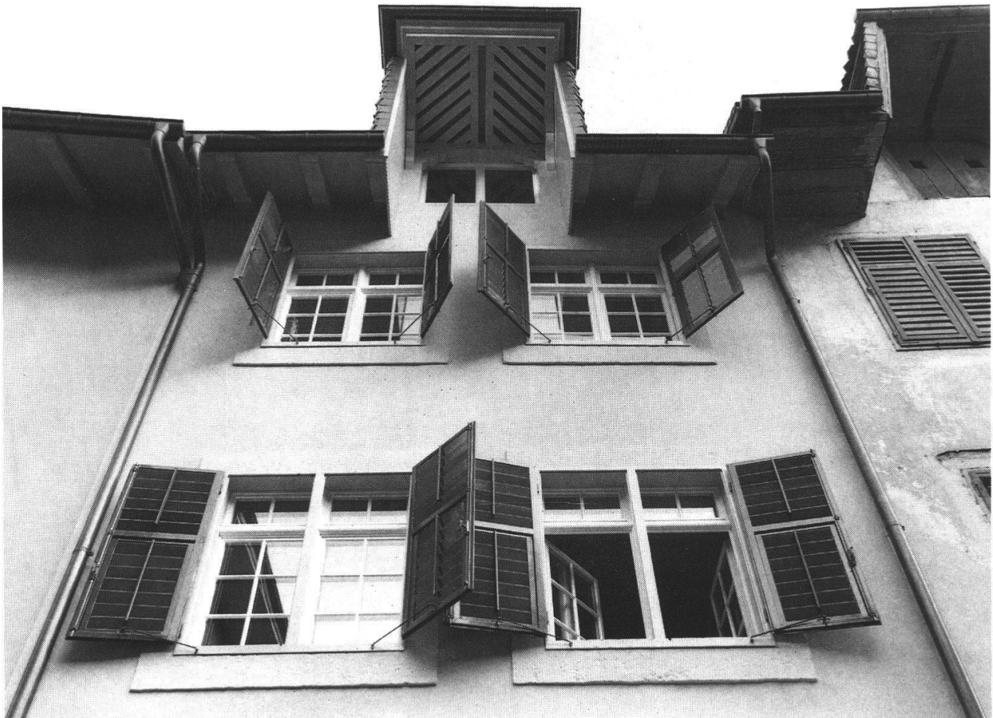
Abb. 11: Fassade nach der Rathausgasse. Obergeschoss, Dachuntersicht und Aufzuggiebel nach der Renovation.
