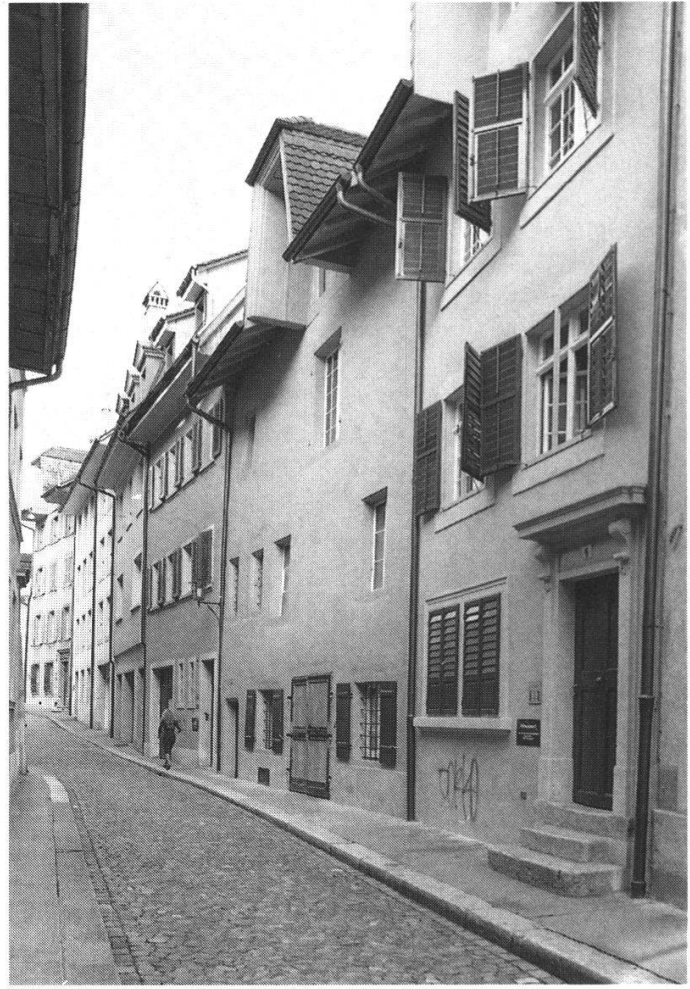
Abb. 7: ...und nach der Erneuerung von 1989/90.
