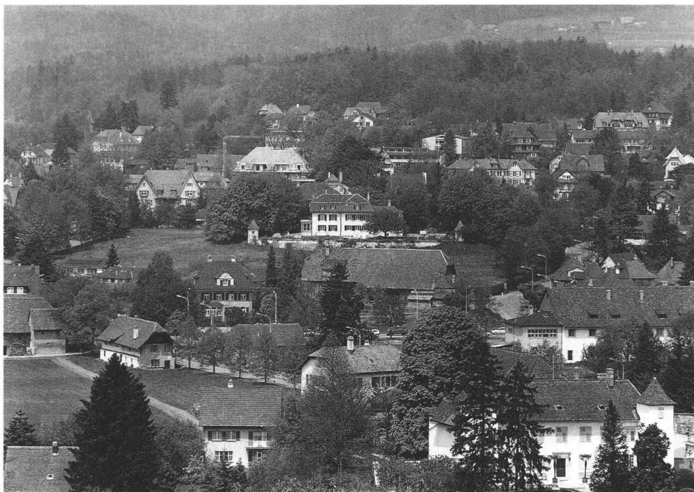
Abb. 1: Das Sommerhaus «Glutzenhübeli», Südansicht nach der Restaurierung von 1989/90.
