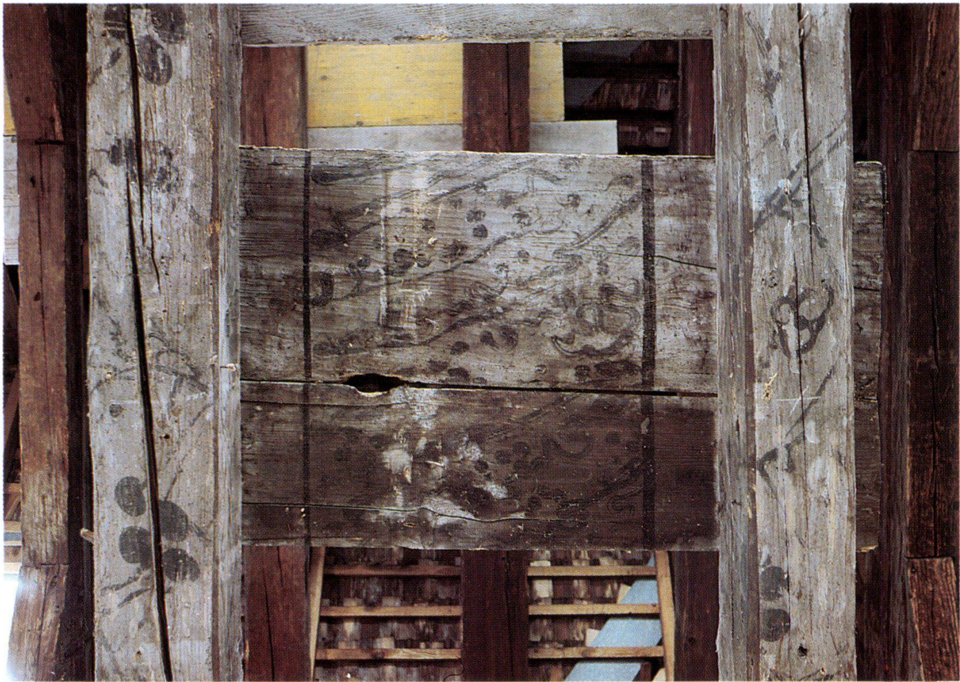
Abb. 2: Fragment der «en Grisaille» bemalten Holzbalkendecke über dem 2. Obergeschoss. Wahrscheinlich von 1682. Fundzustand 1989.
