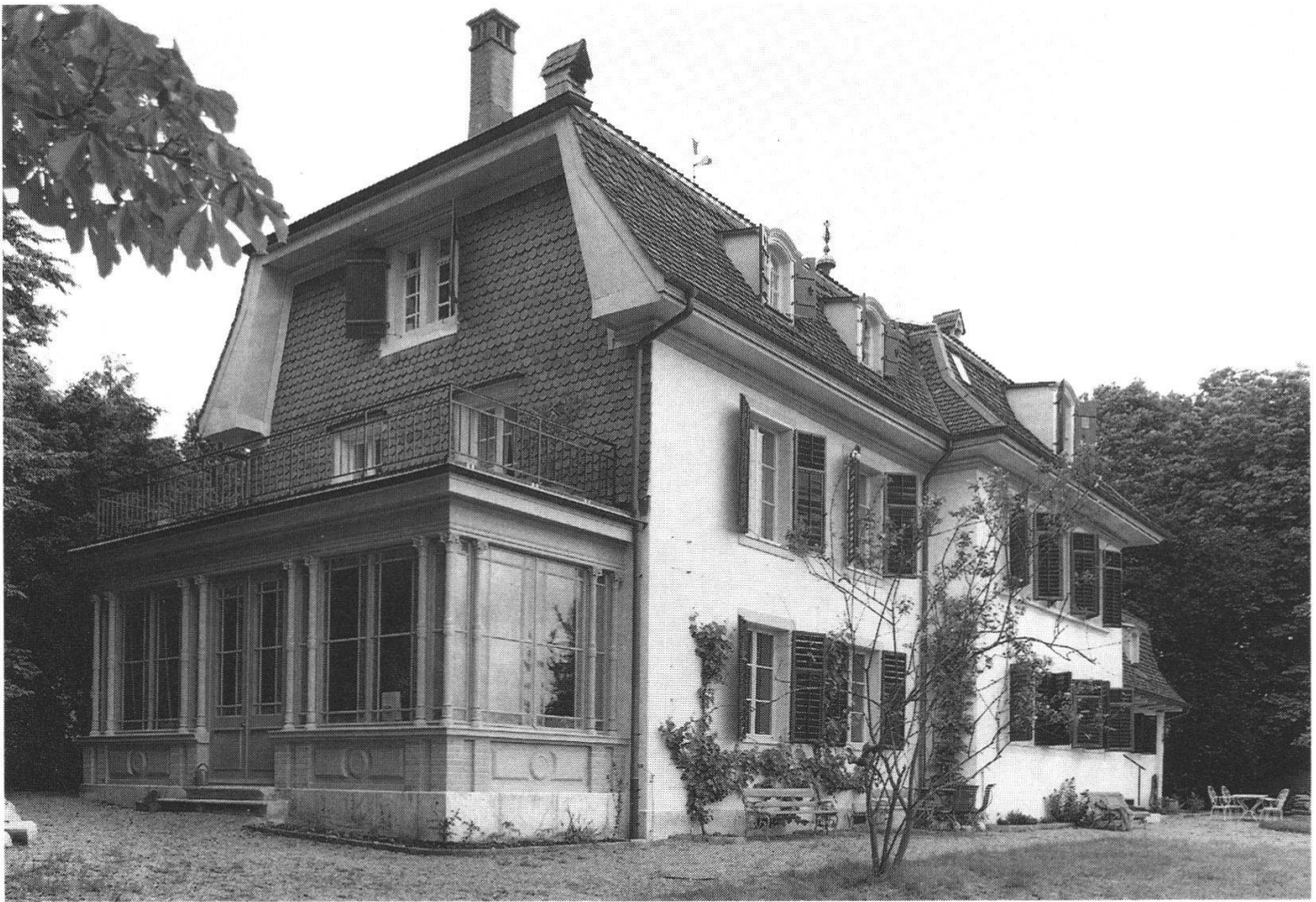
Abb. 11: Südwestansicht nach der Renovation von 1989/90.
