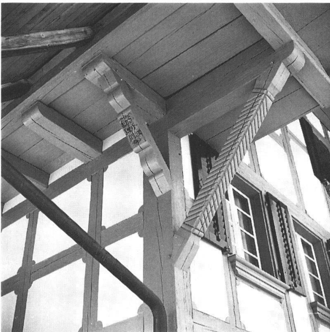
Abb. 4: Dachuntersicht mit verzierten Stützbögen.
