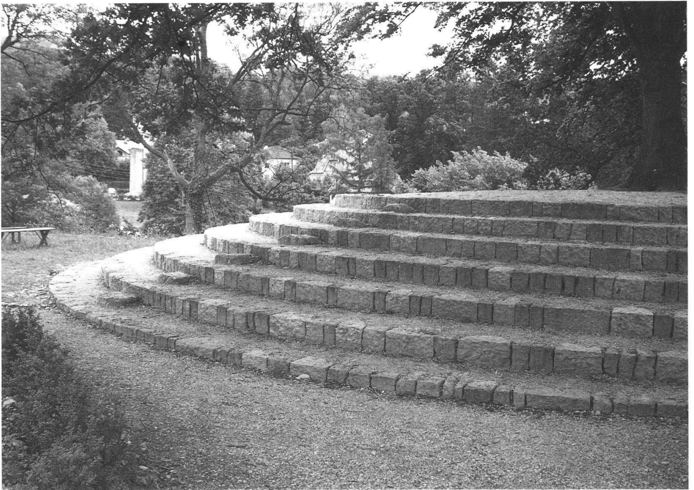
Abb. 4: Die 7-stufige Terrassenanlage nach der Restaurierung
