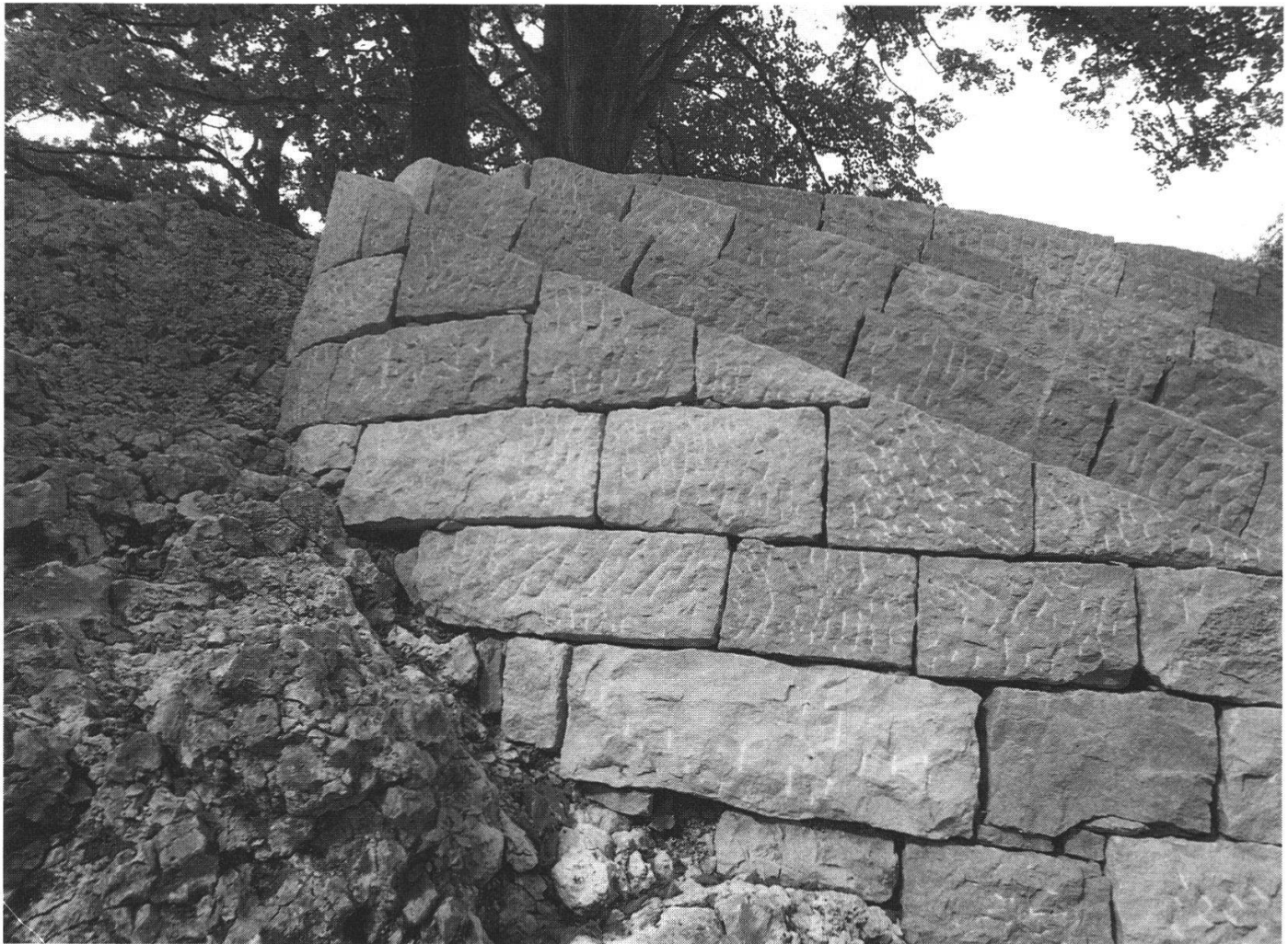
Abb. 2: Ineinanderlaufende Stufen auf der Südostseite
