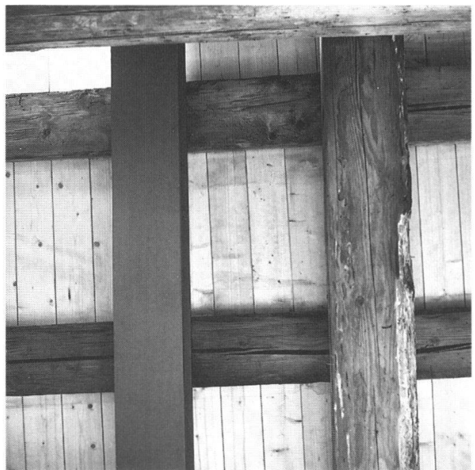
Abb. 8: Deckendetail im Schmitteraum mit Verstärkung durch einen Stahlträger.
