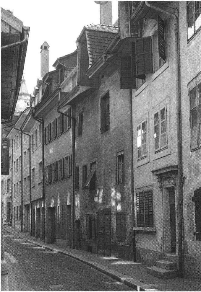
Abb. 6: Die Fassade vor...
