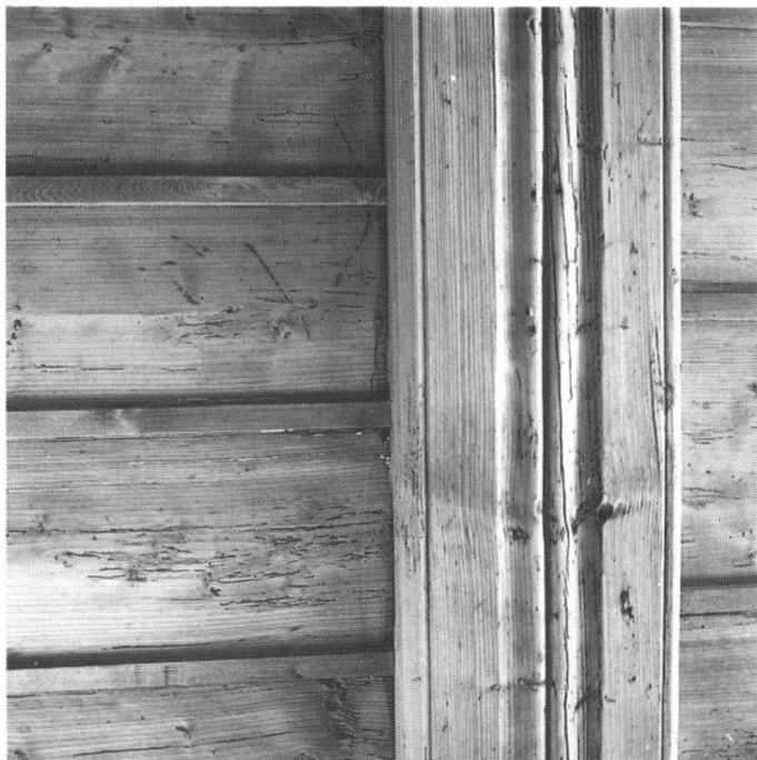
Abb. 7: Deckendetail mit profiliertem Deckenträger in der Stube.
