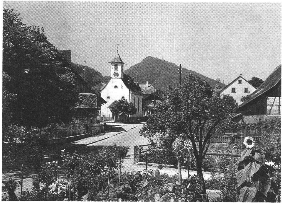
Abb. 2: Zustand 1939 vor der Erstellung des Querfirstes.
