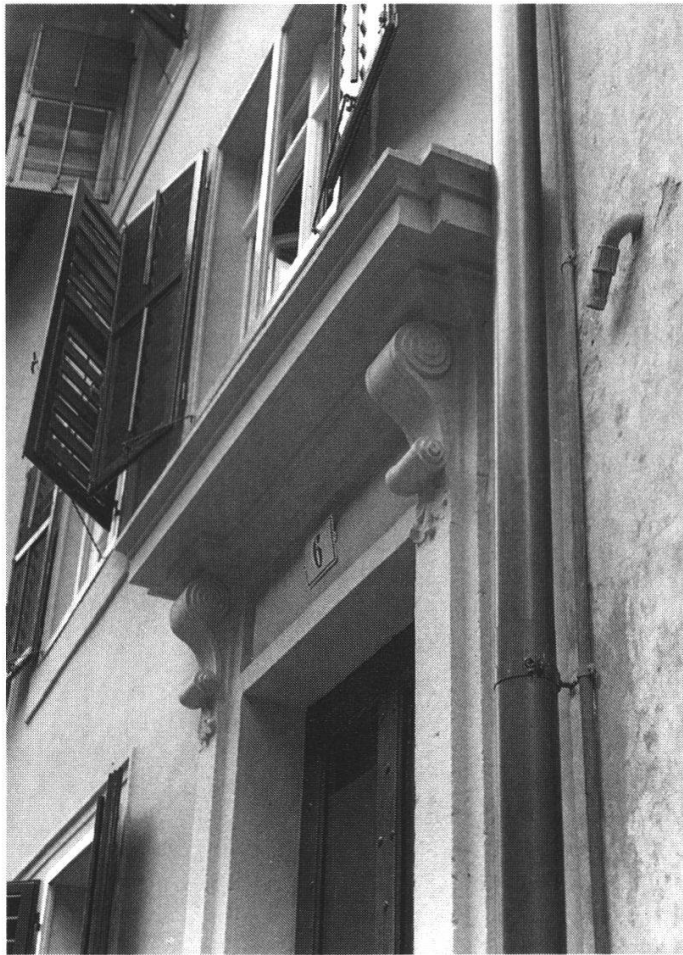
Abb. 4: Haustür, Detail Sturz, mit Zierelementen aus den 1720er Jahren.
