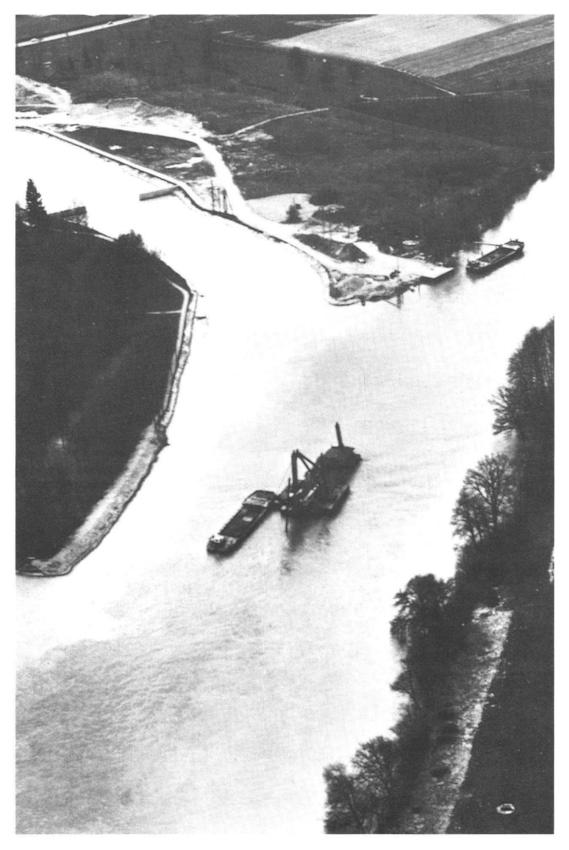
Abb. 24: Der Manitowoc beginnt mit dem Aushub unterhalb der Emmemündung. Die Emme fliesst auf dem Bild mit Suspension von links in die Aare. In der Emme ist das Abschlusswerk des Kiesfanges zu erkennen. (Aus: Robert Müller, 1974)
