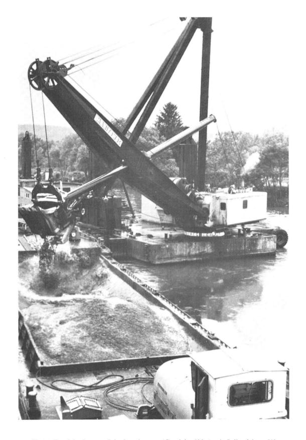
*Abb. 16:* Der Manitowoc-Schwimmbagger (Gewicht 600 t) mit Selbstfahrer-Klappschiff 500 t, Füllzeit 30–45 Minuten. (Quelle: Die Korrektion des Nidau–Büren-Kanals und der Aare bis zur Emmemündung, 1974, 6)
