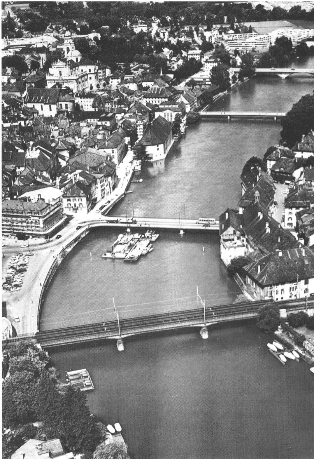
Abb. 19: Stadt Solothurn. Ausgleichen und Sichern der Sohle zwischen den Brücken. (Die Korrektur des Nidau-Büren-Kanals, 1974, 60)
