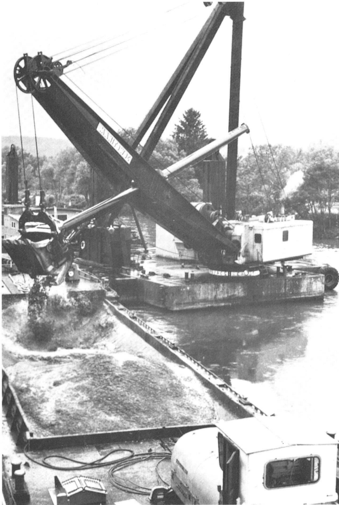
Abb. 16: Der Manitowoc-Schwimmbagger (Gewicht 600 t) mit Selbstfahrer-Klappschiff 500 t, Füllzeit 30–45 Minuten. (Quelle: Die Korrektur des Nidau–Büren-Kanals und der Aare bis zur Emmemündung, 1974, 6)
