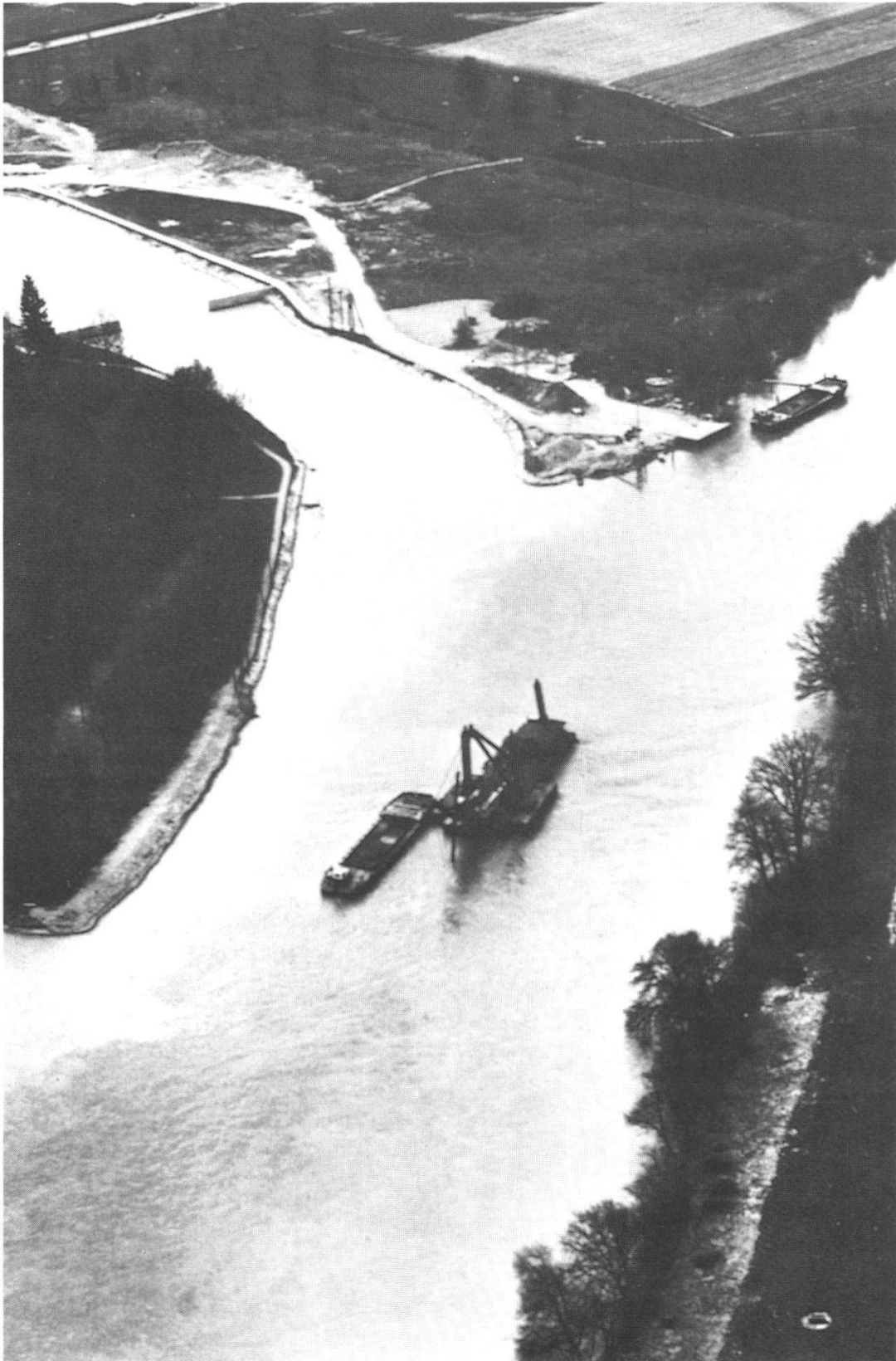
Abb. 24: Der Manitowoc beginnt mit dem Aushub unterhalb der Emmemündung. Die Emme fließt auf dem Bild mit Suspension von links in die Aare. In der Emme ist das Abschlusswerk des Kiesfanges zu erkennen. (Aus: Robert Müller, 1974)
