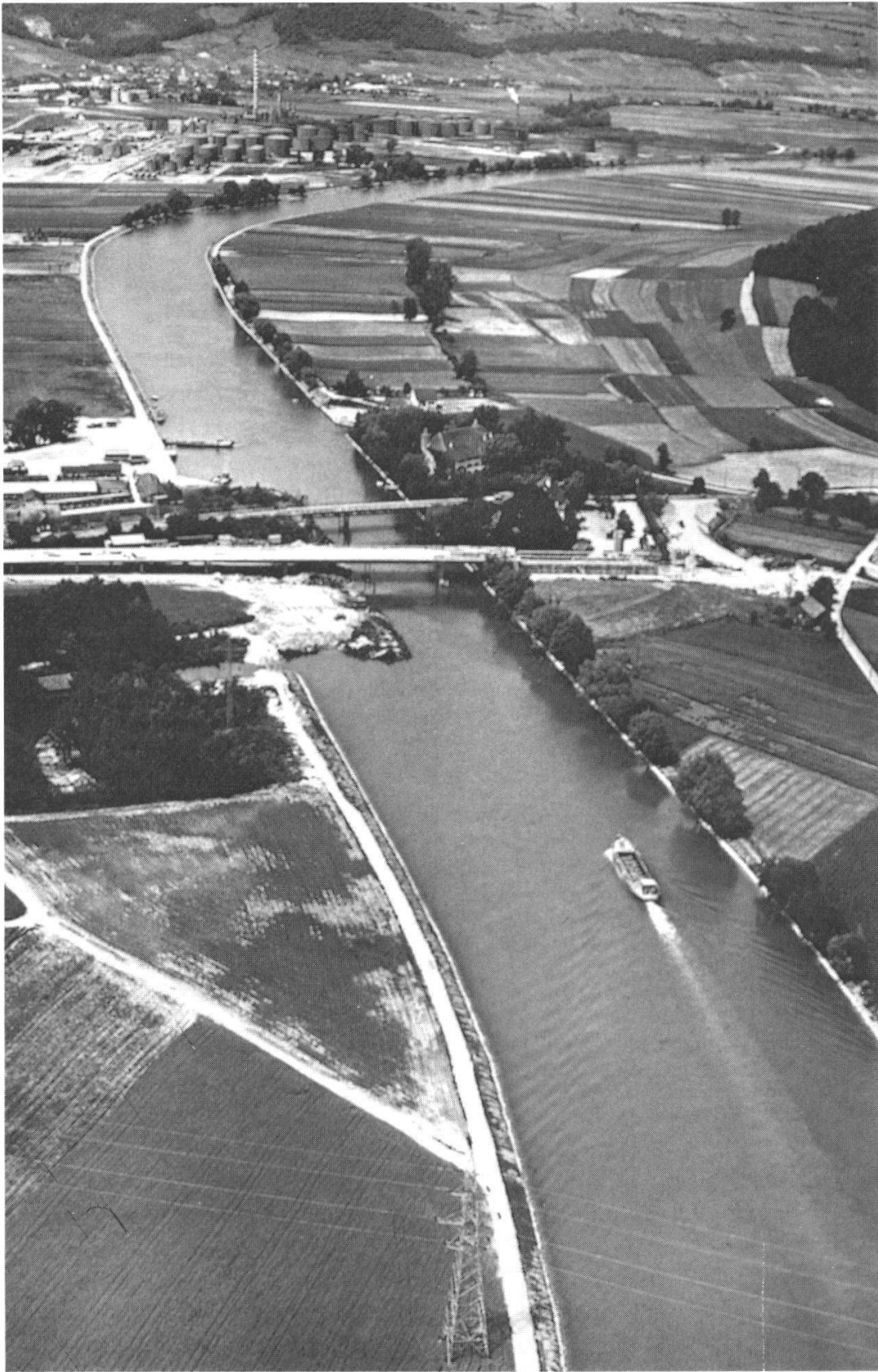
Abb. 14: Zihlkanal, der verbreiterte Kanal und Bau der Brücke von Thielle. (Müller 1971, 38)
