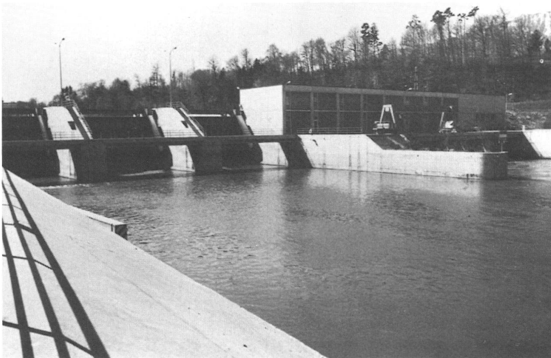
Abb. 26: Kraftwerk Flumenthal. Blick vom Unterwasser auf die Wehranlage und das Maschinenhaus. (Aus: Abschliessender Bericht über die 2. JGK, 1974)
