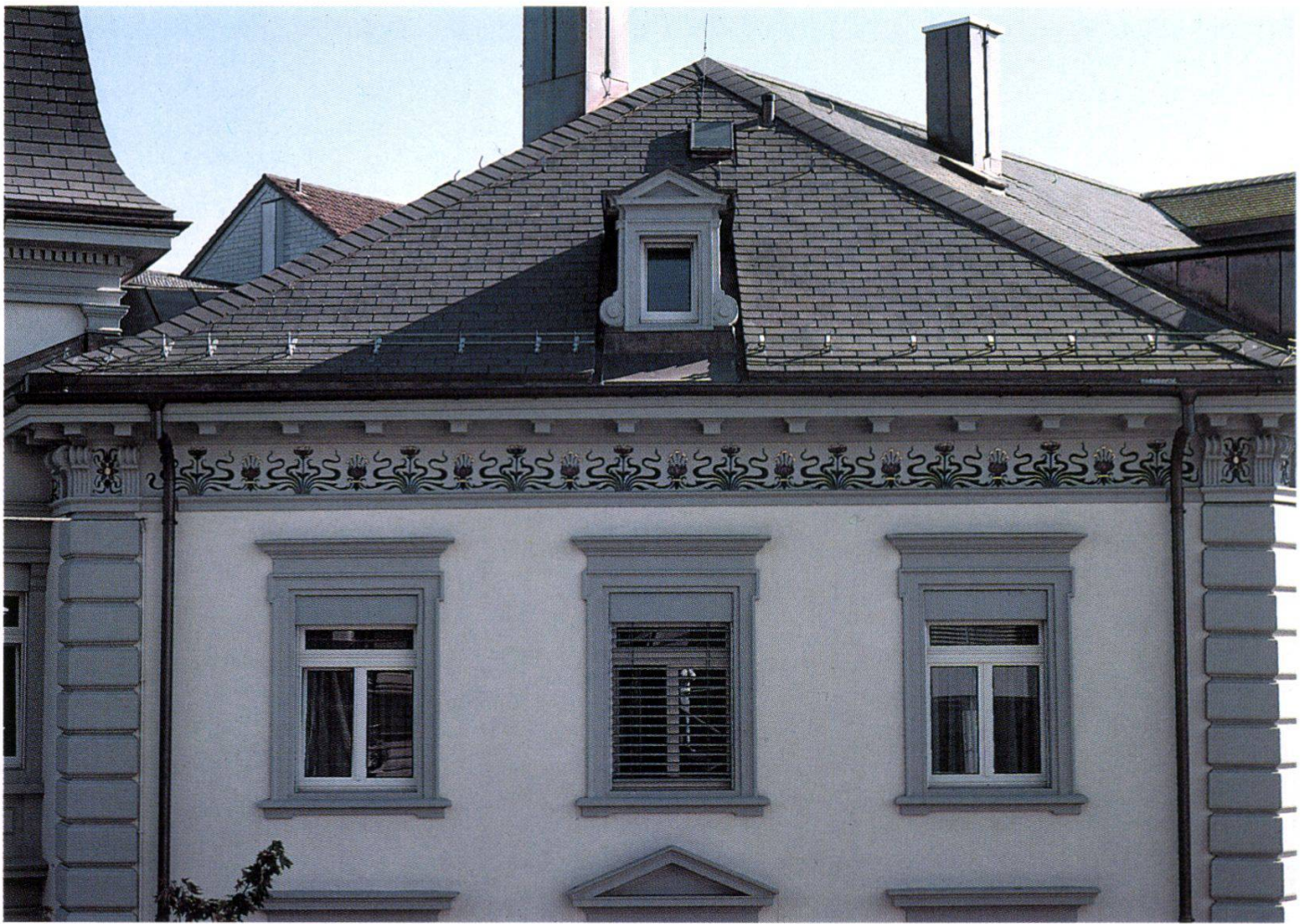
Abb. 6: Ausschnitt aus der renovierten Fassade mit dem rekonstruierten Jugendstilfries.
