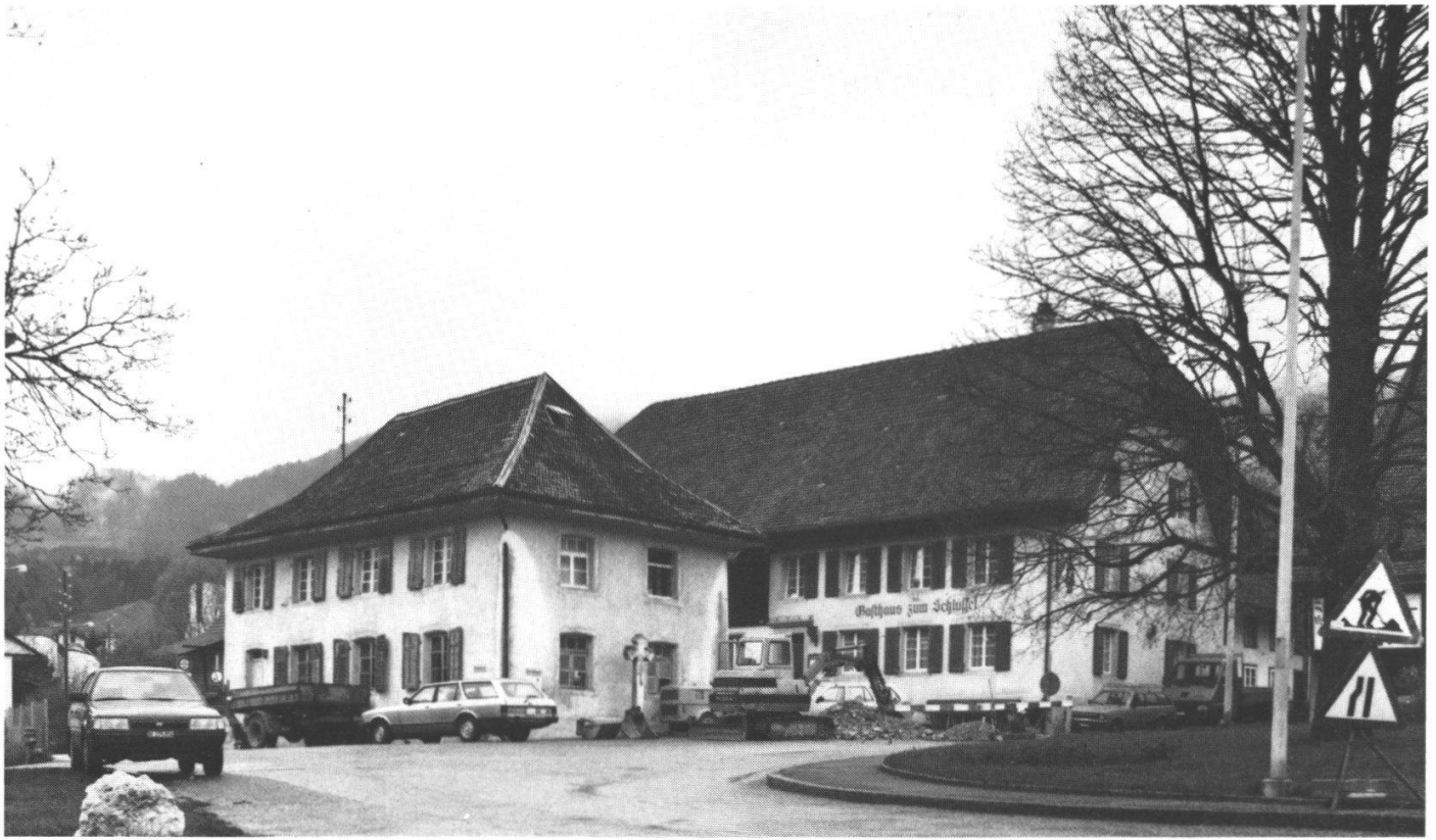
Abb. 2: Aufnahme kurz vor dem Abbruch April 1989.
