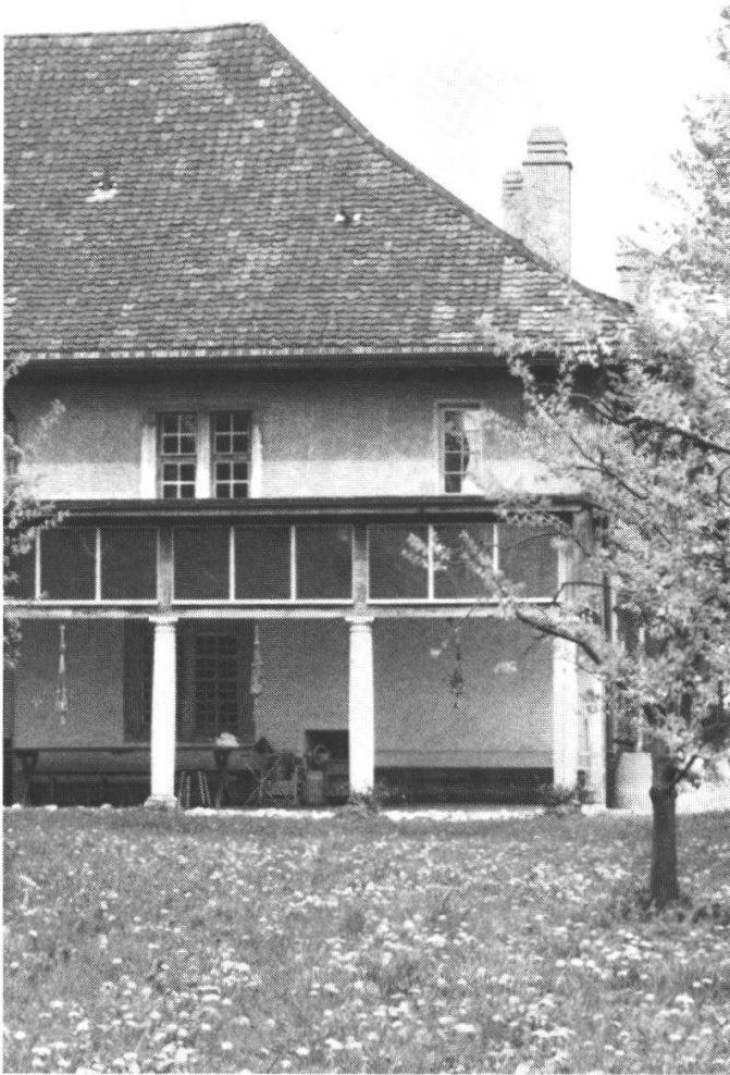
Abb. 1: Westfassade mit Vorhalle, Ausschnitt, 1988
