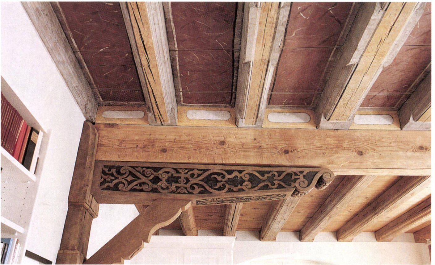
Abb. 6: Erdgeschoss, östliche Wohnung nach der Restaurierung. Ausschnitt aus der Holzbalkendecke mit Mittelstud und Sattelholz. Schnitzerei und Bemalung am Sattelholz von 1586/87. Bemalung der Decke wohl spätes 17. Jahrhundert.
