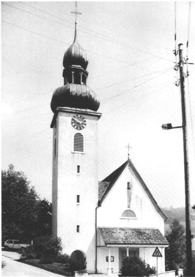
Abb. 1: Die Holderbanker Kirche vor der Aussenrenovation von 1989.
