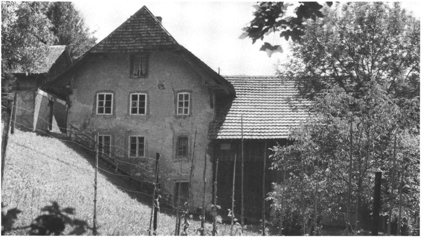
Abb. 1: Das Haus Säliloch in stark baufälligem Zustand 1986.
