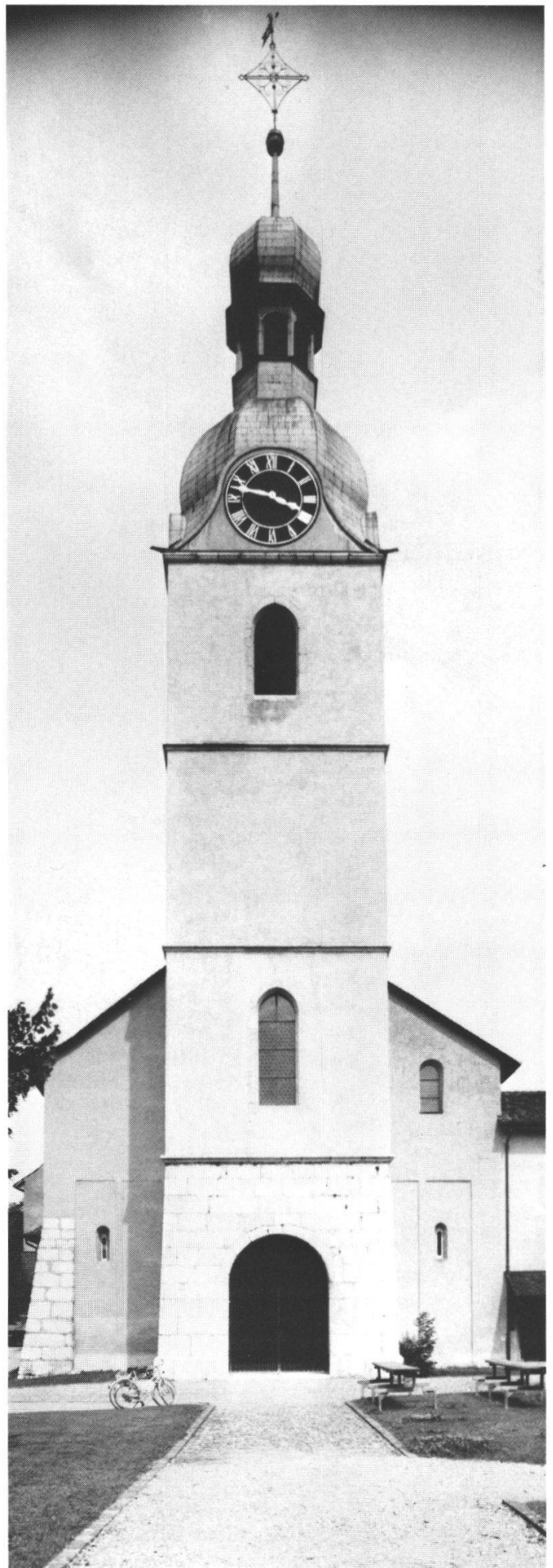
Abb. 4: Nach der Restaurierung von 1989. Aufnahme 1990.
