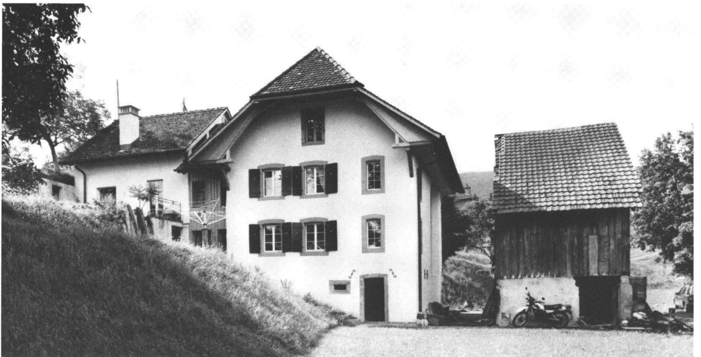
Abb. 2: Das restaurierte Haus mit dem ausgebauten Schopf (links). Anstelle der teilweise abgebrochenen Scheune (rechts) ist ein Neubau geplant.
