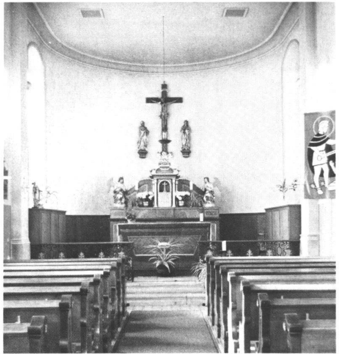
Abb. 2: Aufnahme von 1984 mit der 1956 neu erstellten Gipsdecke. Die Stuckornamente sind entfernt. Über dem Altar der Kruzifixus, flankiert von neuen Statuen Maria und Johannes.
