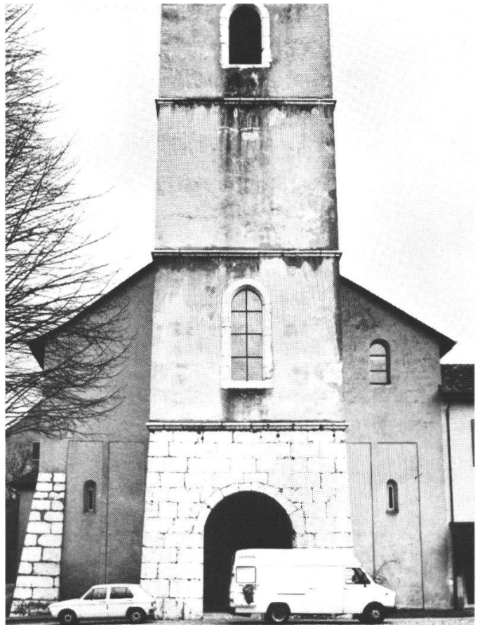
Abb. 2: Nach der Restaurierung von 1958 im wiederum recht verwitterten Zustand von 1980.
