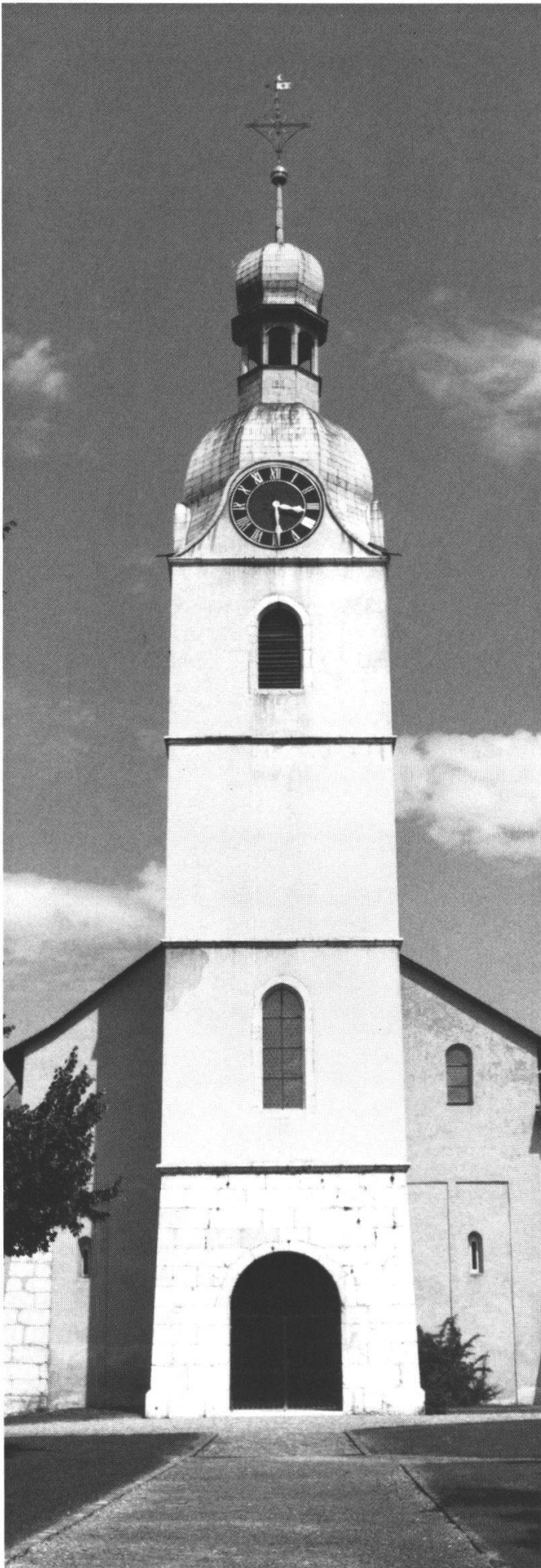
Abb. 3: Nach der Restaurierung von 1980 im Zustand von 1988. Es sind einige Abplatzungen von Deckputz sichtbar.
