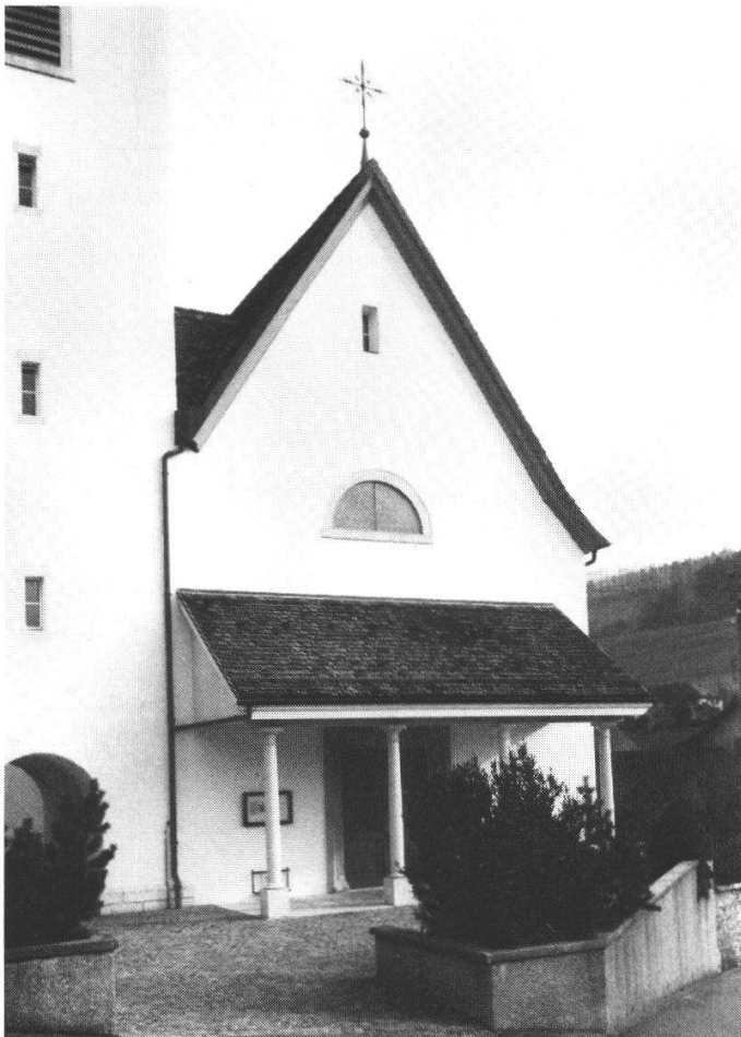
Abb. 3: Die neu gekalkte Westfassade.
