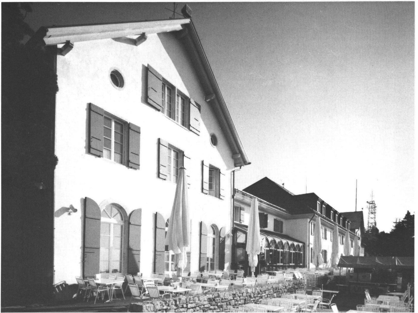
Abb. 1: Südfassade mit Westflügel (vorne), Zwischenbau mit Wintergarten und Haupttrakt.
