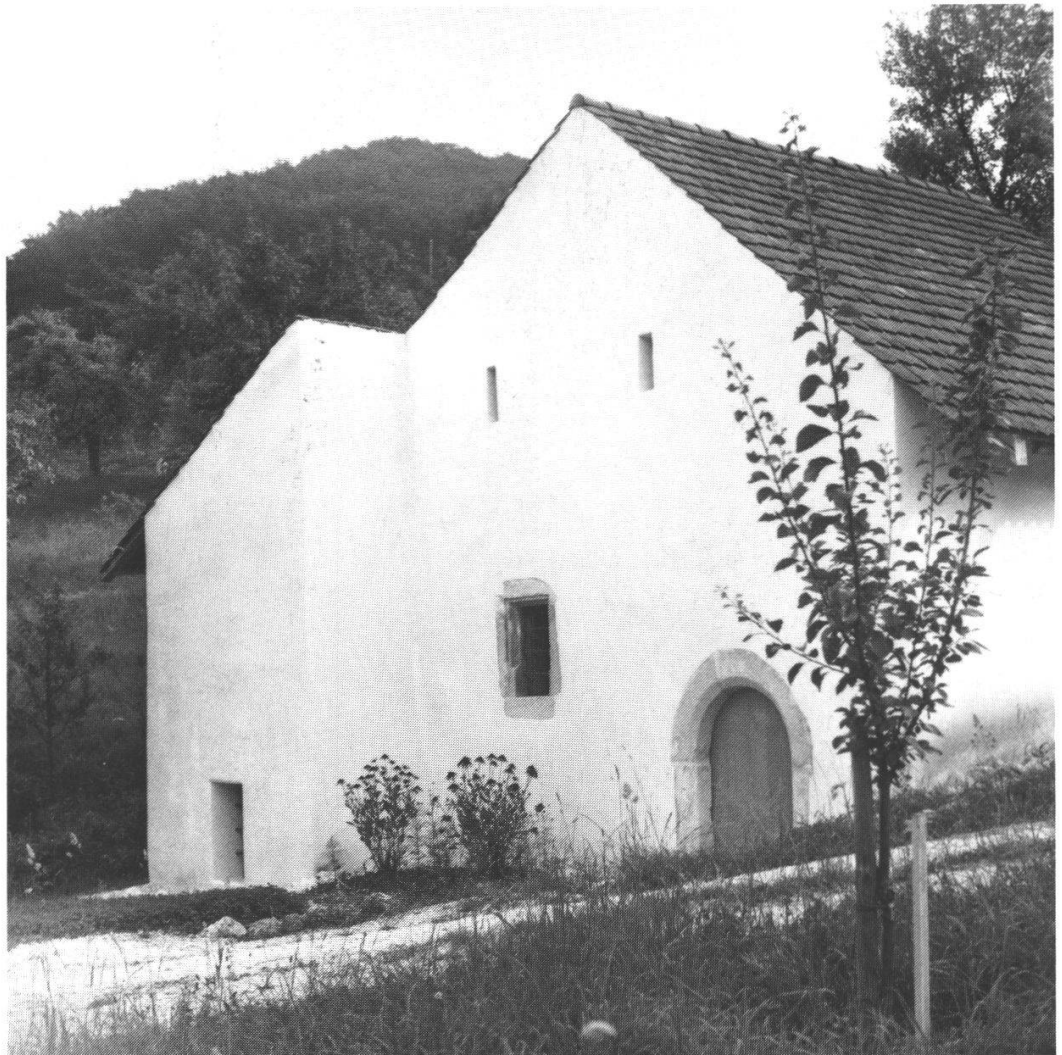
Abb. 2: Hauptfassade nach der Restaurierung.
