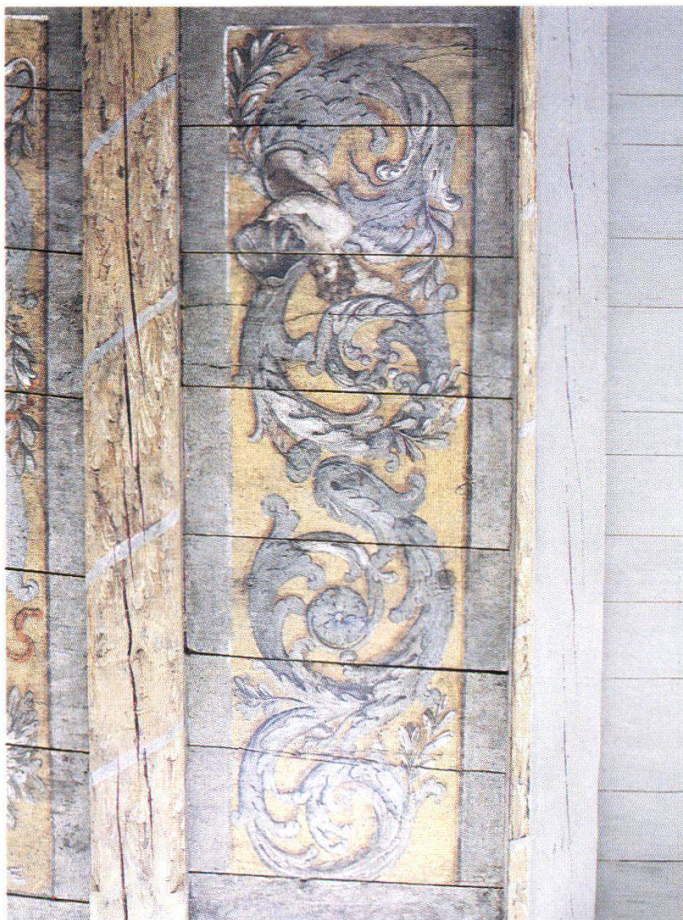
Abb. 9: Südflügel 1. Obergeschoss. Ausschnitt aus der bemalten Decke, wohl aus dem späten 17. Jahrhundert, Zustand nach der Restaurierung
