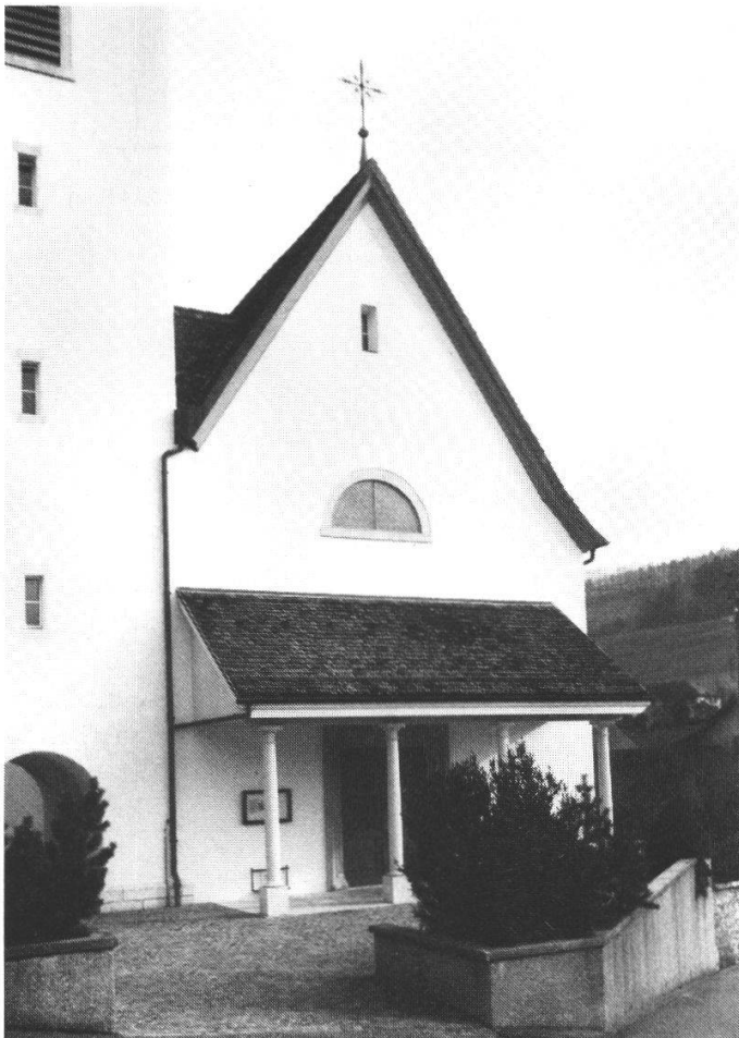
Abb. 3: Die neu gekalkte Westfassade.
