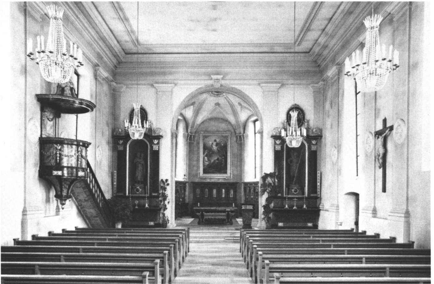
Abb. 4: Das stark verschmutzte Kircheninnere nach der Restaurierung von 1970 im Zustand von 1988. Verschmälerte Seitenaltäre mit den Fröhlicher-Figuren anstelle der originalen Deschwanden-Bilder.
