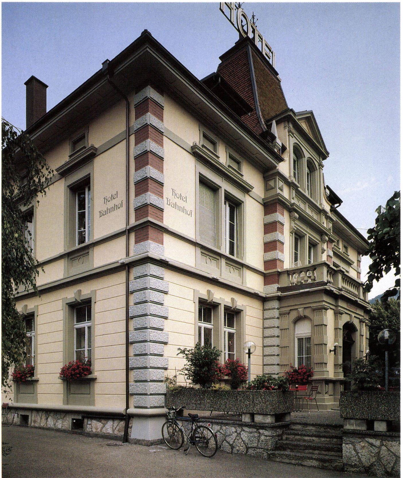
Abb.: Das Hotel Bahnhof nach der Fassadenrestaurierung mit dem der Originalfassung angenäherten Neuanstrich.
