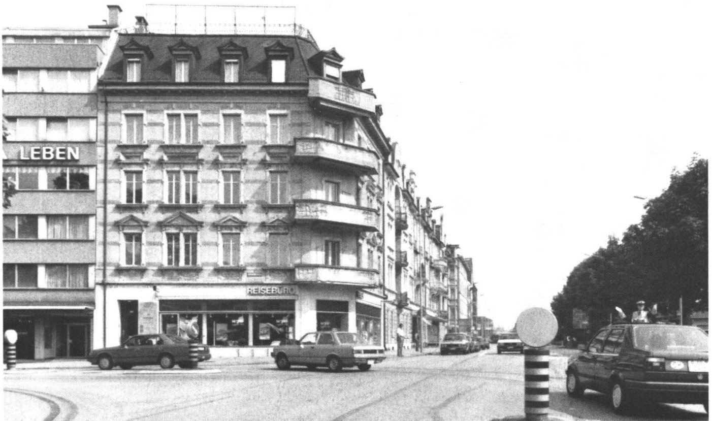
Abb. 2: Zustand 1988: aufgerissenes Erdgeschoss, abgerissener Erker, dafür unförmige Balkone.
