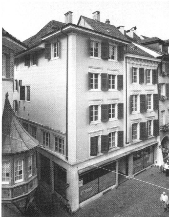
Abb. a: Die Häuser Hauptgasse 37 und 39 vor dem Umbau...
