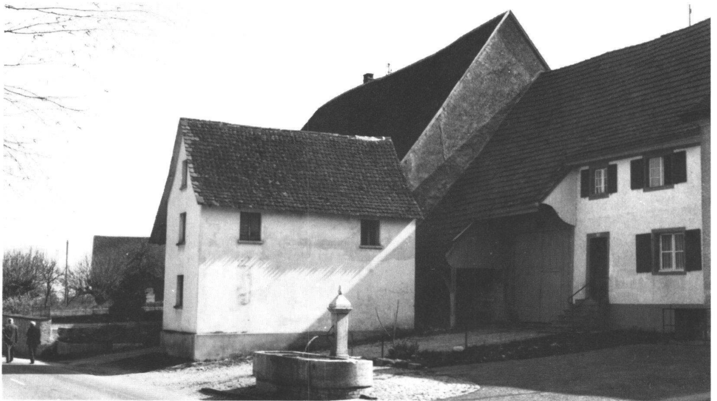
Zustand 1969. Das Riegelwerk ist durch eine verputzte Backsteinmauer ersetzt worden.
