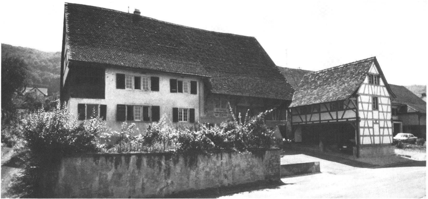
Zustand heute. Das Riegelbild rekonstruiert.
