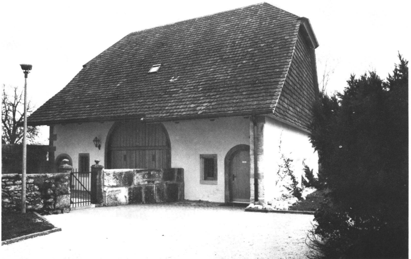
Abb. b: ...und nach Umbau und Restaurierung.
