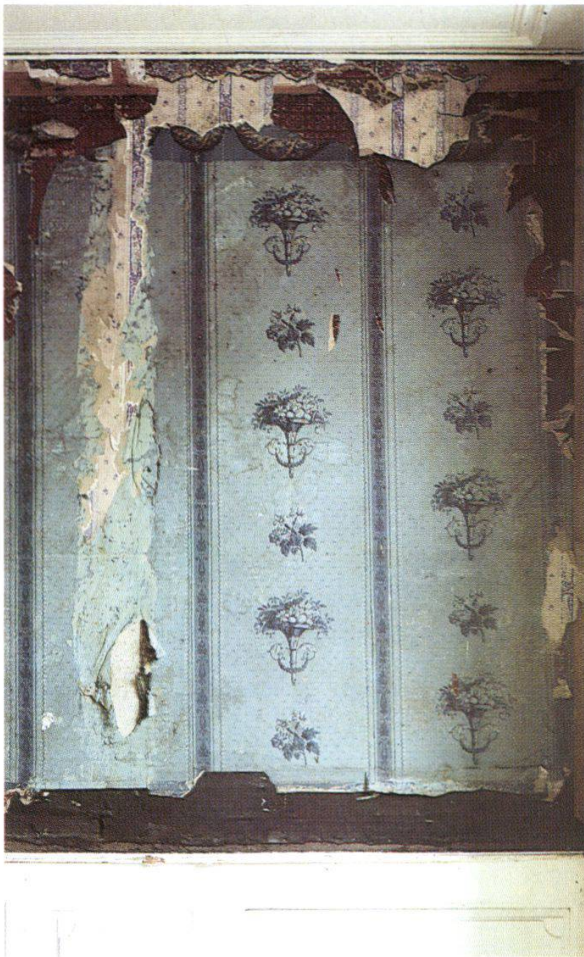
Abb. n: Tapete von ca. 1820/30, Ostwand Stube 2. OG.
