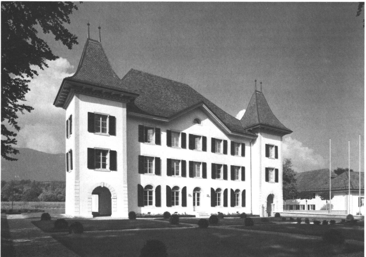
Abb. c: Das Herrenhaus nach der Restaurierung.
