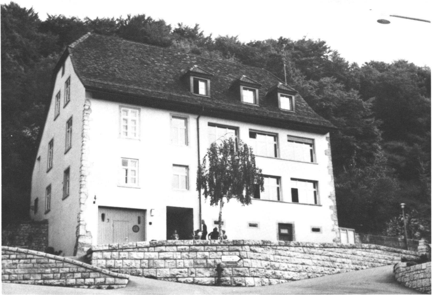
Abb. a: vor der Restaurierung
