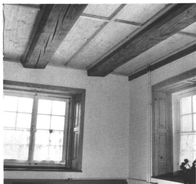
Abb. b: Zimmer im 1. Obergeschoss mit Holzbalkendecke.
