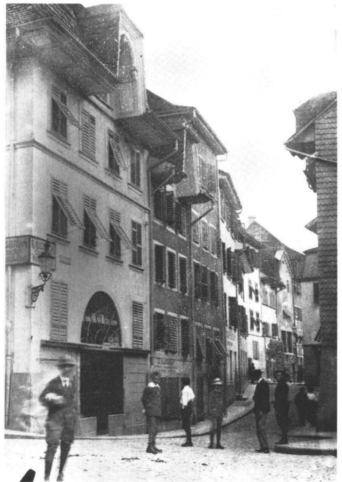
Abb. l: In der Bildmitte die beiden Häuser im Zustand um 1916.
