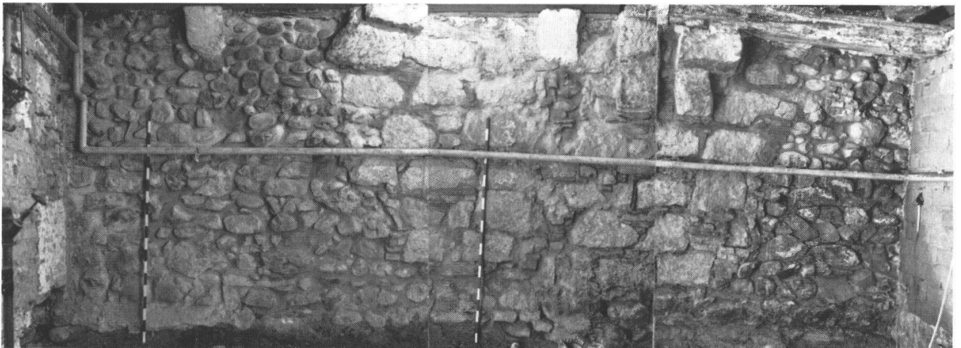
Abb. b: Ansicht der östlichen Brandmauer; deutlich erkennbar im sonst kleinsteinigen Mauerwerk die Zone mit den grösseren Steinquadern, die die Rückwand des ehemaligen Herdes bilden.
