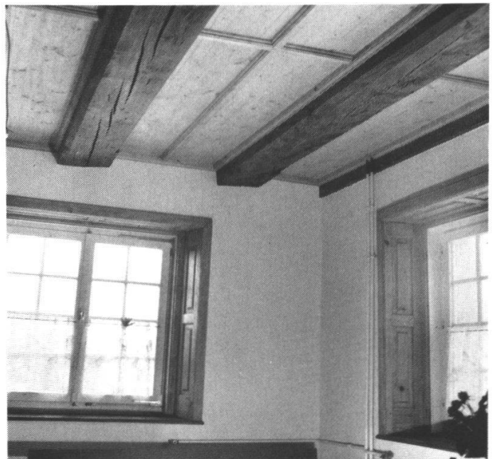
Abb. b: Zimmer im 1. Obergeschoss mit Holzbalkendecke.
