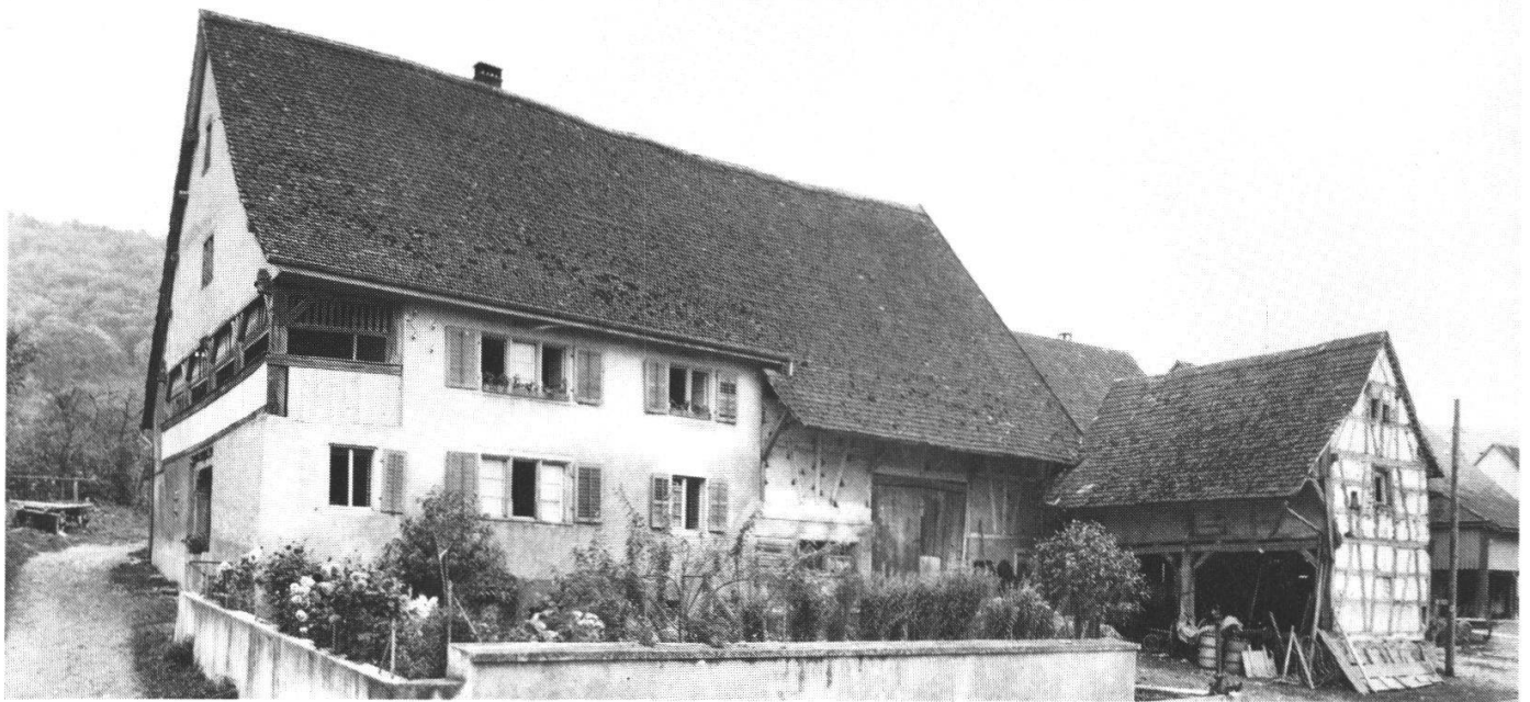
Zustand 1947. Das alte Riegelwerk des Wagenschopfes ist noch vorhanden.
