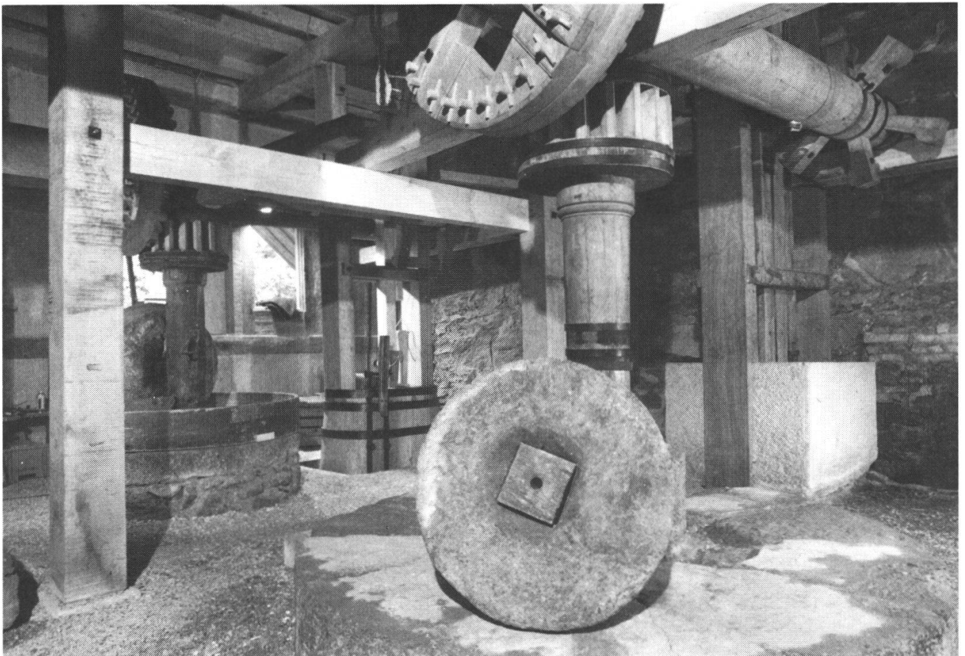
Abb. 3: Öleraum mit den einzelnen Werken (von links): Kollergang, Öltrotte, Reibe und Knochenstampfe.
