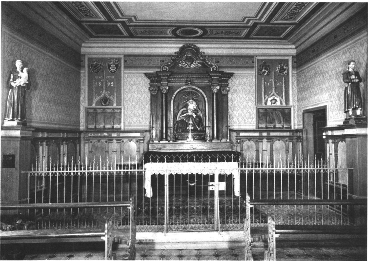
Abb. b: Inneres nach der Renovation von 1892.
