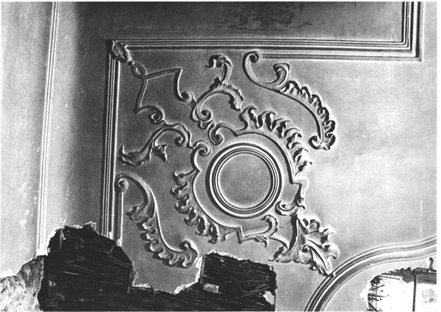
Abb. b: Aufgegebene Stuckdecke wohl aus der ersten Hälfte des 19. Jh. (OG, Südwest), Ausschnitt.
