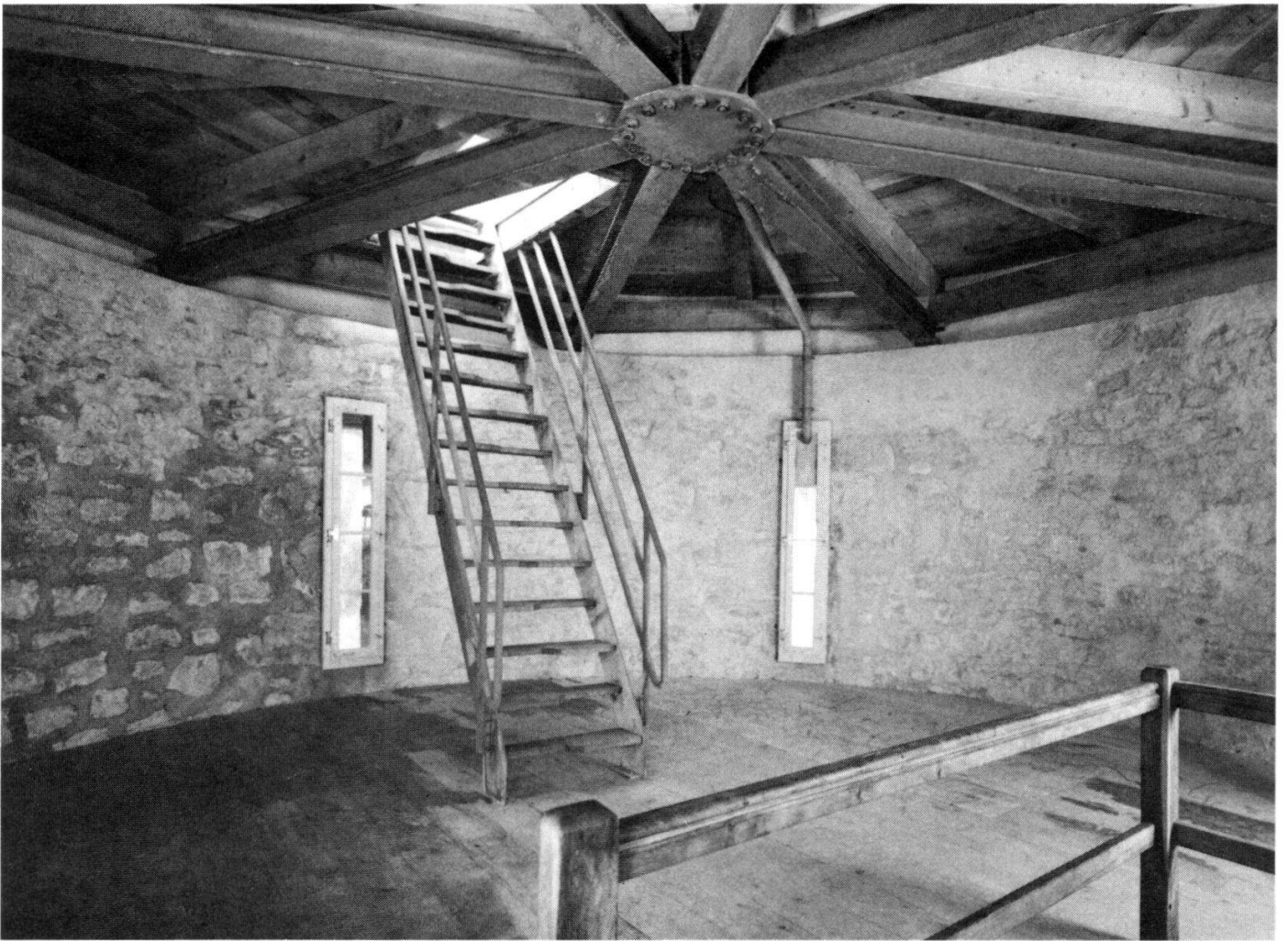
Abb. d: Oberstes Geschoss im Ostturm mit der neuen Dachkonstruktion.
