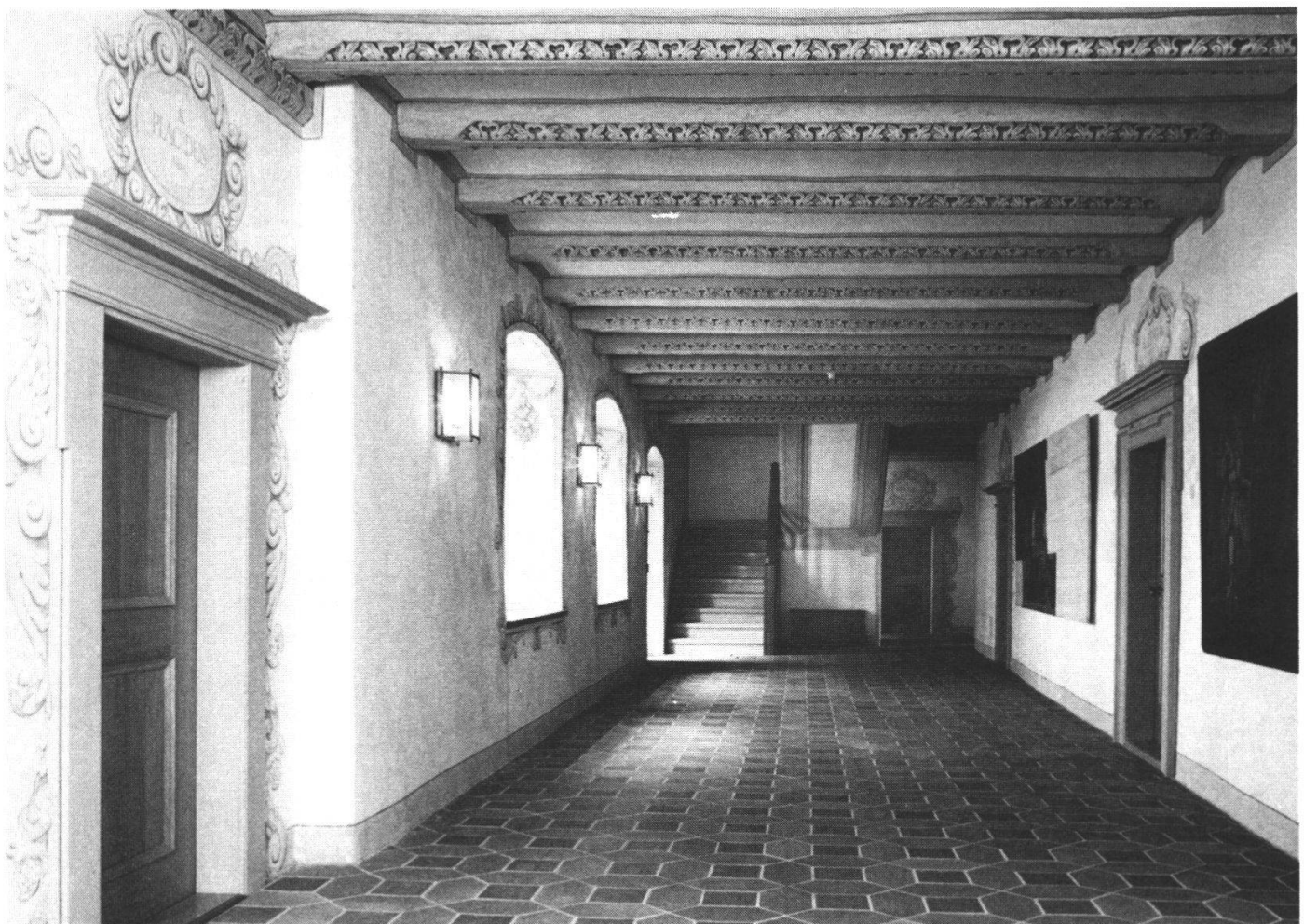
Abb. e: Gang im Erdgeschoss nach der Restaurierung.
