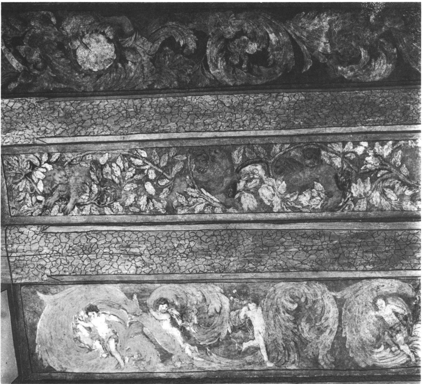
Abb. f: Deckenmalerei im Zimmer südlich der Kapelle.
