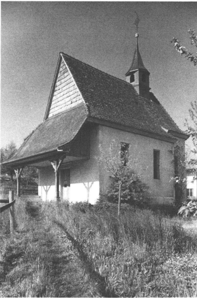
Vor der Restaurierung.
