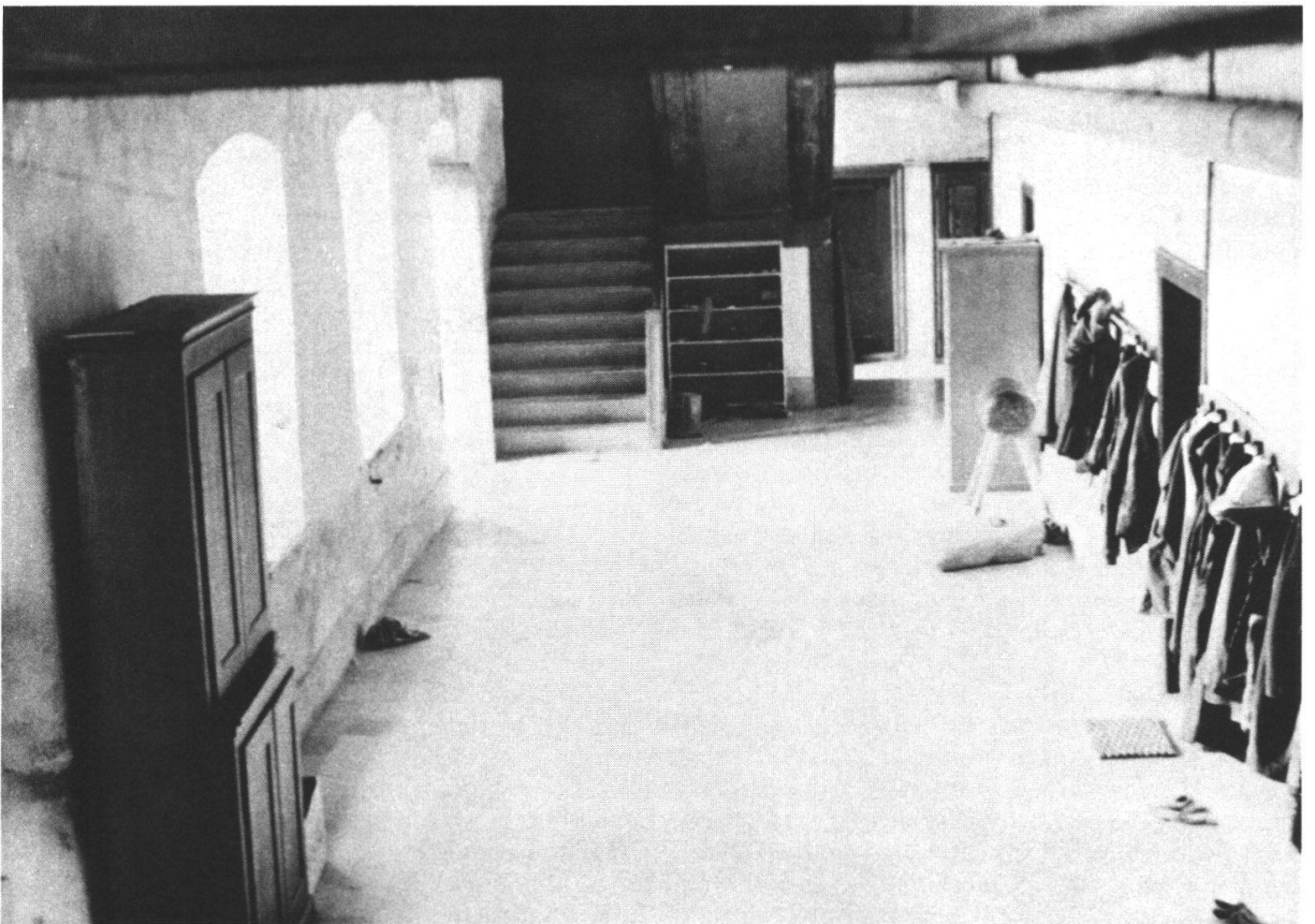
Abb. d: Gang im Erdgeschoss vor der Restaurierung.
