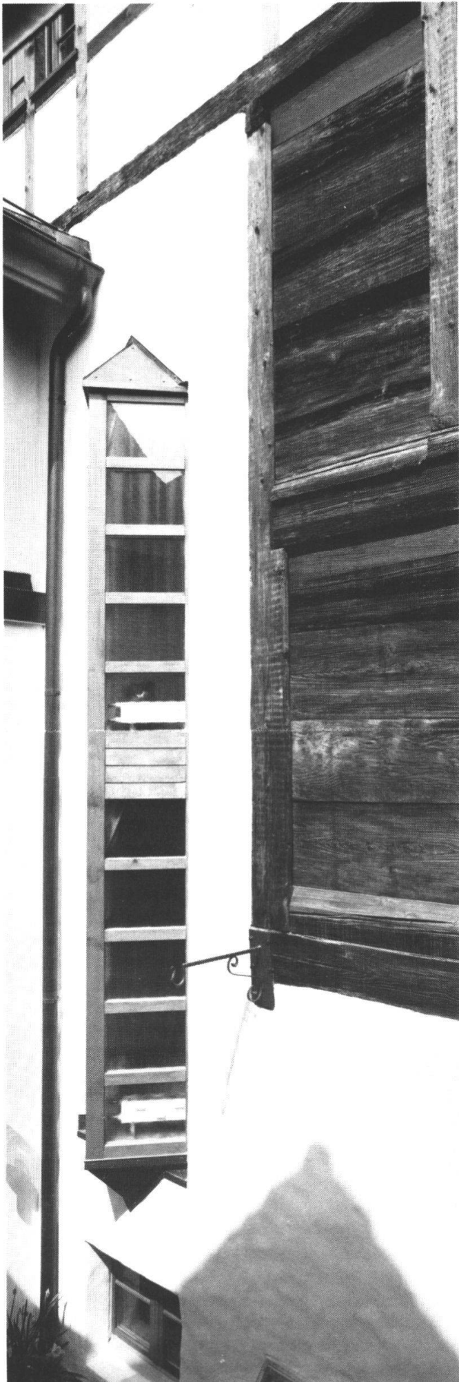
Abb.e: Im Innenhof verbinden sich alte und neue Bauteile zu einem harmonischen Ganzen. Blick auf die Ständer-Bohlen-Konstruktion des 16. Jahrhunderts und die neue Treppenhäuserweiterung an der Südfassade des Hauses Nr. 24.
