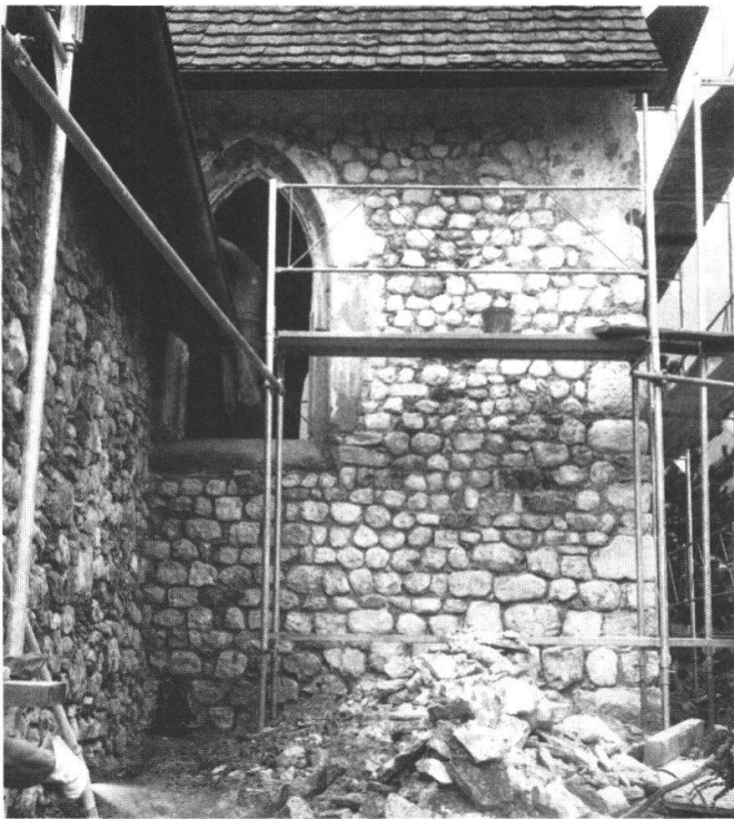
Abb.e: Südfassade des Chörleins: Mauerwerk von 1481/83.
