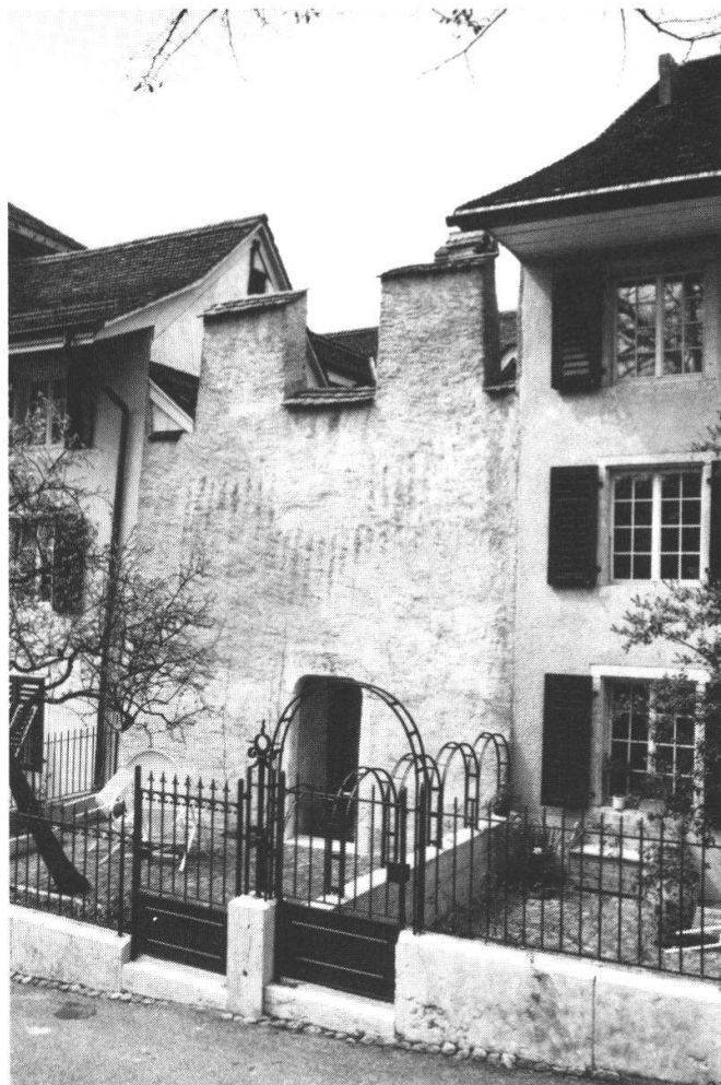
Abb.e: Im Innenhof verbinden sich alte und neue Bauteile zu einem harmonischen Ganzen. Blick auf die Ständer-Bohlen-Konstruktion des 16. Jahrhunderts und die neue Treppenhäuserweiterung an der Südfassade des Hauses Nr. 24.
