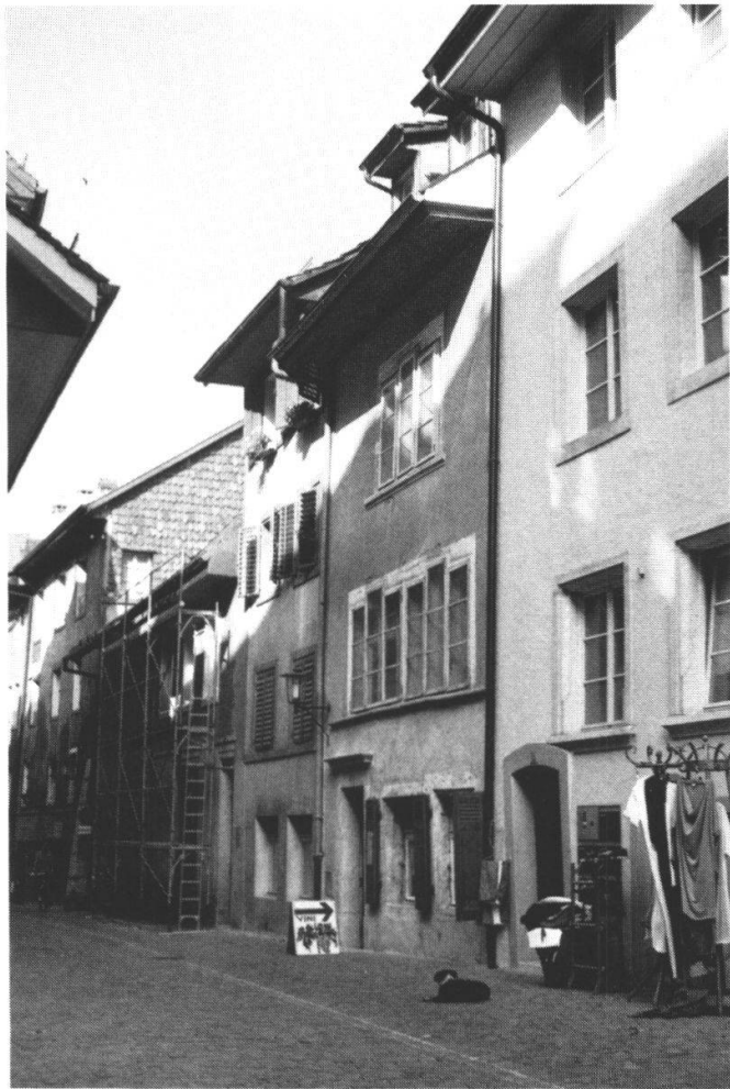
Löwengasse 14. Gassenfassade vor der Renovation, 1984.
