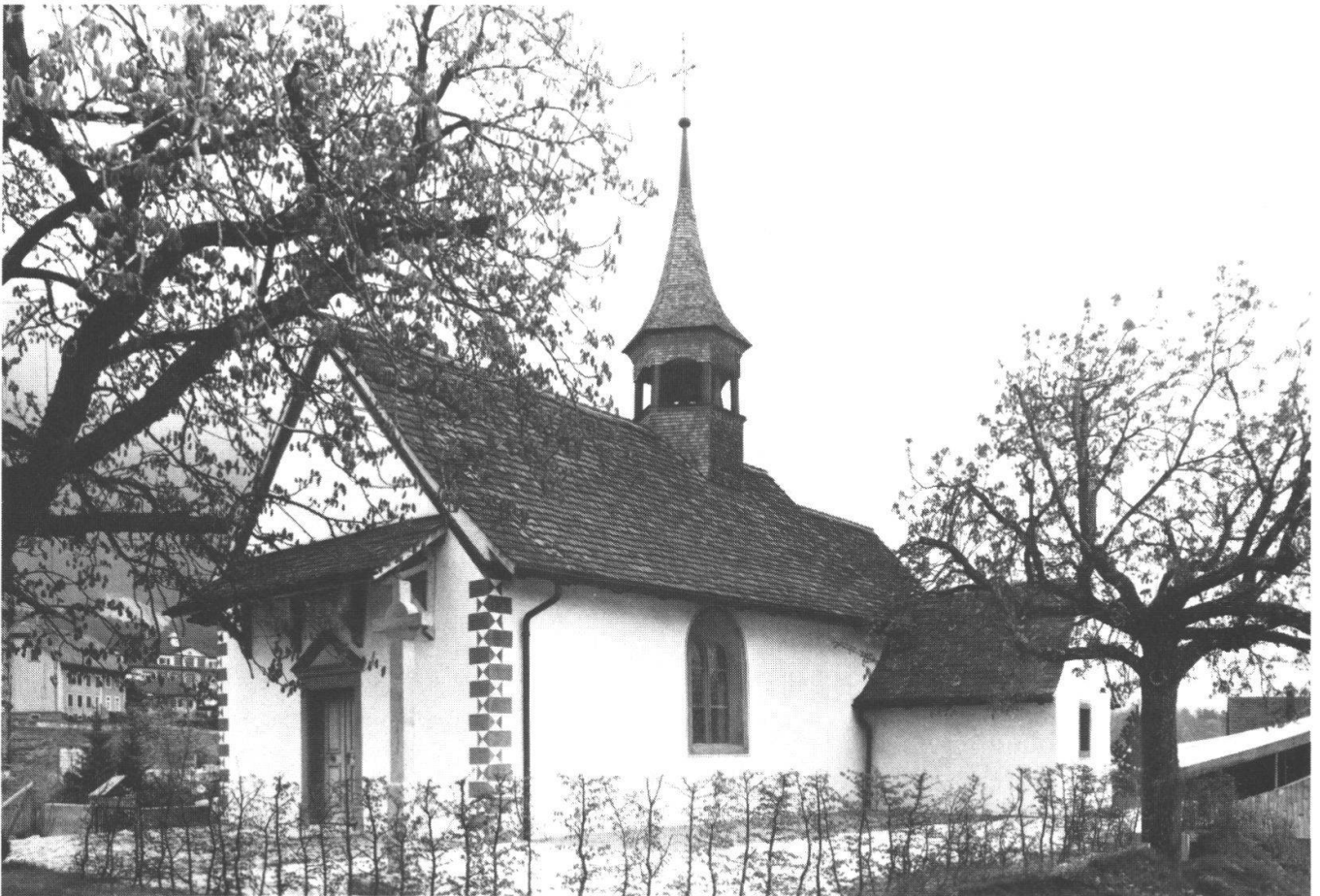
Lommiswil, die Alte Kirche St. German vor (oben) und nach der Restaurierung (unten).
