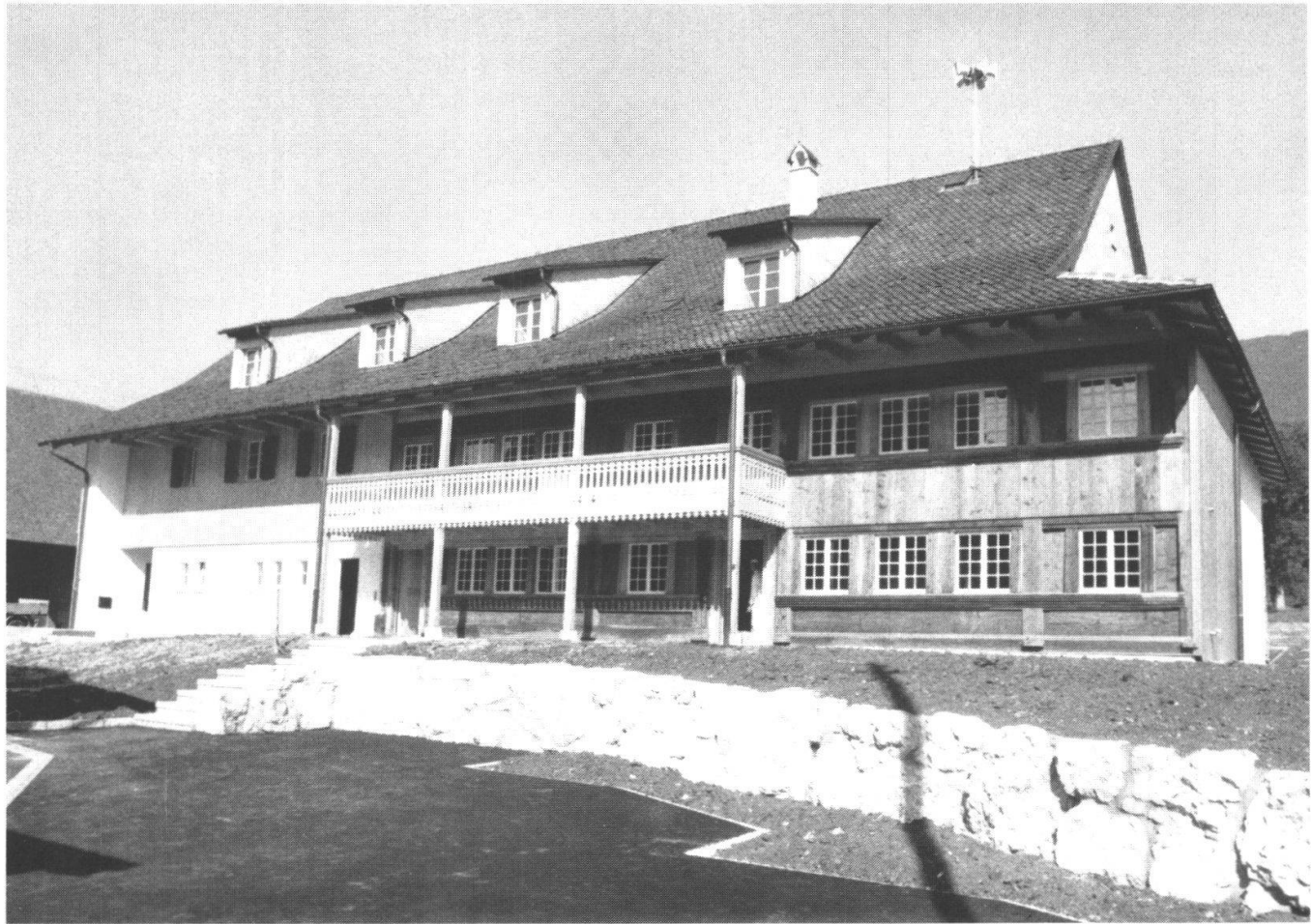
Das Gallihaus in Aedermannsdorf vor dem Abbruch, von Südwesten (oben), und der Neubau mit der wie-
