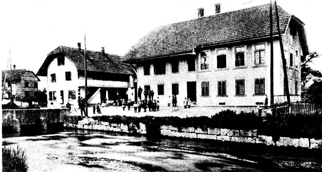
Dorfpartie mit Schulhaus (vor der Renovation von 1952), Brücke und Consum-Depot. (Dia – Zentralbibliothek Solothurn)
