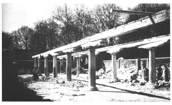
Abbildung 35 Steinsäulen mit Jochen und Längsunterzügen im Erdgeschoss, Abbruchsituation März 1933
