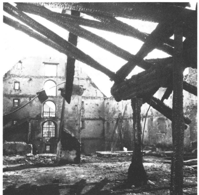
Abbildung 15 Inneres nach dem Brand von 1955. Blick nach Südosten
