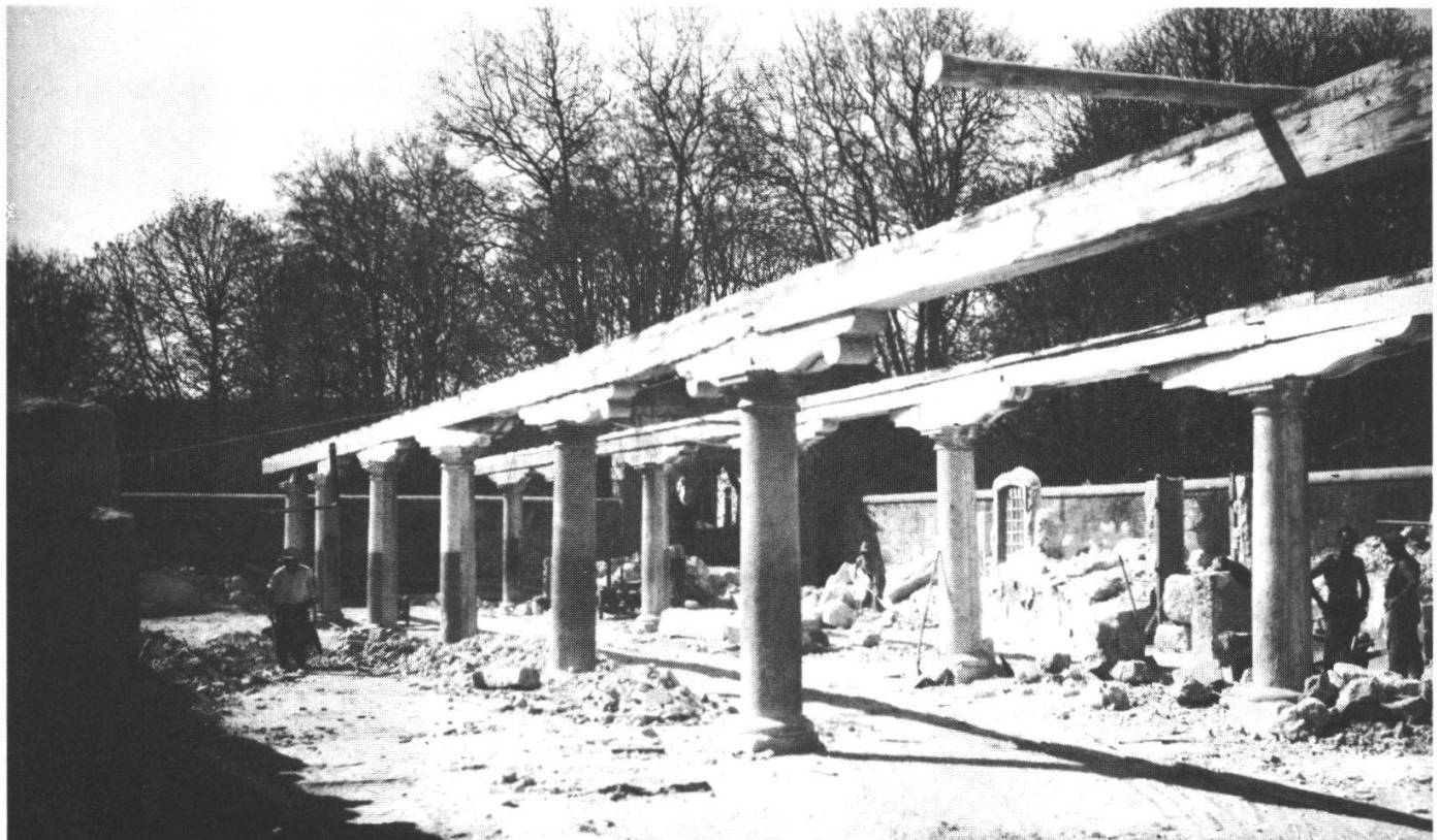
Abbildung 35 Steinsäulen mit Jochen und Längsunterzügen im Erdgeschoss, Abbruchsituation März 1933
