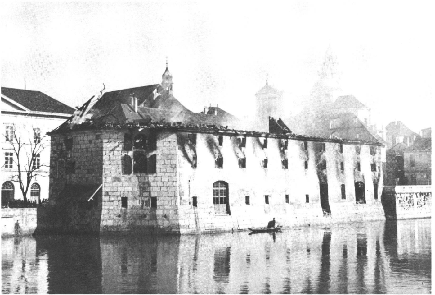
Abbildung 16 Äusseres nach dem Brand von 1955
