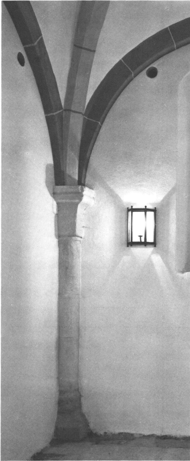
Rodersdorf, Pfarrkirche. Wanddienst und Gewölbeansatz in der von einer Heizungsanlage der 50er Jahre befreiten Katharinenkapelle im Turmerdgeschoss. Spätromanisch, um 1200 (links). Die von der Tiroler Glasmalerei Innsbruck hergestellten Kirchenfenster im Schiff stammen aus der Jahrhundertwende und gehören zu den besten ihrer Art im Kanton (rechts: St. Elisabeth).
