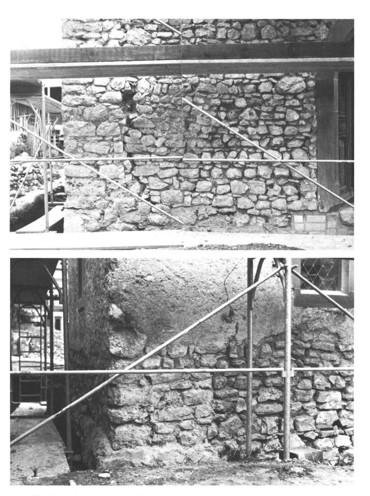
Oben: Westfassade, Partie zwischen der Eingangstüre und der Nordwestecke. Deutlich sichtbar ist die Naht zwischen dem älteren, spätromanischen Mauerwerk, das mit kleineren Bruchsteinen geschichtet ist, und der jüngeren Ecken mit den grösseren Steinen.
