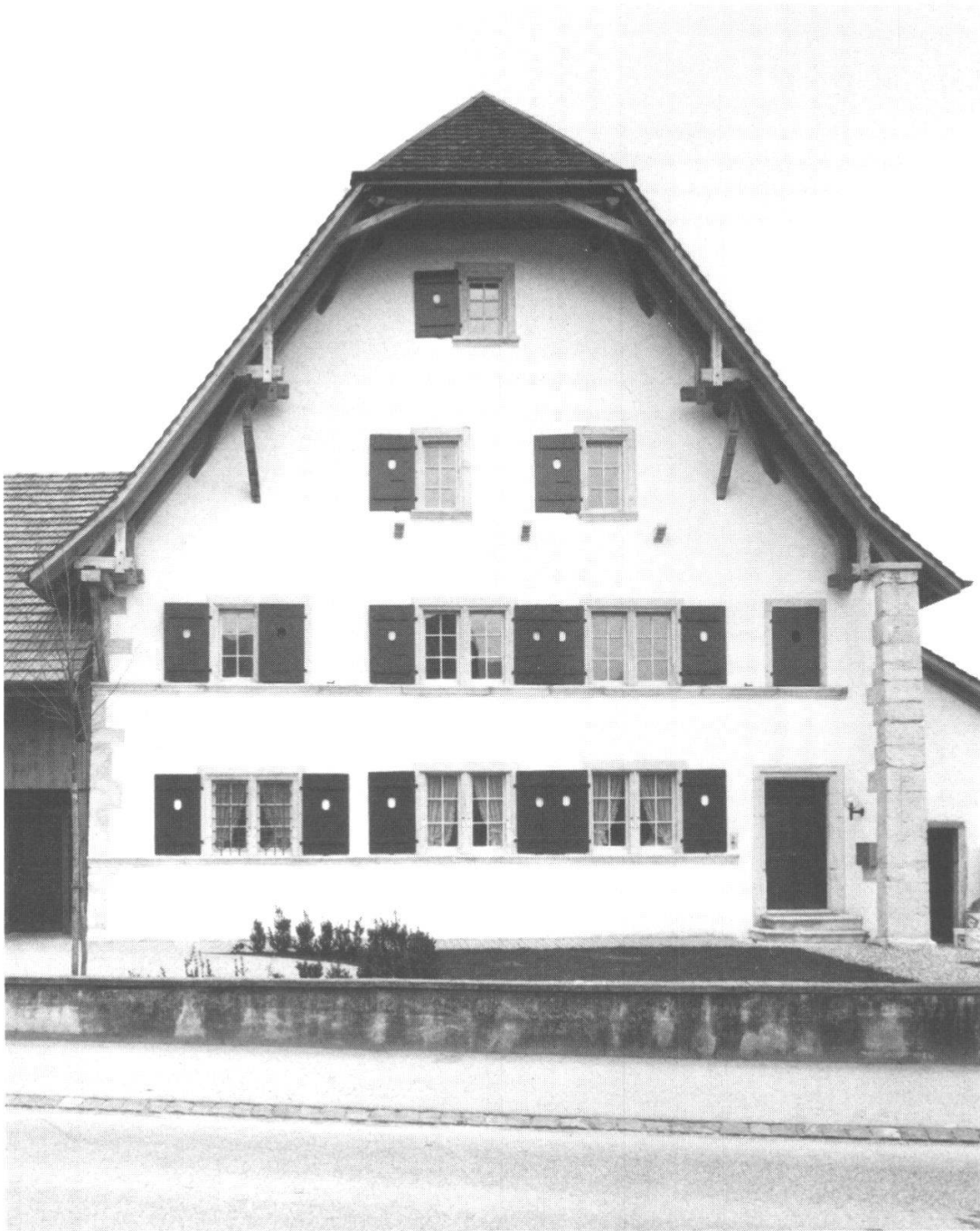
Neuendorf, Pflugerhaus. Der einzige auf Kantonsgebiet «erfundene» Haustypus ist das Gäuer Haus. Eines der schönsten Exemplare steht in Neuendorf. Es zeichnet sich aus durch Giebelständigkeit, fein bearbeitete Gewände aus Solothurner Stein und offenes Flugsparrenwerk. Letzteres wurde anlässlich der Restaurierung von seiner späteren Verkleidung befreit. Laut Familienchronik stammt das Pflugerhaus von 1696. Die ausgeprägten stilistischen Merkmale der Steinhauerarbeiten weisen jedoch in die erste Hälfte des 17. Jahrhunderts. Das Haus stand längere Zeit leer, bis einige Einheimische eine Aktiengesellschaft gründeten, das Haus übernahmen und restaurierten. Im Parterre wurde ein Café, in den Obergeschossen Wohnungen eingerichtet. Links oben: Steinerner Fensterstud in der vorderen Gaststube. Links oben rechts: Blattvolute von einem Gewände. Man beachte die in Stein gemeisselte Schraube. Links unten: Die hintere Gaststube. Oben: Die imposante Nordfassade.
