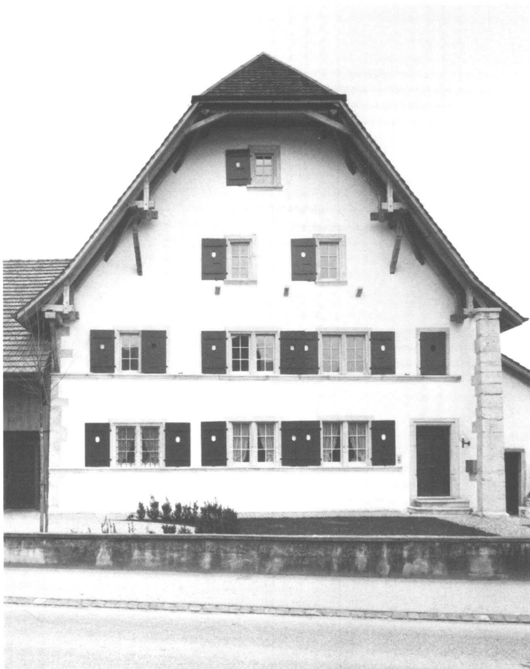
Neuendorf, Pflugerhaus. Der einzige auf Kantonsgebiet «erfundene» Haustypus ist das Gäuer Haus. Eines der schönsten Exemplare steht in Neuendorf. Es zeichnet sich aus durch Giebelständigkeit, fein bearbeitete Gewände aus Solothurner Stein und offenes Flugsparrenwerk. Letzteres wurde anlässlich der Restaurierung von seiner späteren Verkleidung befreit. Laut Familienchronik stammt das Pflugerhaus von 1696. Die ausgeprägten stilistischen Merkmale der Steinhauerarbeiten weisen jedoch in die erste Hälfte des 17. Jahrhunderts. Das Haus stand längere Zeit leer, bis einige Einheimische eine Aktiengesellschaft gründeten, das Haus übernahmen und restaurierten. Im Parterre wurde ein Café, in den Obergeschossen Wohnungen eingerichtet. Links oben: Steinerne Fensterstud in der vorderen Gaststube. Links oben rechts: Blattvolute von einem Gewände. Man beachte die in Stein gemeisselte Schraube. Links unten: Die hintere Gaststube. Oben: Die imposante Nordfassade.
