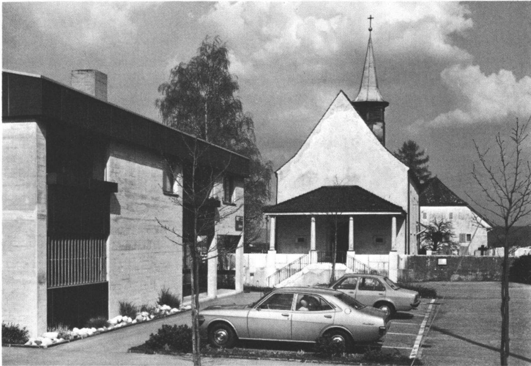
224 Starrkirch: Der Postneubau unmittelbar beim Kircheneingang – ein taktloser Nachbar!
