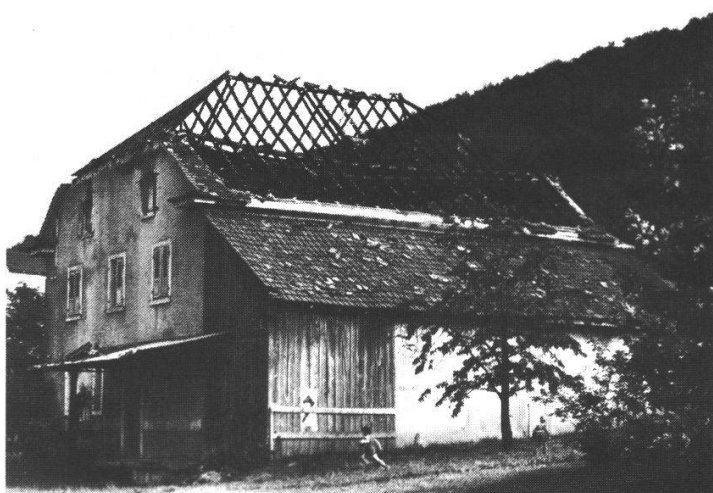
169 Bättwil: Ehem. Mühle. Auch der Brand muss nicht das Ende bedeuten. Noch ist ein Wiederaufbau sinnvoll und möglich
