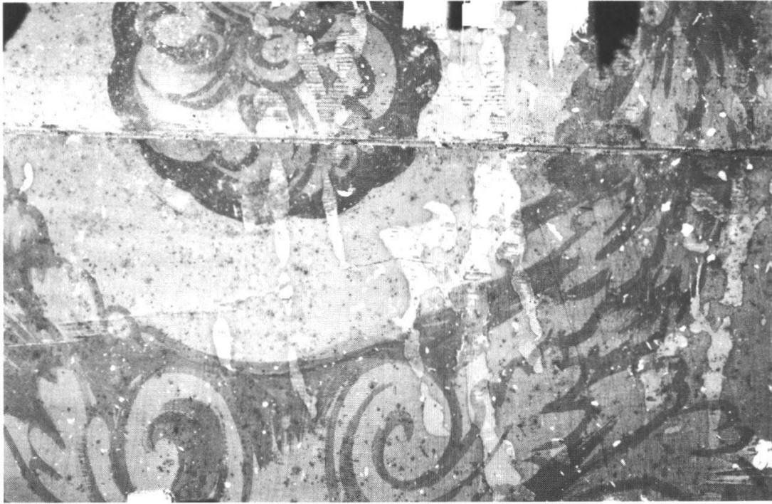
74 Solothurn: Gurzelngasse 20, Haus Fröhlich, jetzt Nordmann. Eines der schwungvollen Grisaille-Ornamente, die bei Sondierungen an den Gipsdecken zum Vorschein kamen
