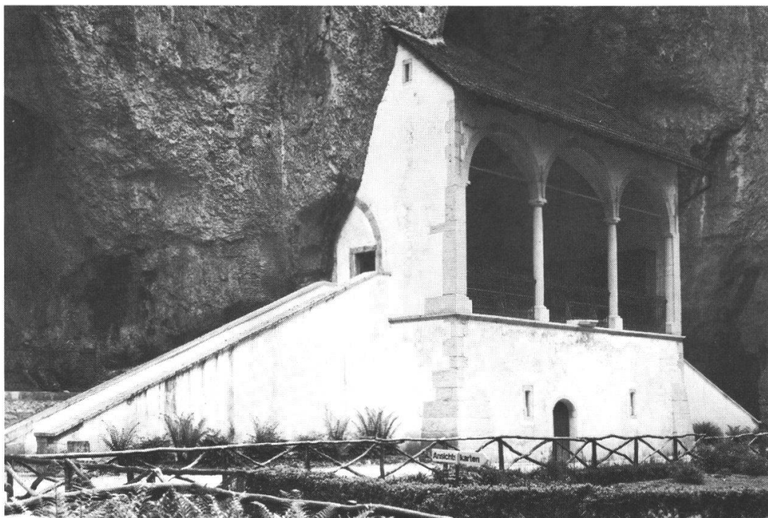
276 Rüttenen: Einsiedelei. Die aussen restaurierte St. Verena-Kapelle. Leider ist der Verputz schon fleckig
