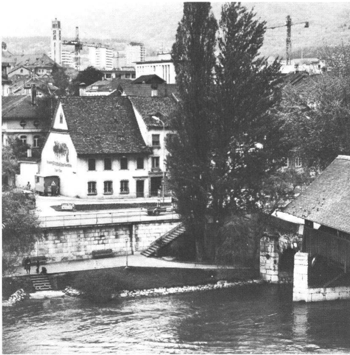
23 Olten: Feldschlösschen-Areal. Aufnahme von der Terrasse Zielempgasse 10. Rechts die Holzbrücke
