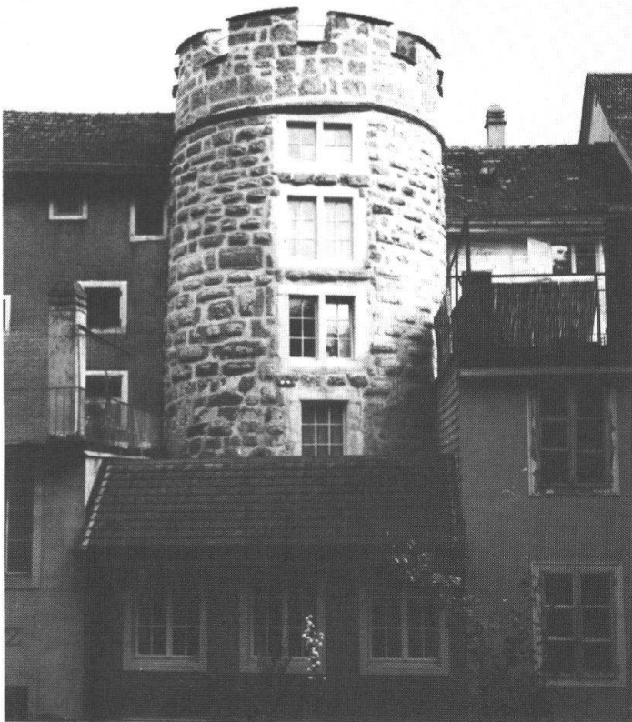
65 Solothurn: Mittelalterlicher Halbturm gegen den Burisgraben, wiederhergestellt mit dem Vorderhaus, St.Urbangasse 53
