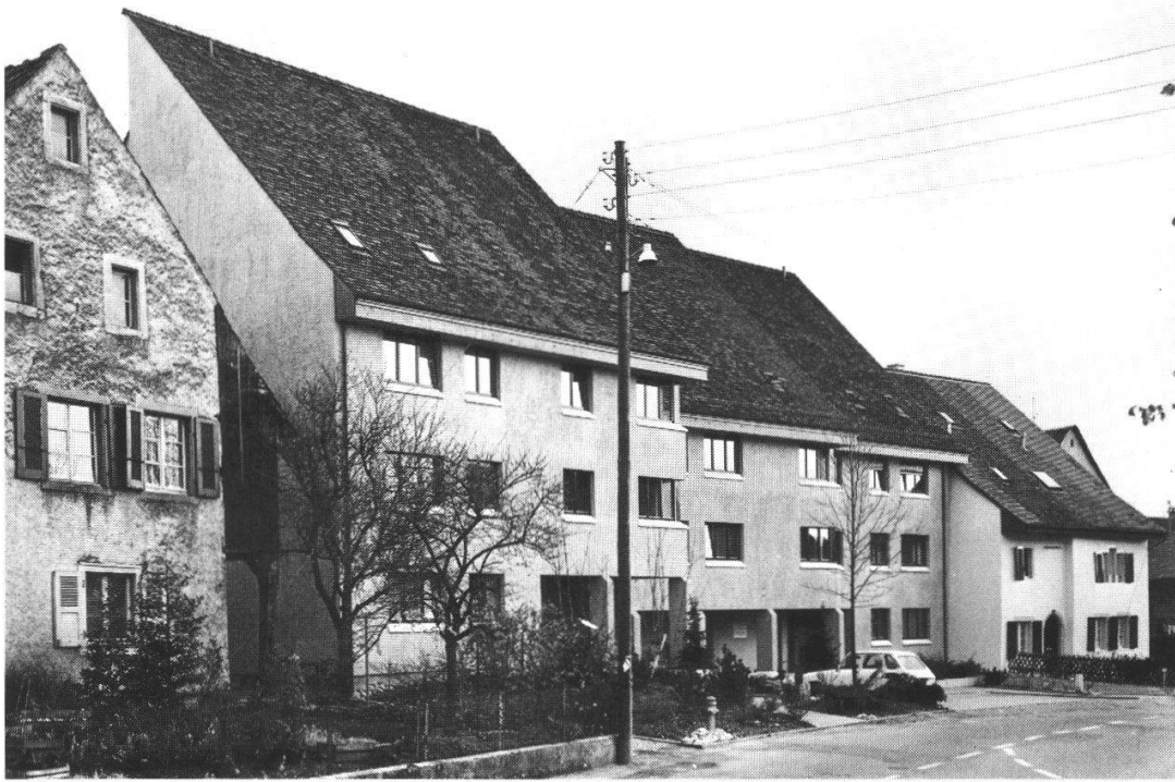
116 Dornach: Überbauung Unterdorfstrasse. Man spürt die Anstrengung, sich einzufügen. Rücksicht und Renditedenken lassen sich jedoch schwer miteinander in Einklang bringen
