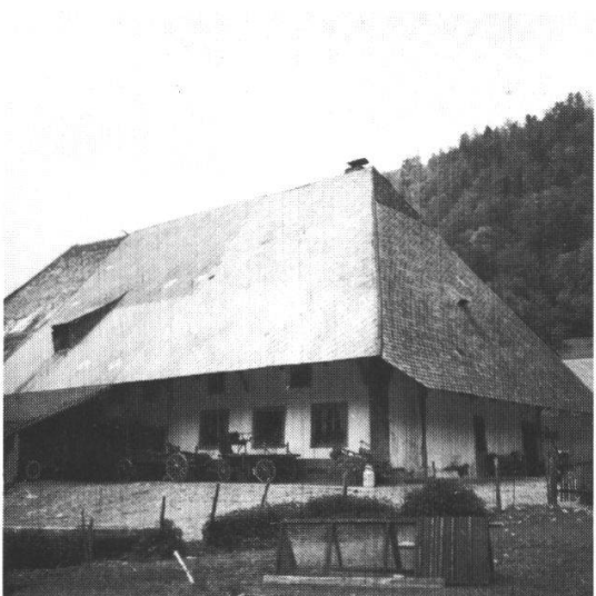
212 Hägendorf: Der Hof Spitalberg liegt leider im Gebiet des Militärschiessplatzes und muss verschwinden
