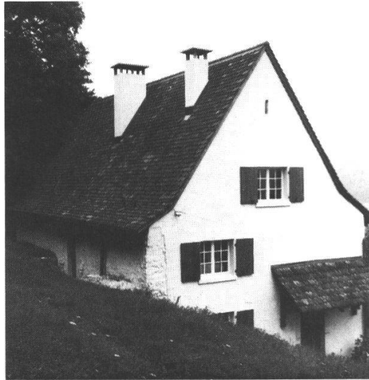
197 Das gleiche, schlichte Häuschen nach dem Umbau
