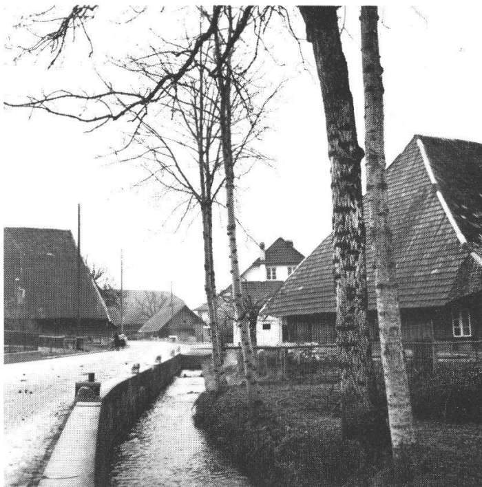
209 Derendingen: «Domherren»- und «Bifanghaus» im Oberdorf (links und rechts angeschnitten). Beides Hochstuhlhäuser von der ältesten Art. Niemand hatte die Courage, verbindlich dafür einzustehen, dass sie erhalten bleiben konnten.
