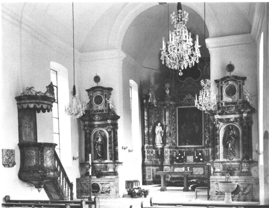
252 Holderbank: Pfarrkirche innen nach der Restaurierung. Die Seitenaltäre warten noch auf die alten Bilder, der Taufstein auf den stilgerechten Deckel
