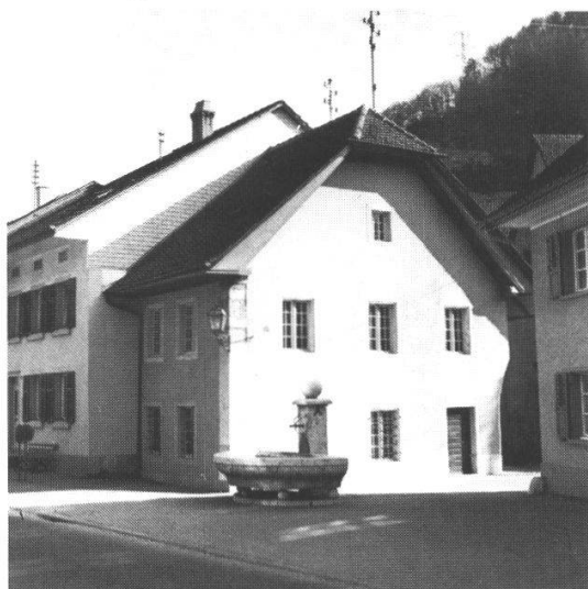
134 Balsthal-Klus: Altes Schulhaus von 1743 nach der Restaurierung; jetzt Bürgerarchiv
