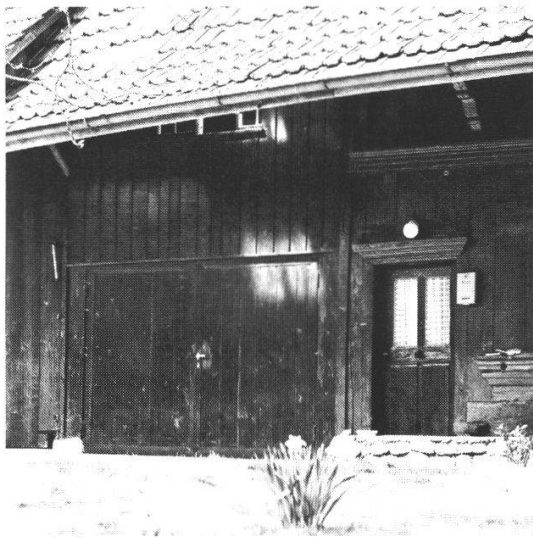
114 Biberist: Moosstrasse 12. Garage-Einbau in die Scheune, diskret, den Verhältnissen angepasst
