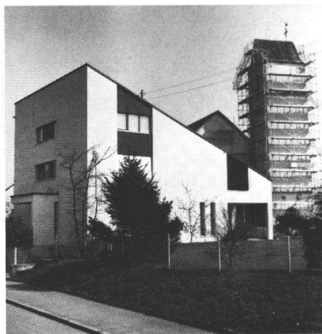
220 Obergösgen: Neues Pfarrhaus; hinten der Käsbsenturm der Kirche
