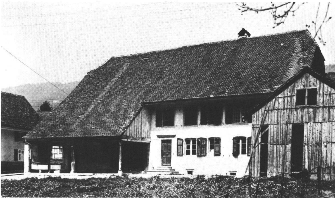
214 Matzendorf: Der Abbruch des Casimir-Meister-Hauses riss ein Loch ins Ortsbild. Es wurde ein Opfer parteipolitischer Machenschaften
