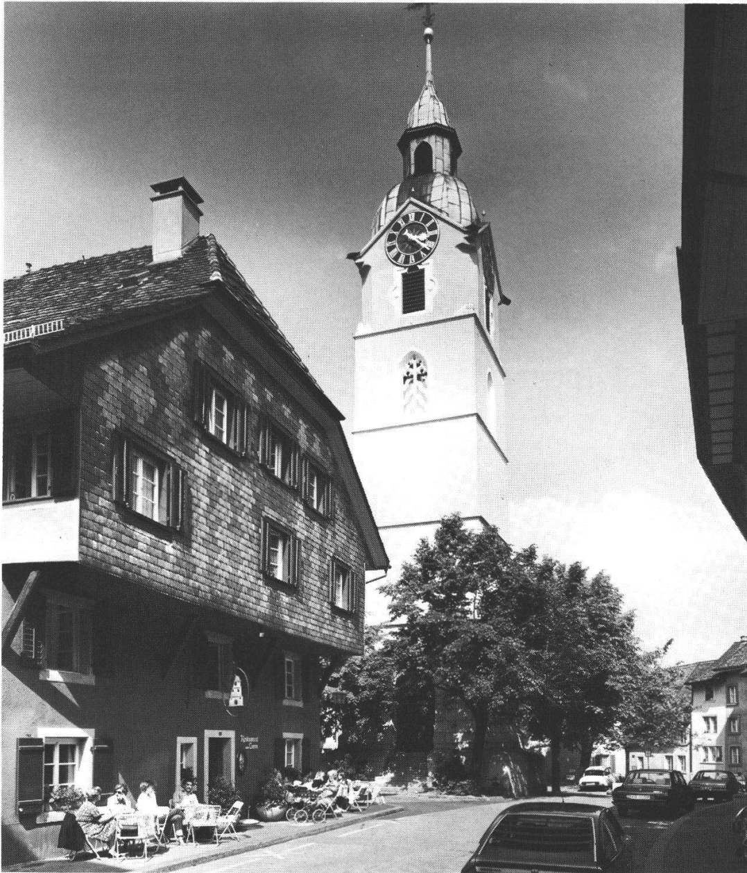
34 Olten: Stadtturm und Restaurant «Turm» nach der Restaurierung
