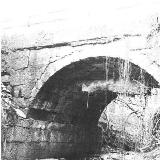
333 Hubersdorf: Natursteinbrücke über den Teuffelenweidbach
