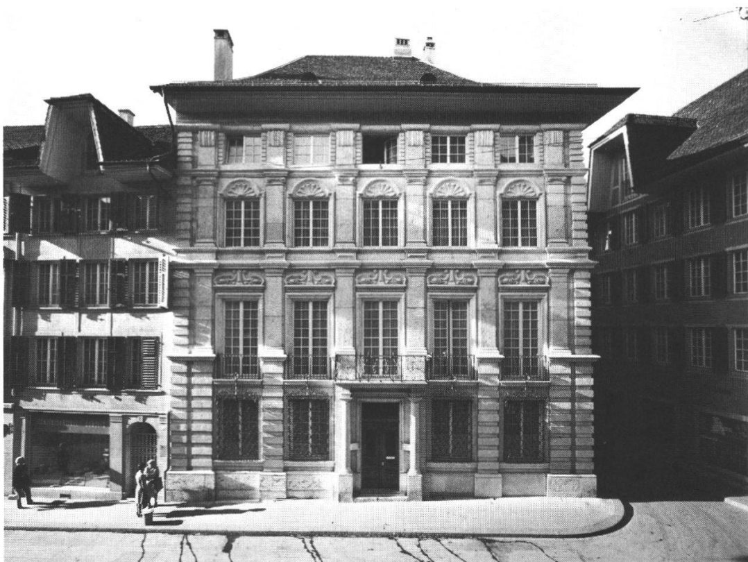
55 Solothurn: Haus Dr. Reinert, Gurzelgasse 11, nach der Restaurierung der Fassaden
