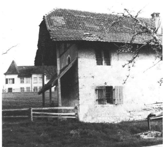
171 Biberist: Das «Heidenstöckli» beim Schlösschen Bleichenberg darf nicht verschwinden
