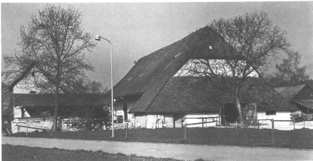
147 Feldbrunnen: Der Waldegghof von Osten nach den behutsamen Eingriffen und Erneuerungsarbeiten durch das kant. Hochbauamt
