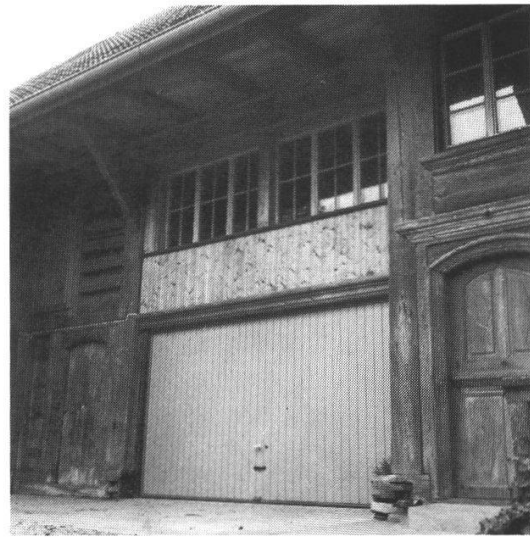
115 Gossliwil: Ein vorfabriziertes Kipp-tor ist hier fehl am Platz. Schade um das schöne Haus!
