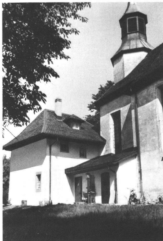
223 Solothurn: Das mit der Dreibeinkreuz-Kapelle zusammengebaute Kaplanenhäuschen
