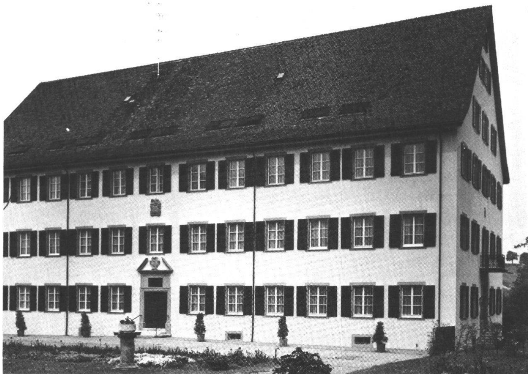
156 Mariastein: Ehemaliges Pilgerhaus «Kreuz» nach der Wiederherstellung des Äusseren
