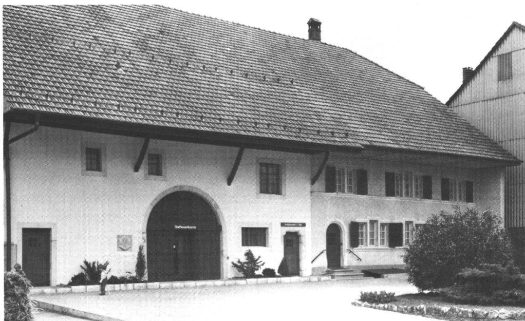
162 Niederbuchsiten: In die Scheune vom Bauernhaus Nr. 56 ist die Raiffeisenkasse eingezogen
