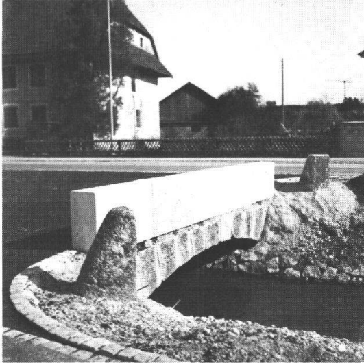
335 Neuendorf: Brücke beim Speicher. So geht es offensichtlich nicht
