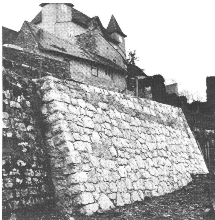
17 a Schloss Wartenfels. Verstärkte Stütz- mauer beim Garten des Pächterhauses
