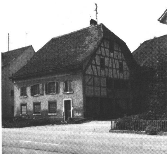
178 Hofstetten: Das Haus Haberthür, auf Abbruch gekauft, soll wieder sein altes Aussehen erhalten
