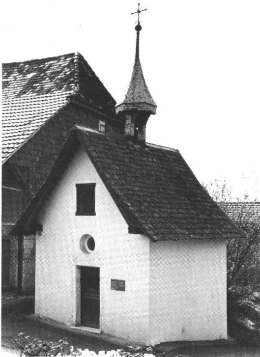
232 Bellach: Dreifaltigkeits-Kapelle nach der sorgfältigen Sanierung und Restaurierung durch die Gemeinde
