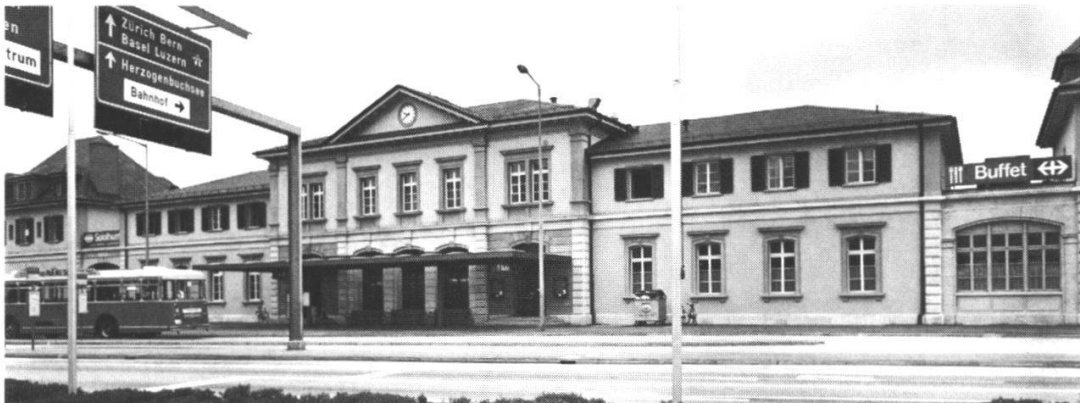
Solothurn: Hauptbahnhof vor und nach der Restaurierung
