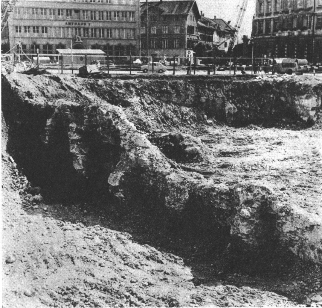
Die Schanzenmauer von Nordosten. Die Verstärkerpfeiler an der Innenseite der Mauer. Foto A.Havel.
