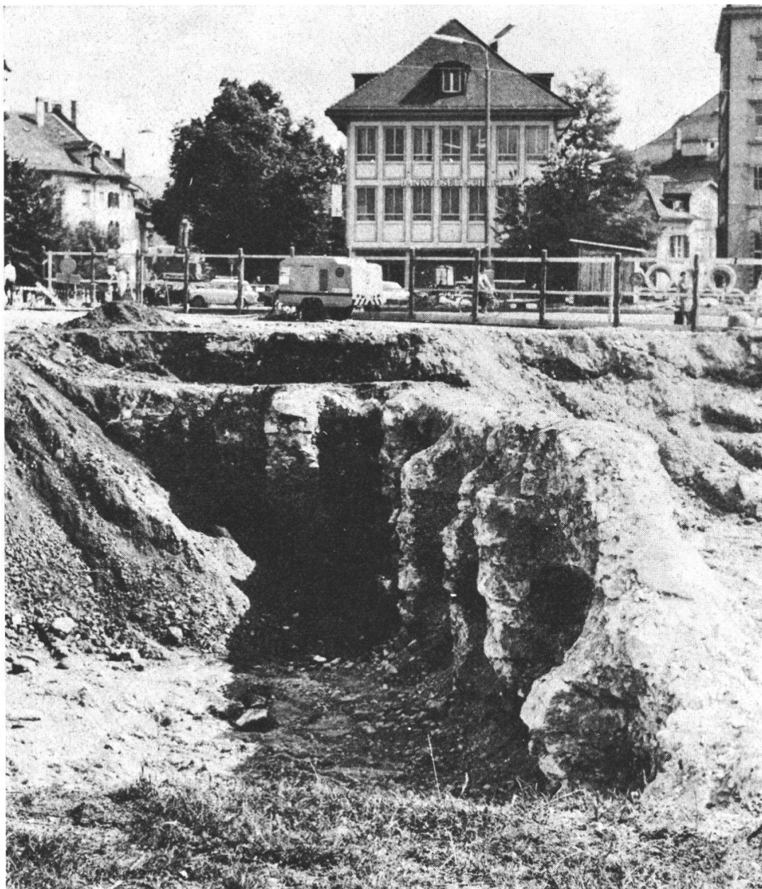
Ecke der Bastion. Innenseite mit Stütz Pfeilern. Foto A. Havel.
