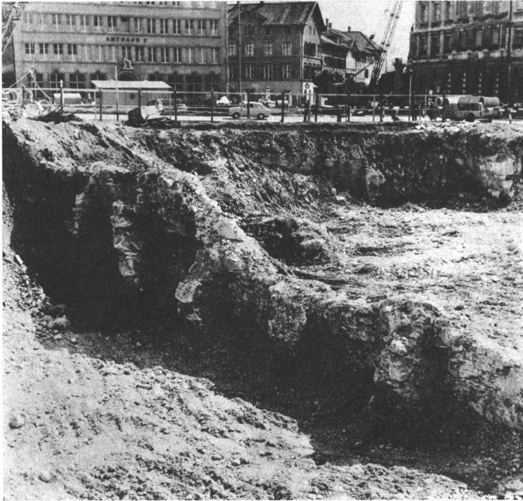
Die Schanzenmauer von Nordosten. Die Verstärkerpfeiler an der Innenseite der Mauer. Foto A.Havel.
